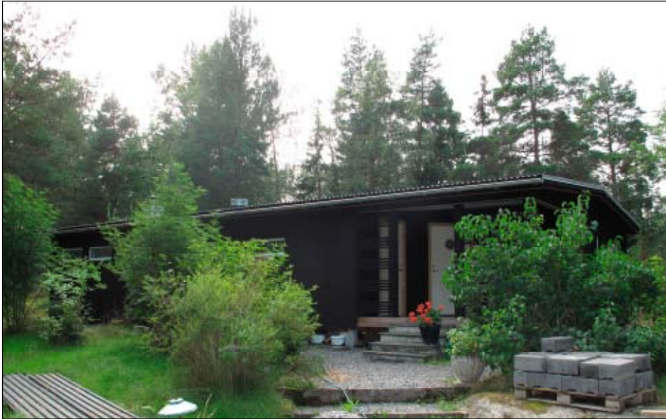
Kopparmoravilla. Renoveringen är i princip avslutad. Byggnadens nya utformning smälter in i helheten, men ser man på utförandet så följer det i stort några av de trender som idag råder inom nybyggnation; slammad svart panel, slitsfönster, flackt plåttak liksom vita snickerier. Lp20090518.
