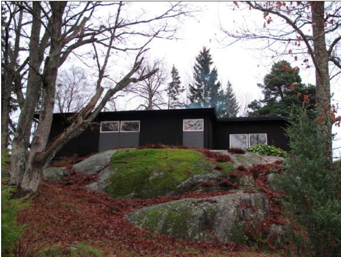
Nyrenoverad kopparmoravilla med ursprungskaraktären bevarad. Lp20100016.
