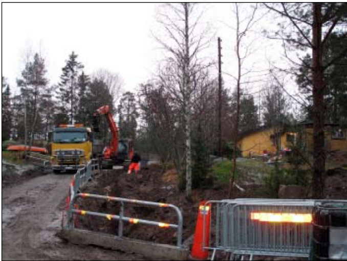
Grävning för vatten och avlopp i Norra Kopparmora hösten 2009. Lp2010060
