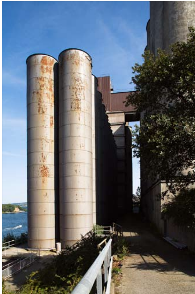
Den stora spannmåls- silon med utsikt över Stockholms inlopp. L.dng2008-0613
