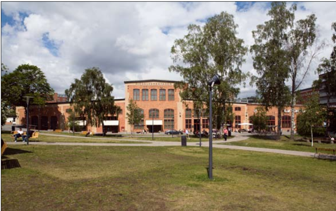
Området runt Marcusplatsen är av förklarliga skäl lättare att avläsa. Där finns en samlad industrimiljö med äldre byggnader som har tydliga ålderdomliga industridrag. Kanske kan det vara så att sekelskiftets industribyggnader har blivit norm för industriarkitektur i allmänhet, eftersom allt därefter under så lång tid har negligerats. Ldng2008-0226
