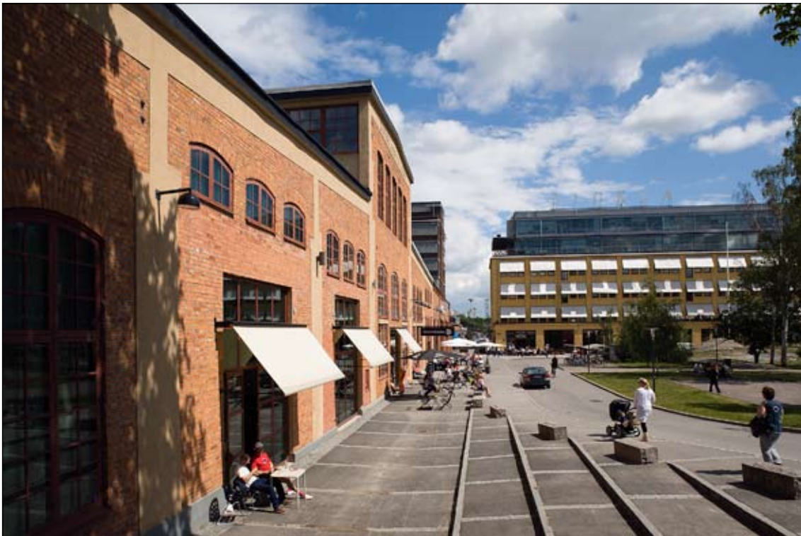
I profileringen av det nya området var en karaktärsbyggnad av central betydelse. Ett nytt landmärke skapades genom att bygga på den befintliga Luftverkstaden Ldng2008-0223
