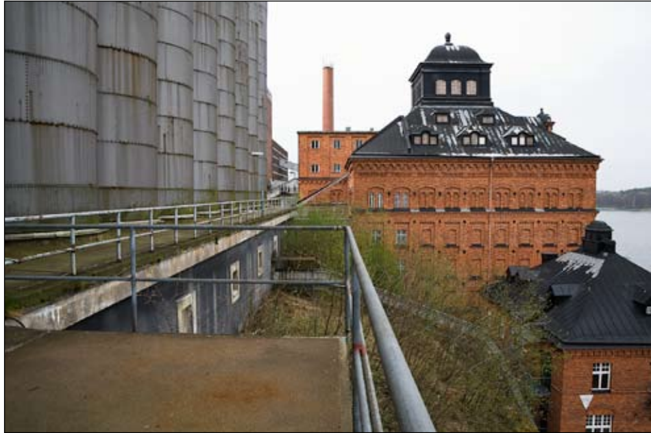
Modernistiska silorör i plåt möter traditionell tegelarkitektur. Ldng2008-0741
