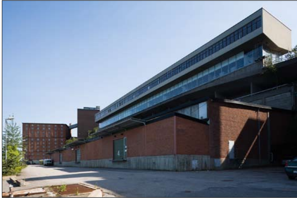
Det så kallade Munspelet. Industrins kontorsbyggnad uppfördes på 1960-talet och var då en fristående byggnad på pelare. Senare har pelarna byggts in med ett nedre våningsplan. Ldng2008-0601
