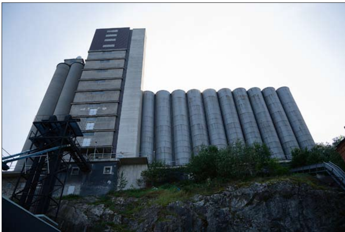
Spannmålsilon från 1920-talet ligger majestätiskt placerad högst upp på förkastningsbranten. Den har successivt byggts på med nya silorör. Ldng2008-0606
