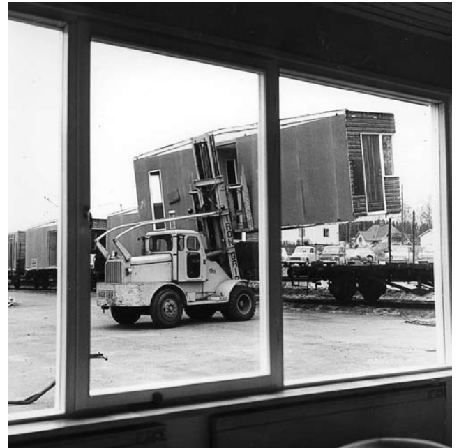
WP-villan tillverkades i sektioner som monterades ihop på byggsplatsen. Här lastas en sektion på en järnvägsvagn för vidare transport. Foto Pebr Hasselrot
