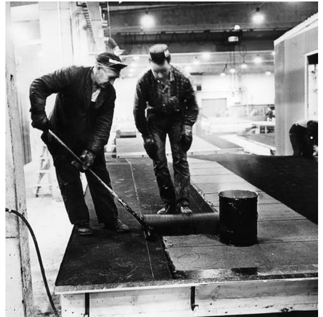
Taket täcks med papp. Foto Pebr Hasselrot
