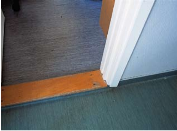
I några av husen hittar man spår från tidigare perioder. På bilden ser man de linoleumgolv som fanns i husen från början. Badrumsväggen är klädd med perstorpsplatta. Foto Elisabeth Boogh
