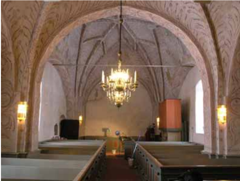
Långhuset åt väster efter avslutade arbeten. Bildbeteckning lp20050534. Foto Lisa Sundström.
