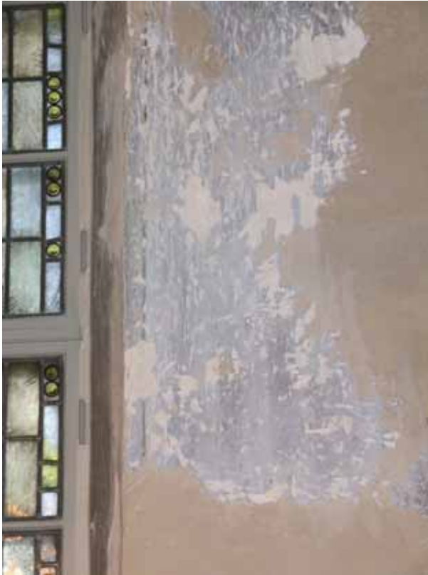
Över bröstningshöjd framkom en ljusblå färg med mörkare streckmarkering kring fönsterna. Bildbeteckning lp20050531. Foto Lisa Sundström.
