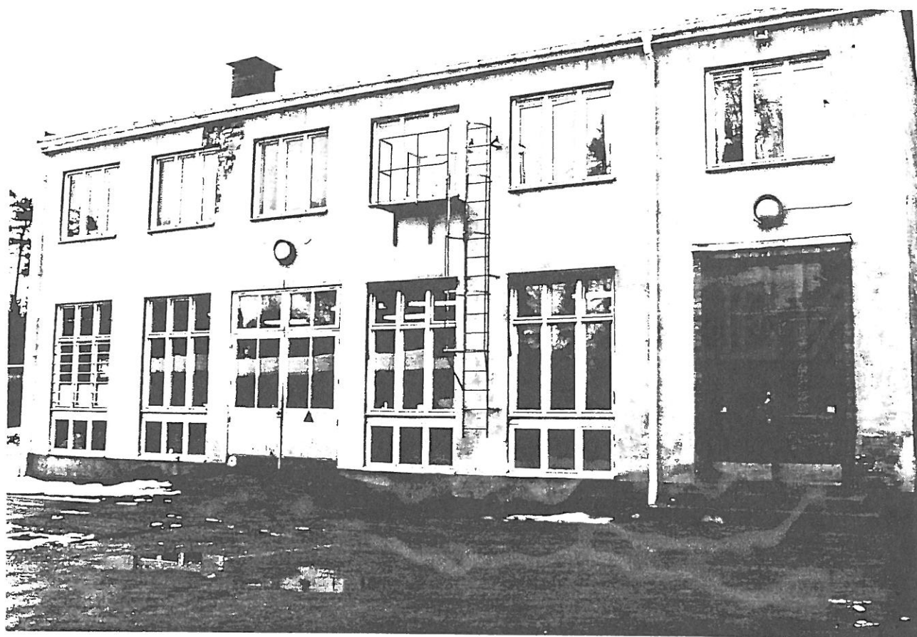
Den nya värmecentralet uppfördes under 1940-talet På 1 trappa förråds- och kontorsutrymmen. Foto Jan Granberg, LM88/92:2
