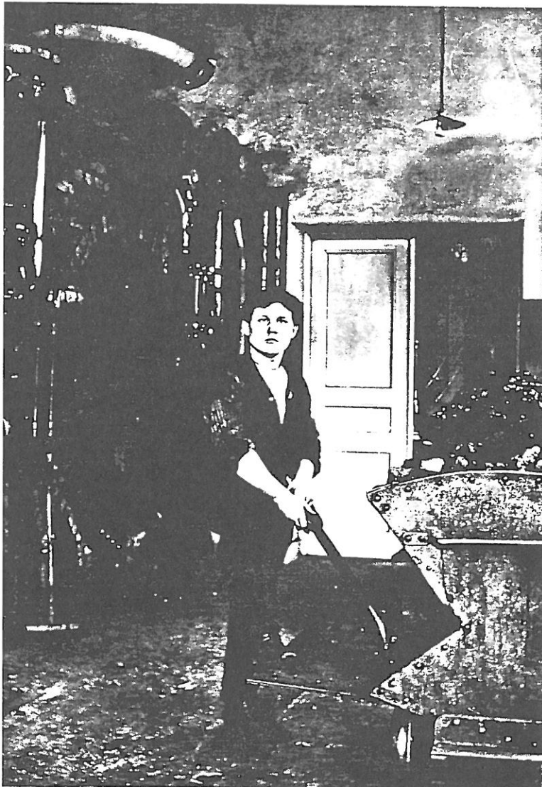
Eldaren Carl Gustaf Söderholm i ångpannehuset. På den andra bilden ser vi Söderholm några decennier senare då han avancerat till arbetsledare, sittande som andre man från höger. Längst till höger skymtar de råoljedrivna tändkulemotorerna och generatorerna och till vänster ser vi den för tiden typiska kontrollpanelen i vit marmor, repro LM88/84:4,5
