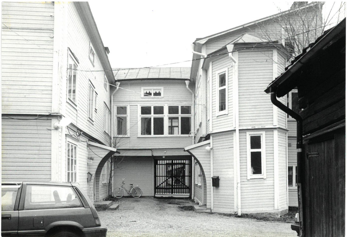
Fh Venus 2. Gårdsidan åt norr med trapphus.
