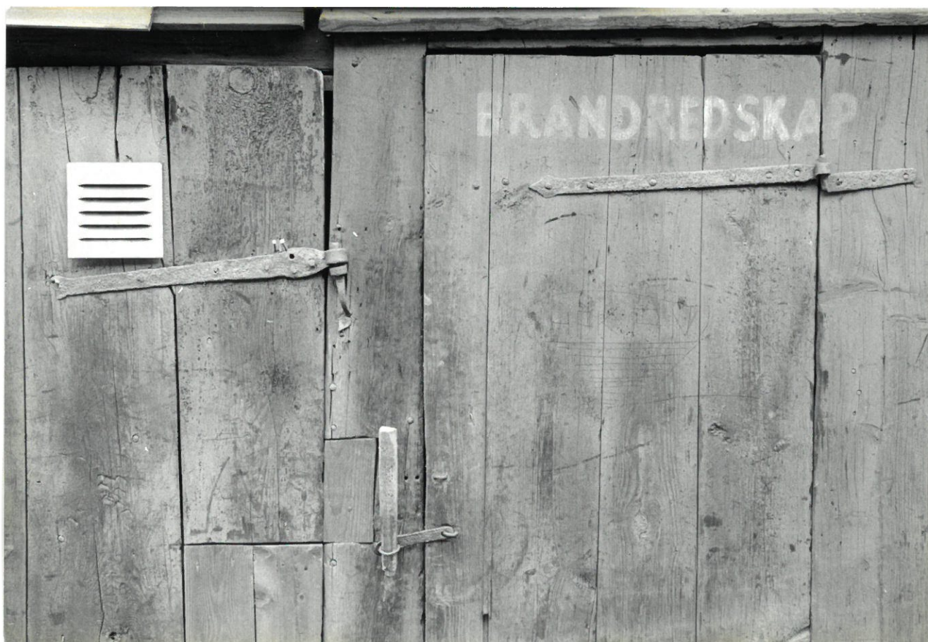
Hus nr 5. Plankdörrar
