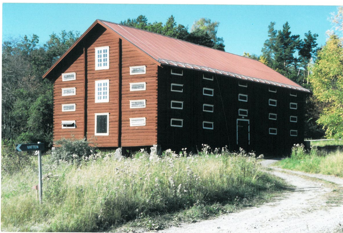
Magasin från 1700-talet på Sundby gård under upprustning.
