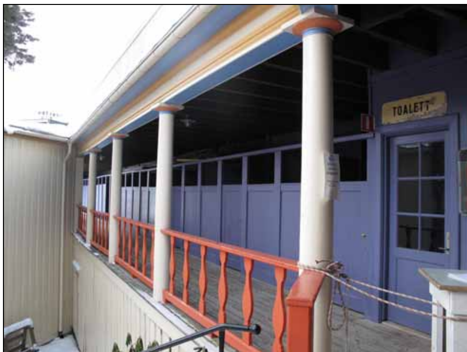
Bildbeteckning: Lp 2010-0074. Herrbadet efter renovering. Foto från sydost. Foto: Niss Maria Legars, 2010.
