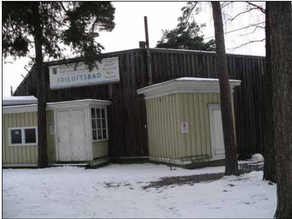
Bildbeteckning: Lp2006-0387. Herrbadet före arbetena. Foto från nordväst. Foto: Kersti Lilja 2006.
