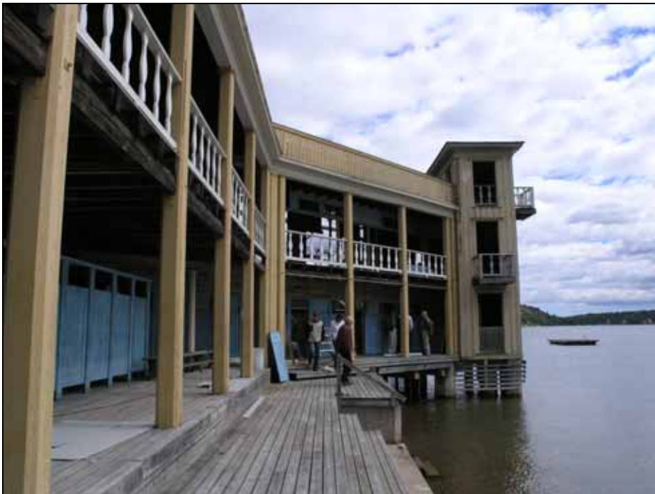
Bildbeteckning: Lp2006-0390. Herrbadet under arbetena. Foto från väster. Foto: Kersti Lilja 2006.
