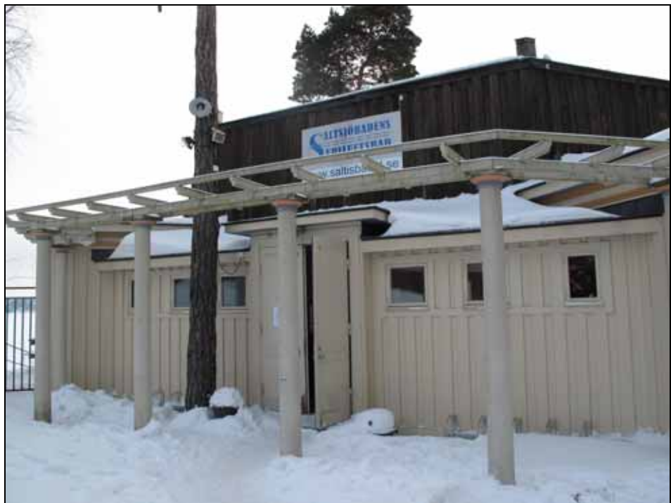
Bildbeteckning: Lp2010-0070. Herrbadet efter renovering. Foto från nordväst. Foto: Niss Maria Legars 2010.
