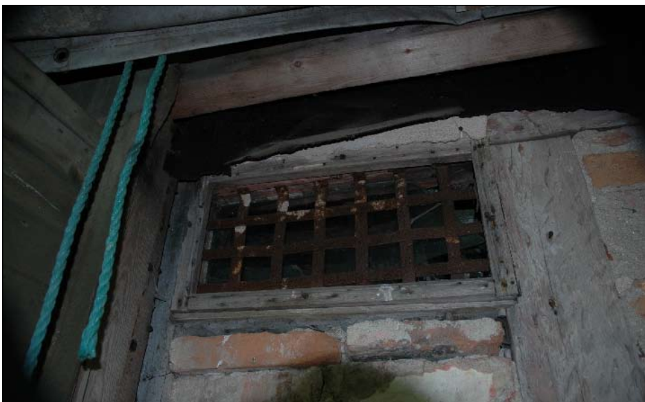
Fönster korsvirkesdel fr. ö.
