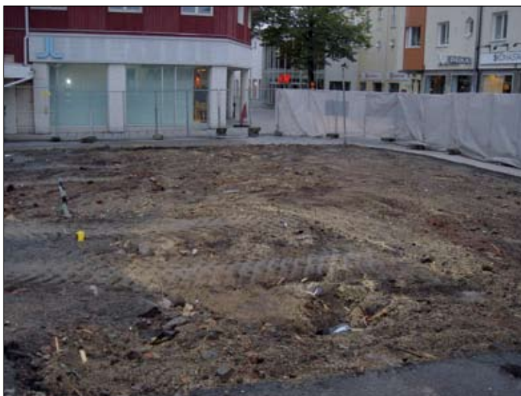
Fig 7. Platsen för Dejvanhuset efter dess rivning. Foto K. Andersson. SSLM bildnr lp20070060.
