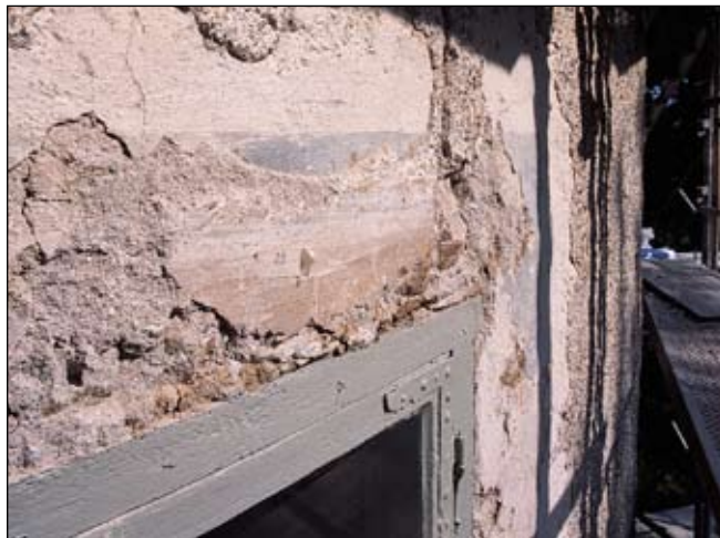
Fig 35. Fönster BV 3 i Sjötorneret, grå markering. Bildnr: ld20020134.
