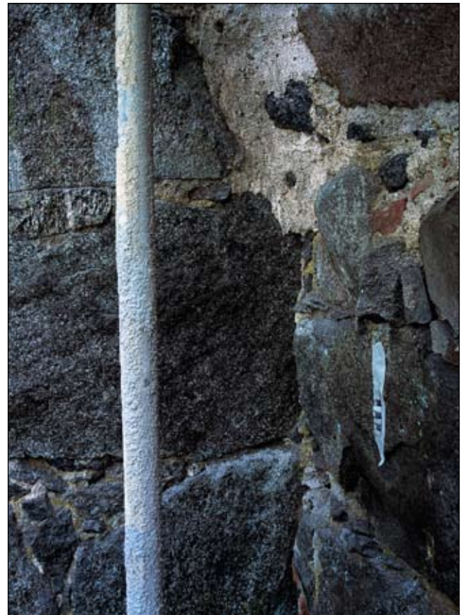
Fig 16. Hörn i sockel mot N mellan stenhuset och Sjötornet är inte murad i förband i nedersta skiften. Bildnr: ld20020115.
