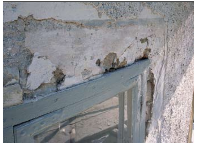
Fig 36. Fönster BV i Sjötorneret med grå omfattning bögre ovanför fönstret. Bildnr: ld20020135.
