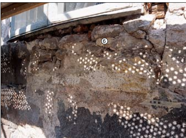
Fig 21. Fönster BV 2 i Sjötoronet, ursprunglig muröppning, ändrad håltagning. Prov 6 = fogbruk (se ritning, Penningby slott, Rapport över utförd murverksdokumentation, Jönsson 2003). Bildnr: ld20020120.
