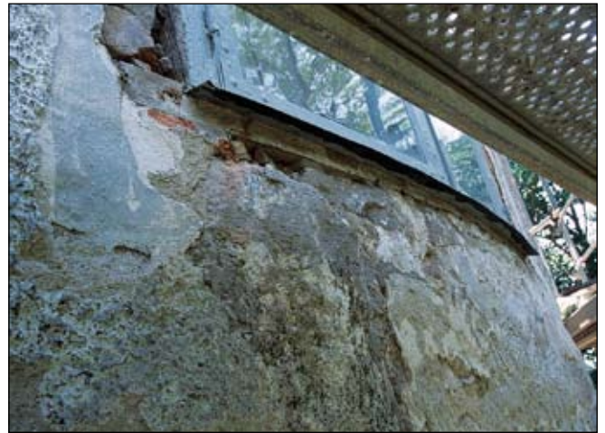
Fig 24. Fönster BV 4 i Sjötoronet, lagning i V. Vit puts med slät, grå markering runt fönster samt konturdragning under den grå markeringen. Bildnr: ld20020123.
