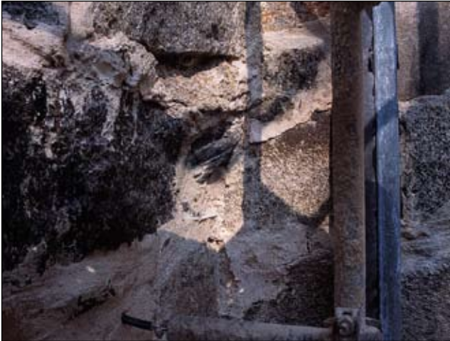
Fig 17. Hörn i SO mellan Sjötoronet och stenhuset är murat i förband. Läge = 2: a bomlaget nerifrån. Bildnr: ld20020116.
