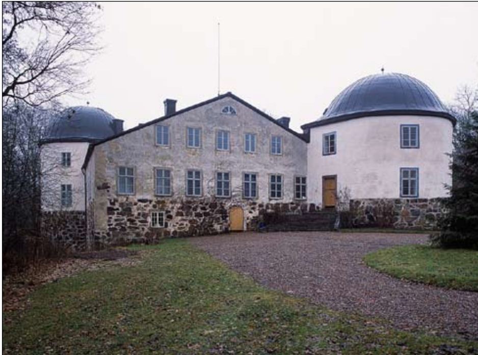
Fig 35. Penningby slott efter restaurering av Sjötoronet och Landtornet. Fasader mot Ö. Bildnr: ld20020254.
