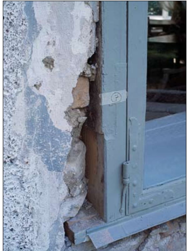
Fig 30. Fönster BV 5 i Sjötoronet, gråkalkad markering runt fönster period 4, spritputs period 5. Prov 7. Bildnr: ld20020129.
