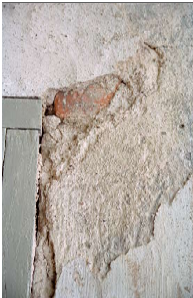
Fig 7. Mjukt böljande spritputs (period 4) utan synlig ballast. Detta putslager utgjorde referens inför omputsningen av Landtornet Resultatet efter omputsningen avviker genom att inte vara lika mjukt böljande utan mera likna strukturen på spritputsen från period 5. Bildnr:lp20070161.
