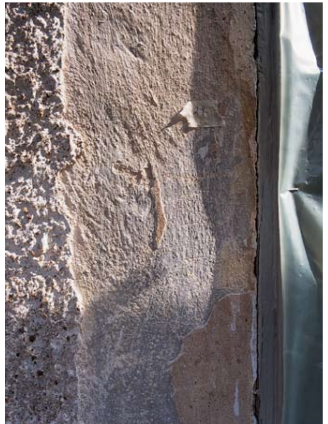
Fig 29. Fönster ÖV 4 i Sjötoronet visar guldockra på grå omfattning. Bildnr: ld20020138.
