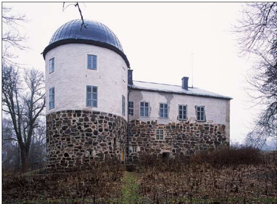
Fig 38. Penningby slott efter restaurering av Sjötorner. Fasader mot S. Bildnr: ld20020255.
