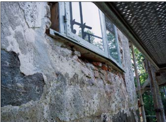
Fig 25. Fönster BV 5 i Sjötoronet, vit spritputs med slät markering, därunder slätputs med slät, grå markering. Bildnr: ld20020124.
