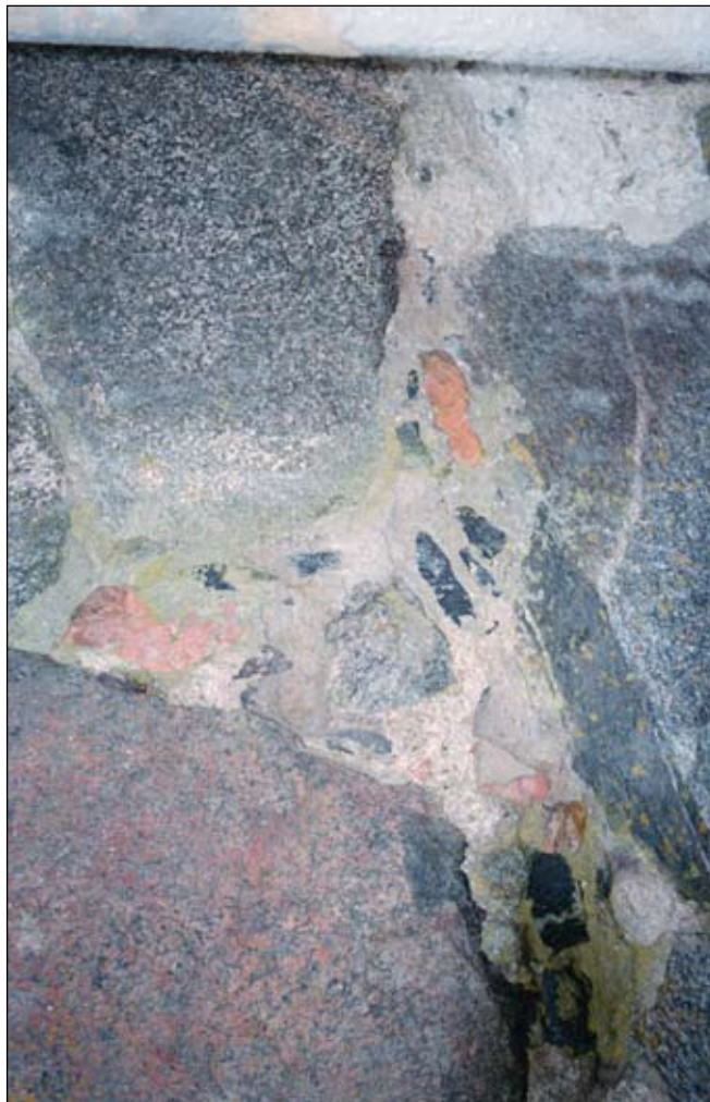
Fig 4. Sockel i natur- stenmurad med skolsten och tegel samt fogad med utstruket fogbruk. Markerad gräns mot fasadputs. Bildnr: lp20070160.
