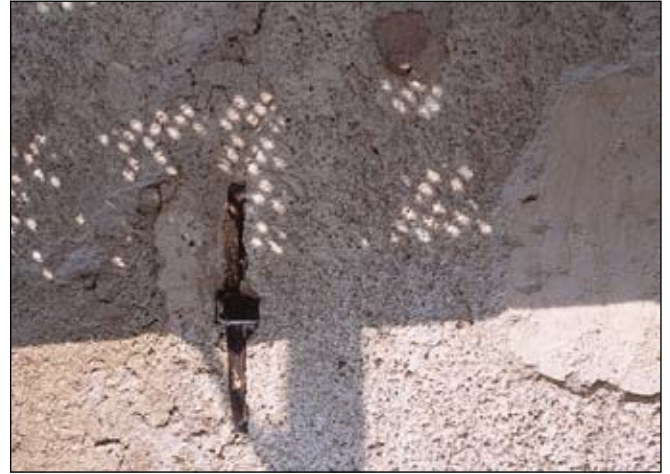
Fig 34. Ankarjärn med omtag ovanför fönster BV 2 i Sjötorneret. Bildnr: ld20020133.
