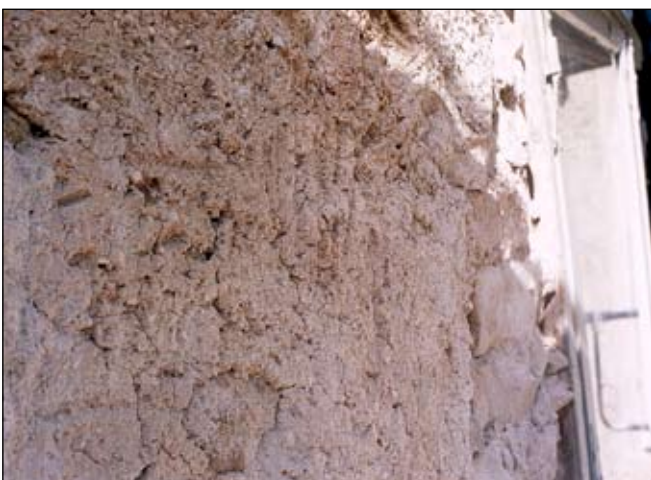
Fig 27. Sjötoronet. Lerhaltigt puts skikt, period 2, med spår efter verktyg diagonalt och vertikalt samt av röd färg. Bildnr: ld20020126.
