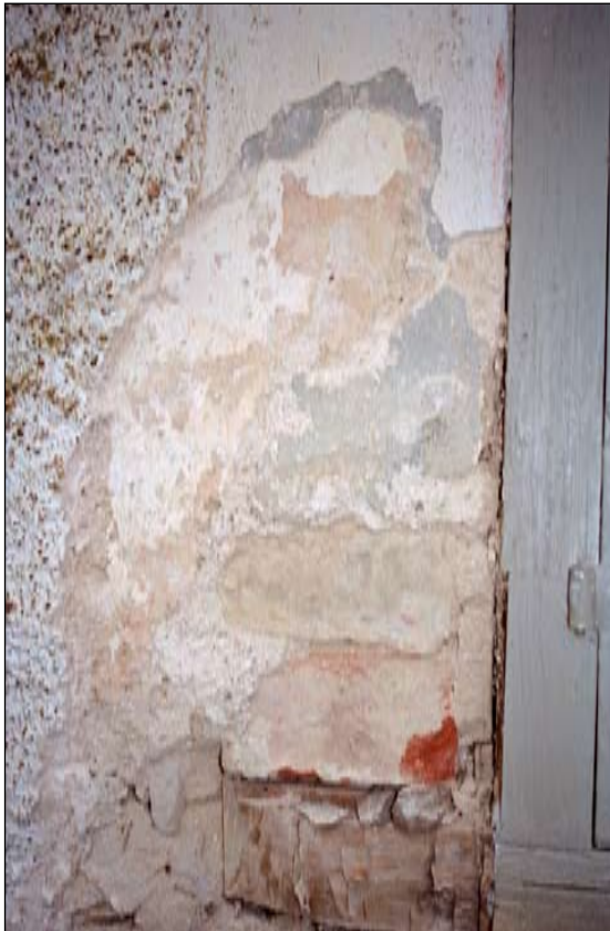
Fig 1. Nedre del av fönsterkarm med horn. Yttersta lagret, spritputs (period 5) med synlig ballast och slät omfattning, allt avfärgat i vitt. Spritputs i svagt gulrosa färgton (period 4) med slät omfattning i grått. Bildnr: lp20070157.
