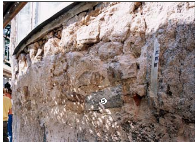
Fig 20. Fönster BV 1 i Sjötoronet, ändrad håltagning i murverk. Prov 5 = fogbruk. Bildnr: ld20020119.
