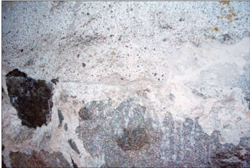
Fig 3. Markerad gräns mellan sockel i natursten och fasadputs före omputsning.. Bildnr:lp20070159.
