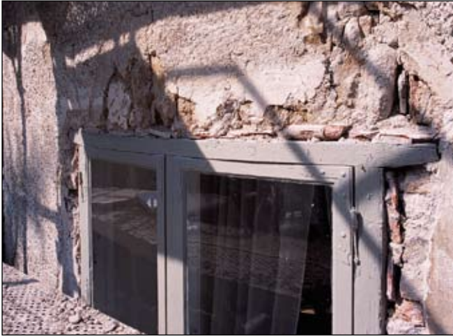
Fig 33. Överkant fönster i Sjötorneret. Bildnr: ld20020132.
