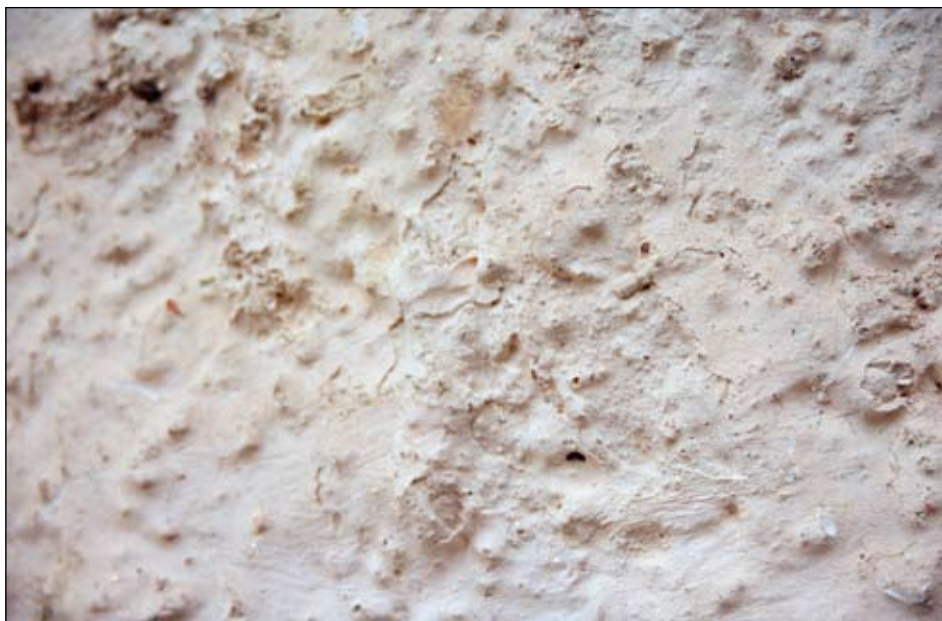
Fig 7. Mjukt böljande spritputs (period 4) utan synlig ballast. Detta putslager utgjorde referens inför omputsningen av Landtornet Resultatet efter omputsningen avviker genom att inte vara lika mjukt böljande utan mera likna strukturen på spritputsen från period 5. Bildnr:lp20070161.
