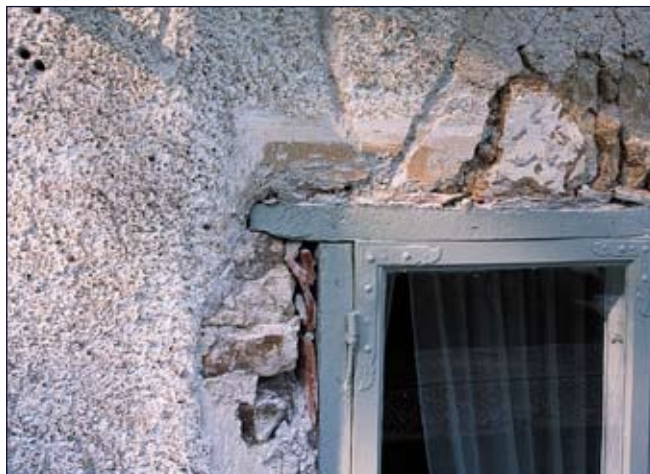
Fig 33. Överkant fönster med synligt horn, Sjötorneret. Bildnr: ld20020144.
