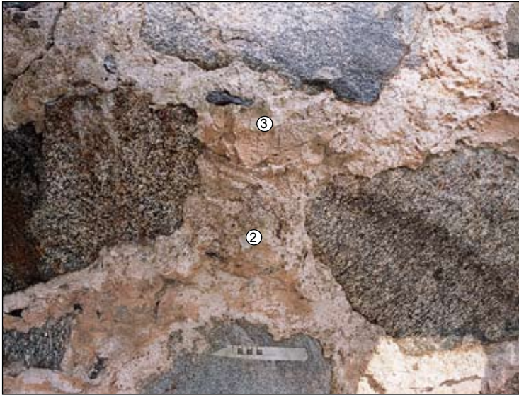
Fig 13. Puts på fogbruk i Sjötornets sockel. Prov 2 = period 4, prov 3 = period 5. Bildnr: ld20020112.
