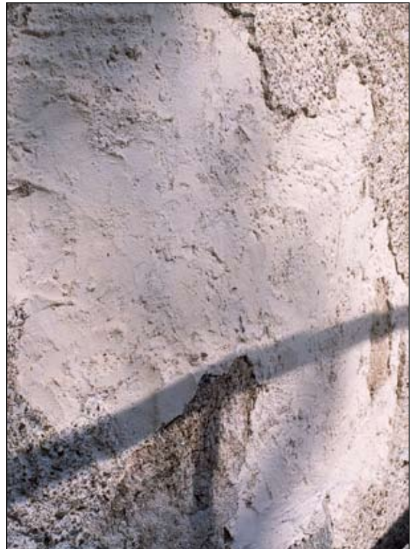
Fig 30. Fönster BV 5 i Sjötoronet, gråkalkad markering runt fönster period 4, spritputs period 5. Prov 7. Bildnr: ld20020129.
