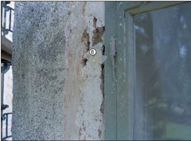
Fig 29. Fönster BV 4 i Sjötoronet, omfattning period 2 sönderbruten. Nuvarande fönster insatt i ett lerbruk överputsat med vitt (period 3), däröver grå markering (period 4). Prov 8. Bildnr: ld20020128.
