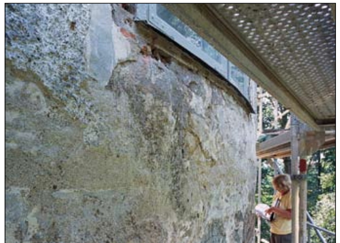
Fig 26. Fönster BV 4 i Sjötoronet. Ursprunglig glugg, (ev. skottglugg) igensatt. Bildnr: ld20020125.
