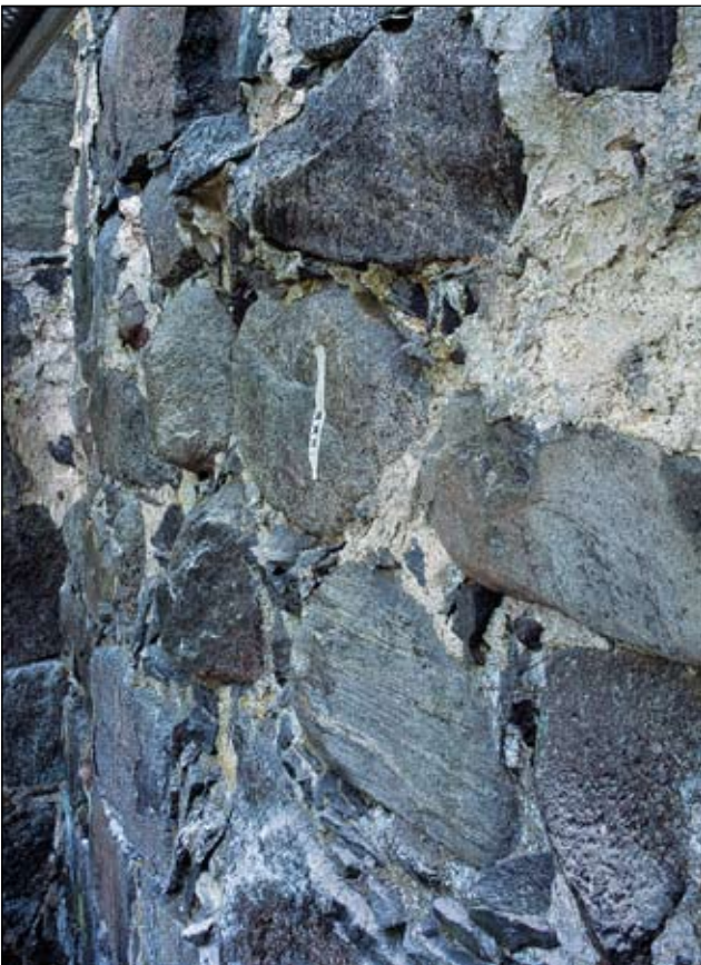
Fig 15. Ursprungliga fogar med skärvsten (period 1) i Sjötornets sockel mot N. Bildnr: ld20020114.
