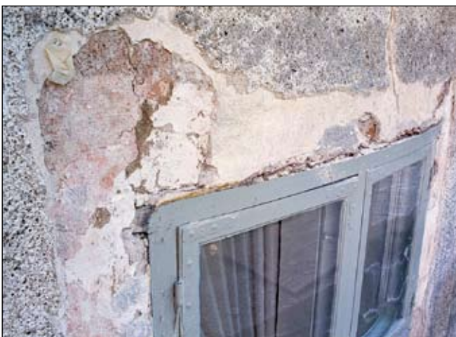
Fig 37. Fönster BV 5 i Sjötorneret, ovankant slätputs – period 3. Möte slätputs – skrovlig putsyta period 2. Bilden visar att tidigare fönster satt i samma höjdläge. Bildnr: ld20020136.
