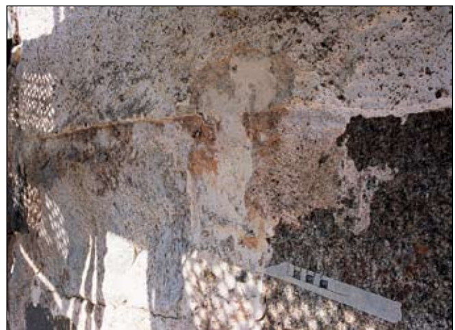
Fig 22. I putsen markerad övergång mellan sockel och fasadputs på Sjötoronet. Bildnr: ld20020121.
