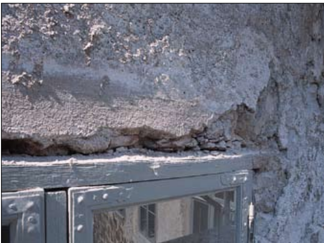
Fig 31. Överkant fönster i Sjötoronet. Bildnr: ld20020131.
