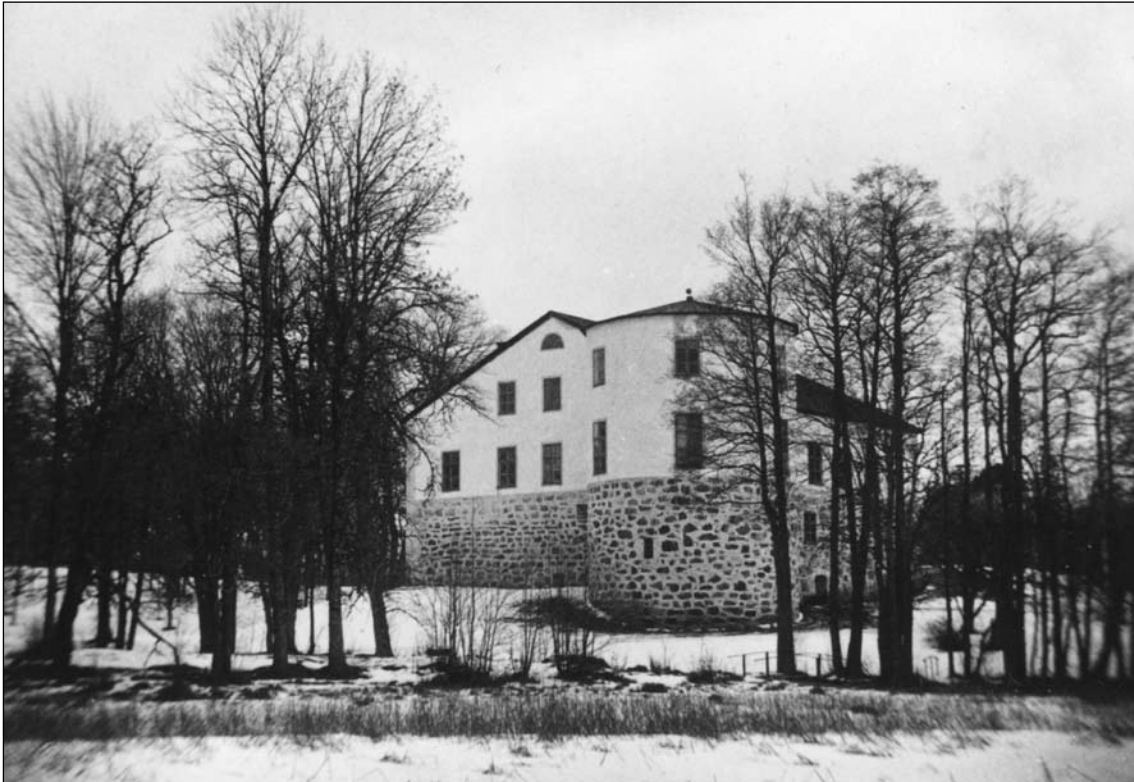
Penningby slott sett från sydväst, 1870-tal. Observera de två broarna (nertill th i bilden) över den s.k. vallgraven, då vattenfylld. Den ena bron är bågformad, den andra plan. Fotografen okänd.
