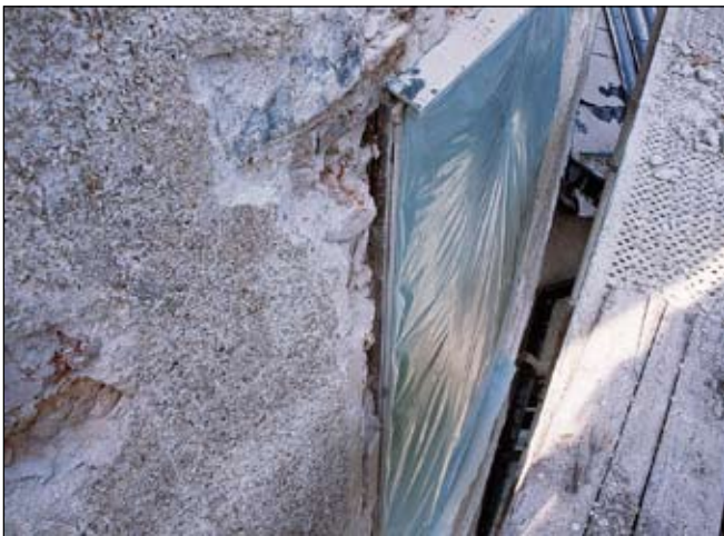
Fig 30. Markering, period 2, runt fönster i Sjötoronet, dragen med ett fint verktyg, eventuellt borstad. Bildnr: ld20020139.
