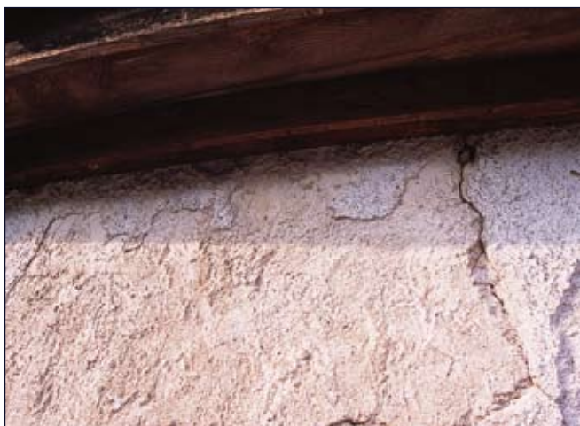
Fig 34. Puts under taknock på Sjötorneret. Vertikal spricka. Bildnr: ld20020145.
