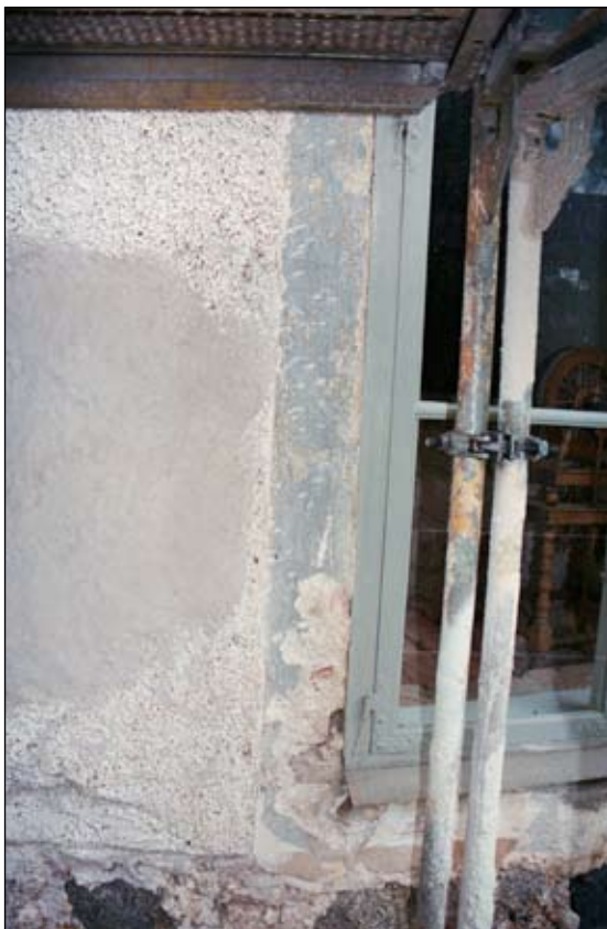
Fig 2. Fönster i BV i gräns mellan sockel och fasadputs. Slät omfattning (period 4) i grå avfärgning. Bildnr: lp20070158.
