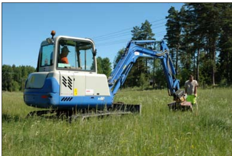
Fig 3. Maskinschaktning på de lägre liggande partierna. Foto R Grönwall, bild nr LP 20070098.
