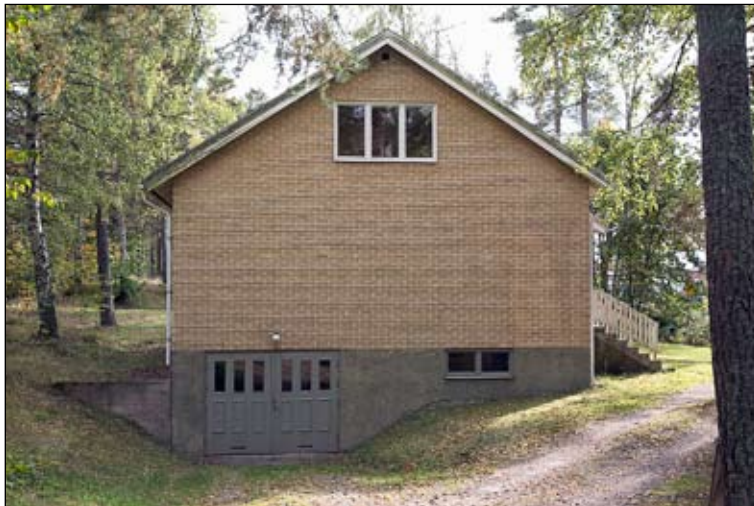
Fig 6:7. Fasad mot norr med garageportar i källarvåningen. Bildnr ldn20070679.
