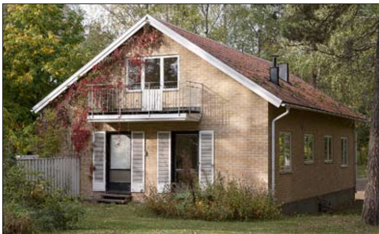
Fig 6:8. Södra gaveln med balkong på övervåningen och terrass på bottenvåningen. Bildnr ldn20070681.
