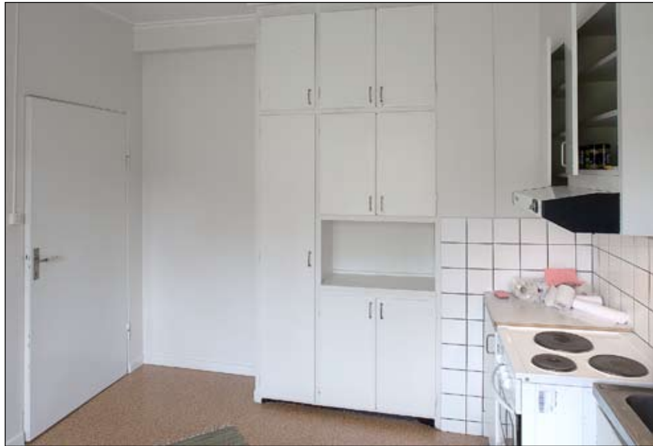
Fig 1:16. Kök (104) med ursprunglig skåpstomme bevarad på bortre väggen. Bredvid skåpen fanns tidigare en dörr till vardagsrummet (103). Dörren t.v. leder till hallen (101). Bildnr lng20070487.
