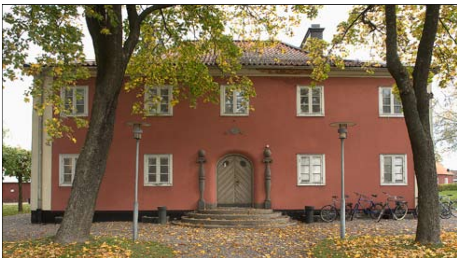
Fig 4:1. Ungkarlshotellets fasad mot väster, 2007. Bildnr lmg20070652.
