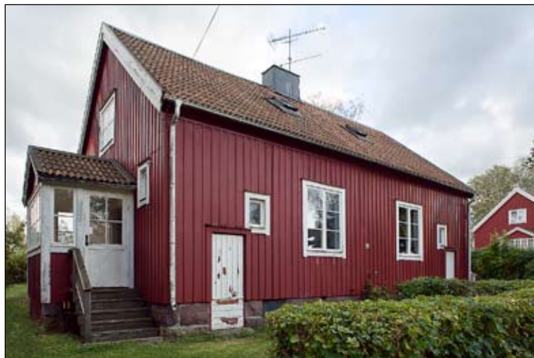
Fig 1:13. Exteriör 2007, Holländarevägen 6. Fasad mot gata åt nordväst. Bildnr ldng20070495.
