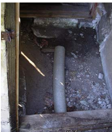
Dräneringsröret leder in i källaren.
