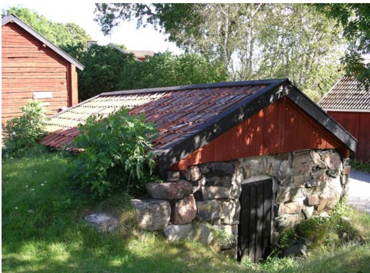
Sly växer nära byggnaden.
