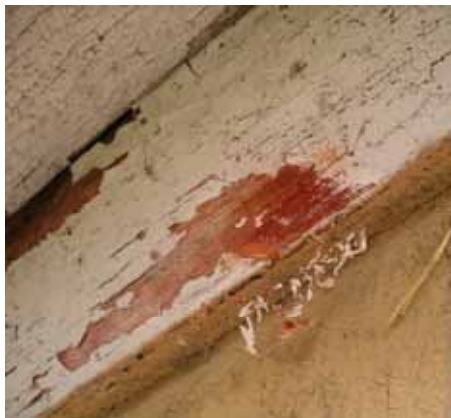
Ill. 29. Listen mellan fasaden och taket
