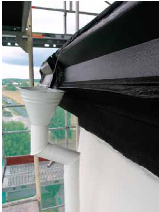
Stuprör med skarpa vinklar och konisk tratt. Foto Cecilia Pantzar 2007. Bildbeteckning lp20070151.
