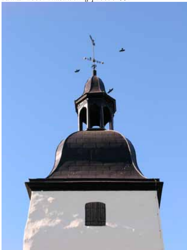
Torntakets nya siluett från öster, efter tillägg av fotränna. Foto Cecilia Pantzar 2007. Bildbeteckning lp20070156.
