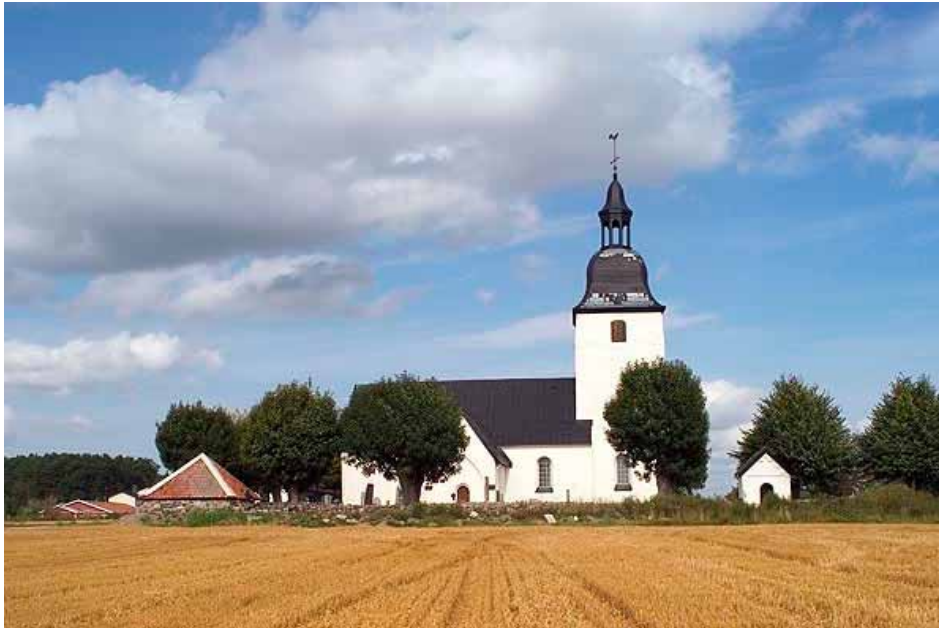
Färentuna kyrka från söder före restaurering. Lägg märke till att tornkretsens svarta färg är bortfallen på stora partier. Fotograf Anna Ulfstrand 2004. LX 2004-1401.
