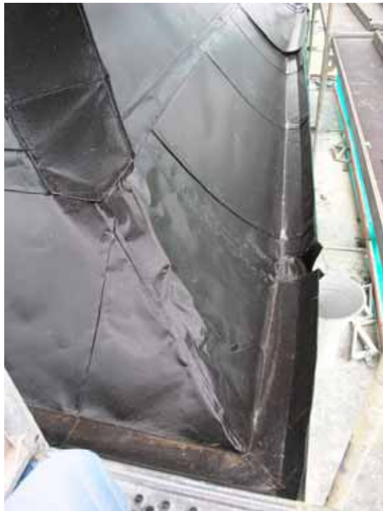
Tornets västra takfall med fotränna och ny anslutande skivplåt. Foto Cecilia Pantzar 2007. Bildbeteckning lp20070152.
