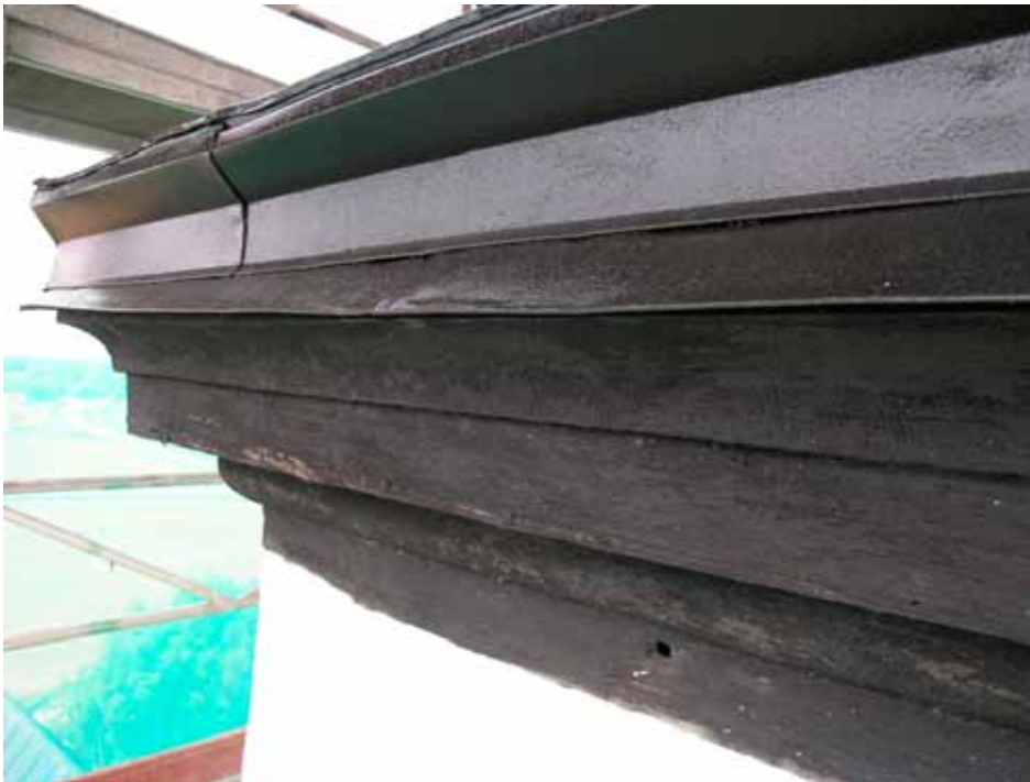
Tornets takfot med listverk av trä och den tillagda fotrännans utsida. Foto Cecilia Pantzar 2007. Bildbeteckning lp20070154.
