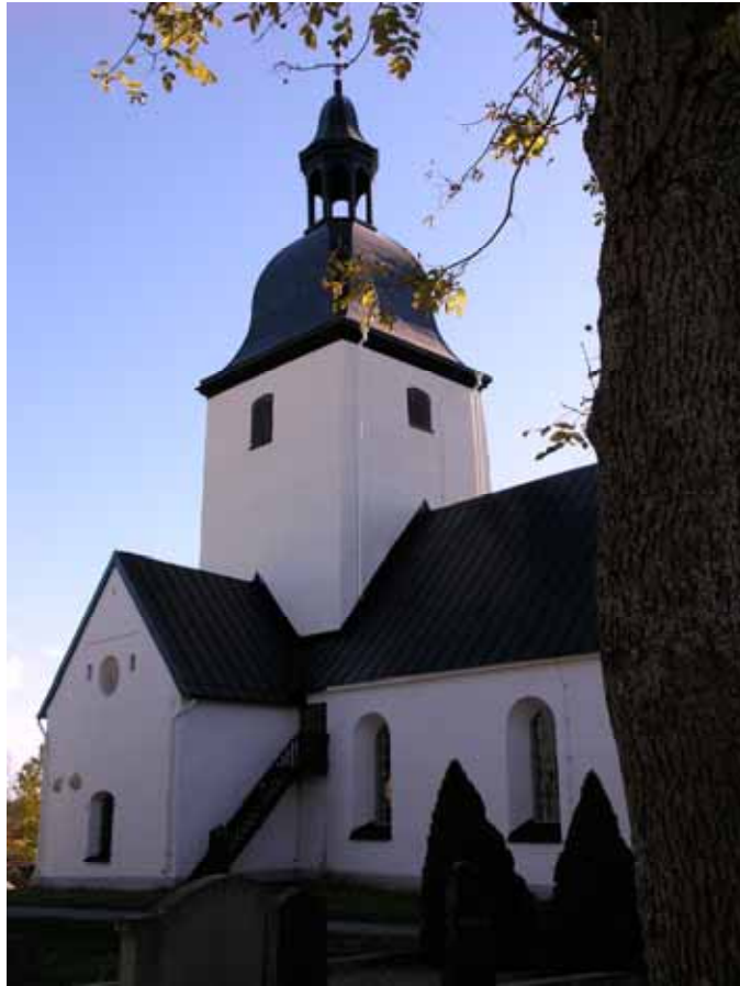
Färentuna kyrka efter restaurering av tornet. Lägg märke till torntakets fotrännor och stuprören utmed tornets västra fasad. Foto Cecilia Pantzar 2007. Bildbeteckning lp 20070149.
