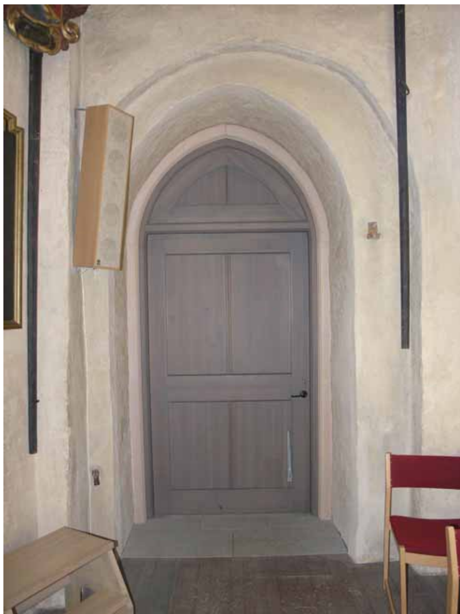
Sydportalens nya dörr interiört. Ny golvbeläggning har lagts innanför dörren av grovhyvlad kalksten.
