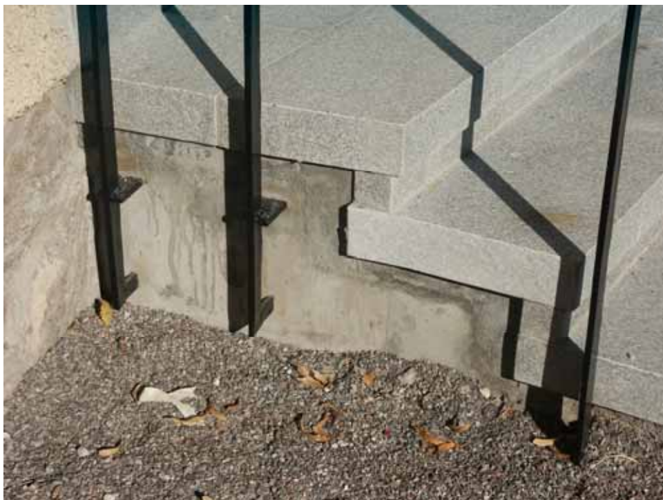
Detalj av ny yttertrappa.
