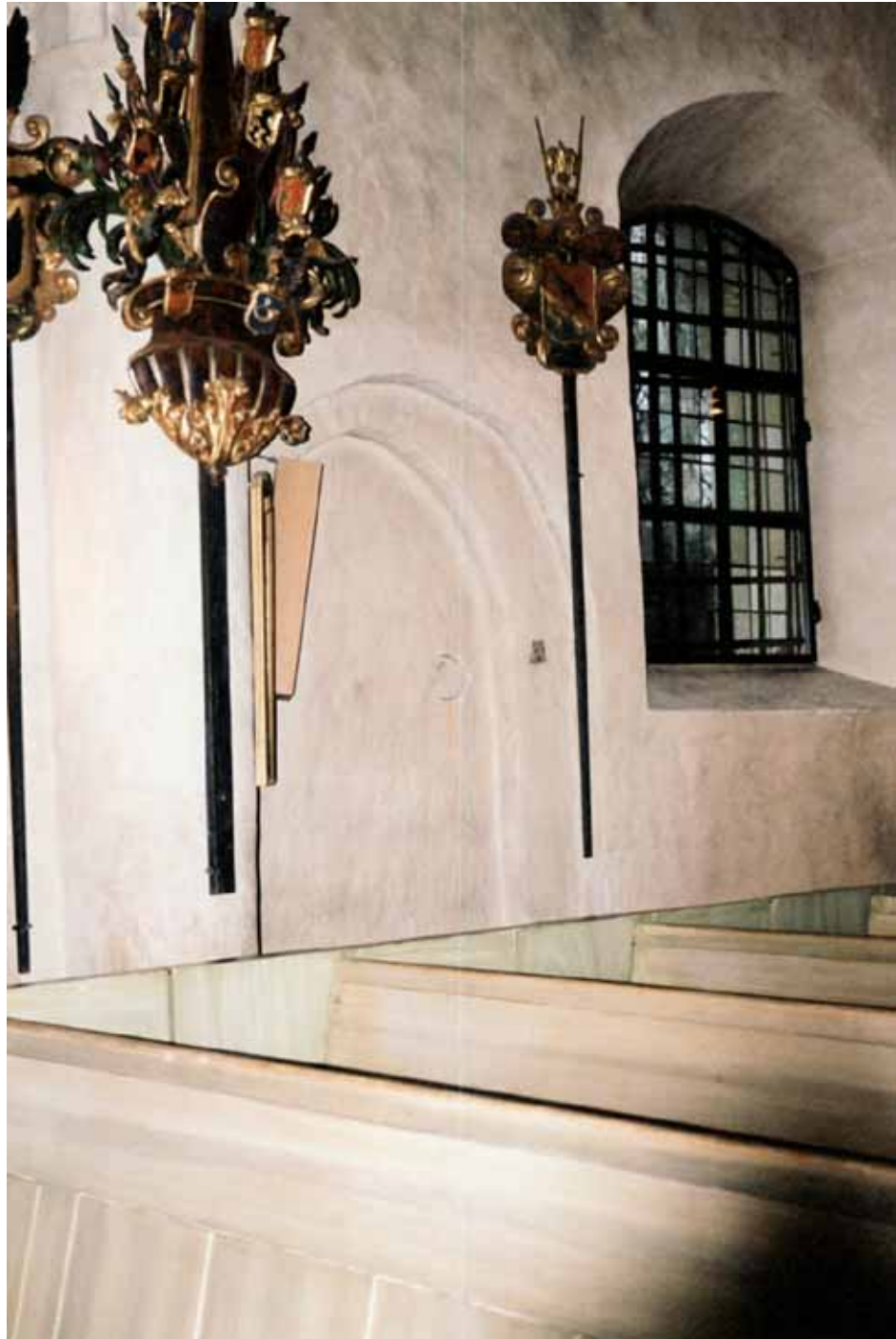
Den igenmurade sydportalen var markerad i putsen interiört.
