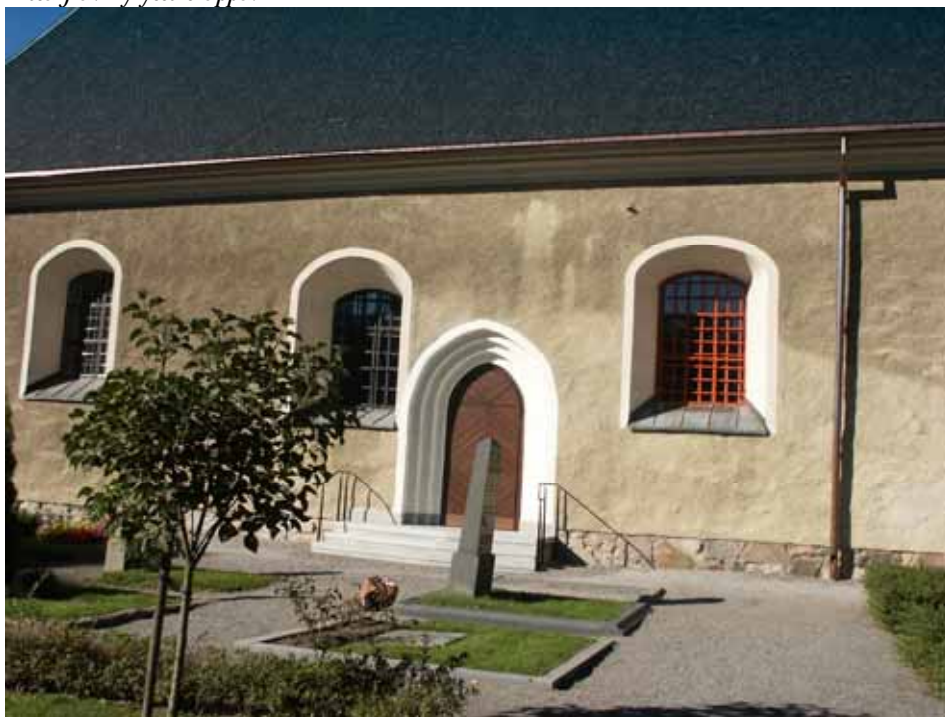
Sydportalen efter avslutade arbeten.
