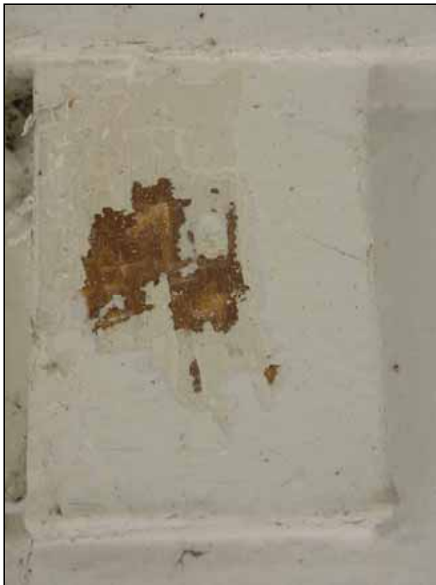
På listverk och konsoler framkom en järnoxidbrun färg i det understa färgskiktet. Bildnr: lp20070173. Foto: Lisa Sundström.
