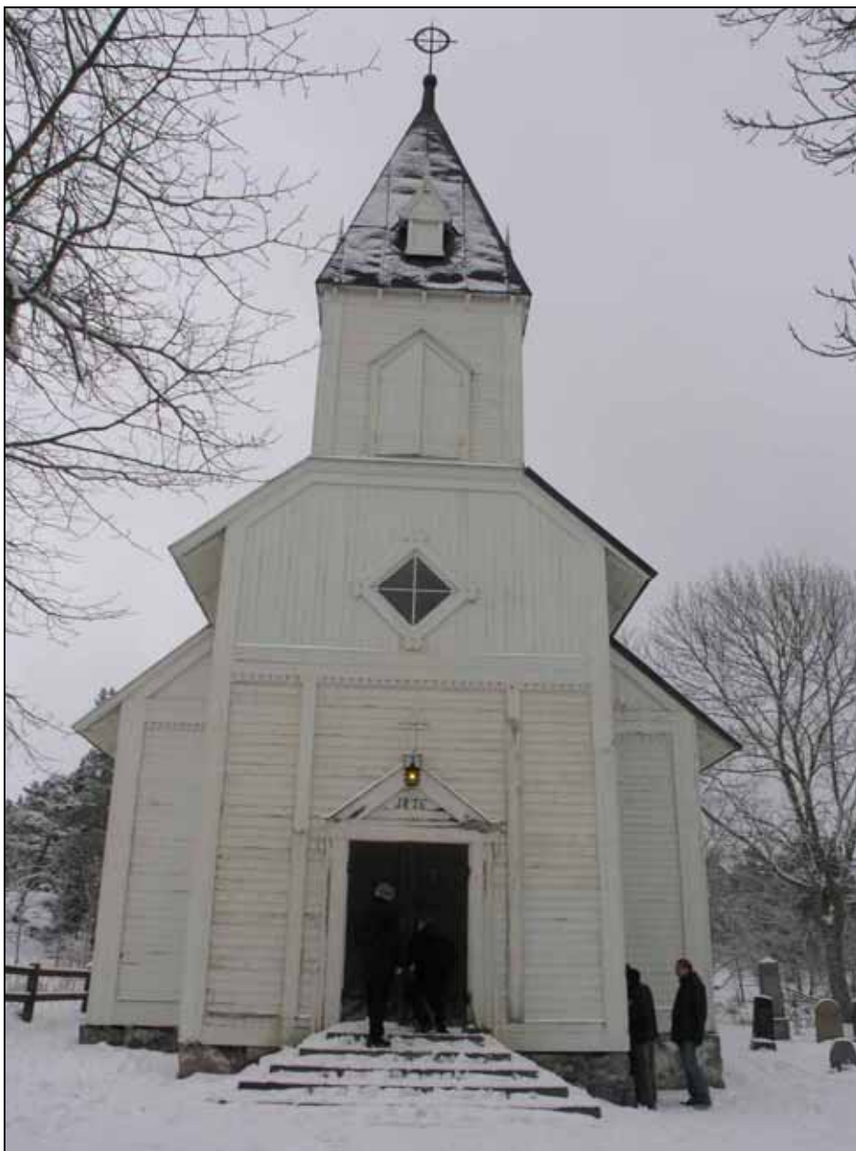
Den södra sidans vindskivor av plåt ersattes med nya av trä med lika profilering som befintliga på norra sidan. Bildnr: lp20070169. Foto: Lisa Sundström.
