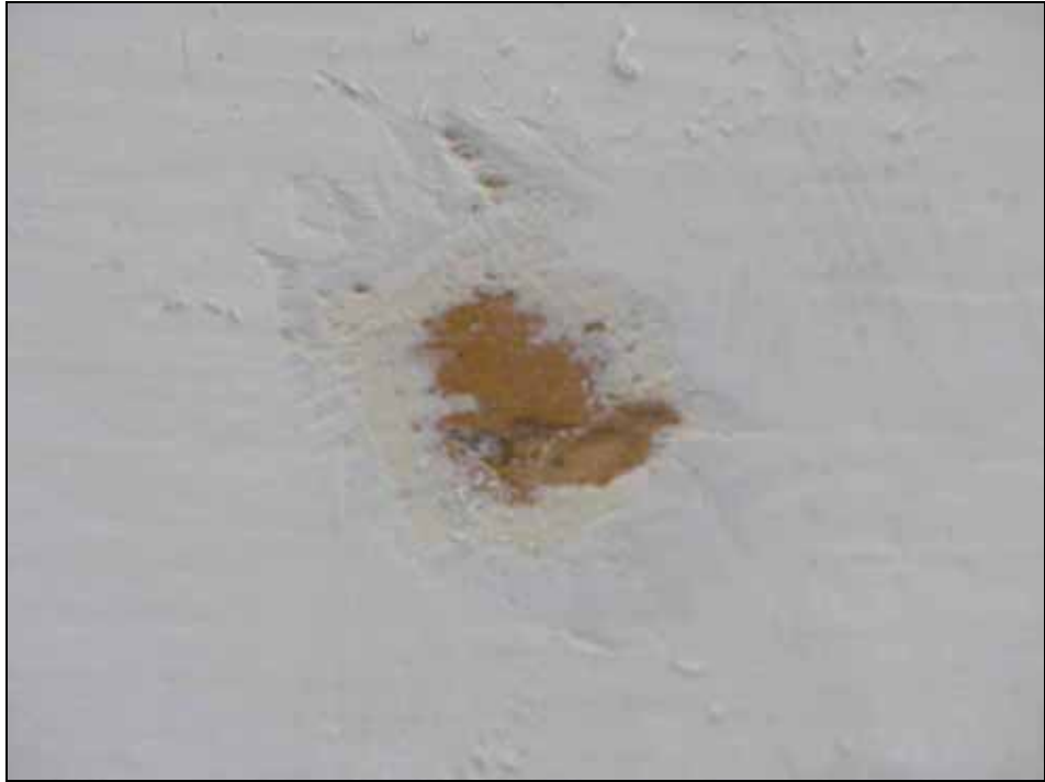
Undersökning av kyrkans färglager. Det understa färgskiktet utgjordes av en guldockra färg på fasaderna. Bildnr: lp20070172. Foto: Lisa Sundström.
