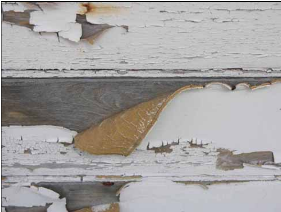
Den befintliga färgen var i dåligt skick. Bildnr: lp20070174. Foto: Lisa Sundström.
