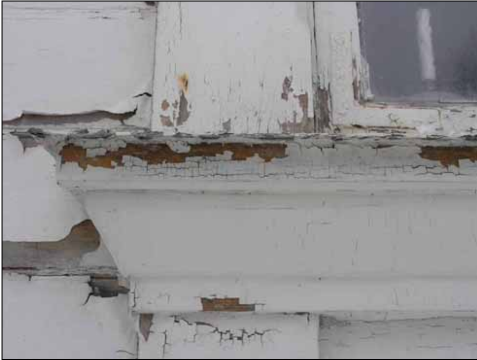
Den befintliga färgen var i dåligt skick. Bildnr: lp20070166. Foto: Lisa Sundström.
