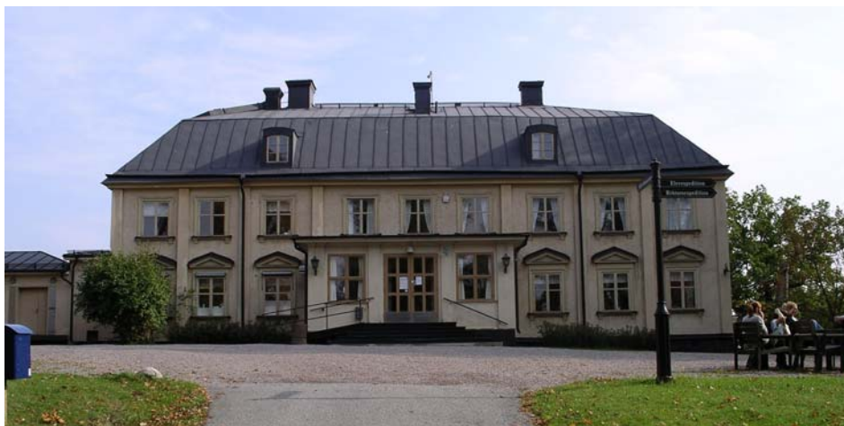
Huvudbyggnaden. Verandan tillbyggd under 1900-talet.
