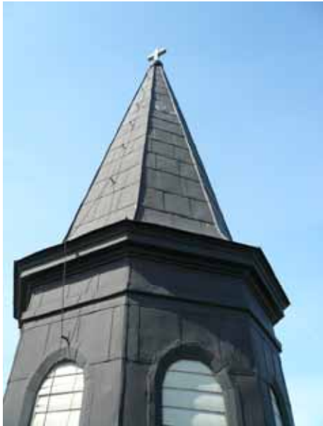
Tv. Tornspirans överdel före takläggning. Th. Tornspirans mittdel med ljudöppningar före takläggning. Bildbeteckning lp20070112 och lp20070113 . Foto Jean-Paul Darphin 2007.
