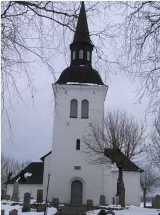
Kyrkan från väst före takomläggning. Bildbeteckning lp20070126. Foto Lisa Sundström 2005.
