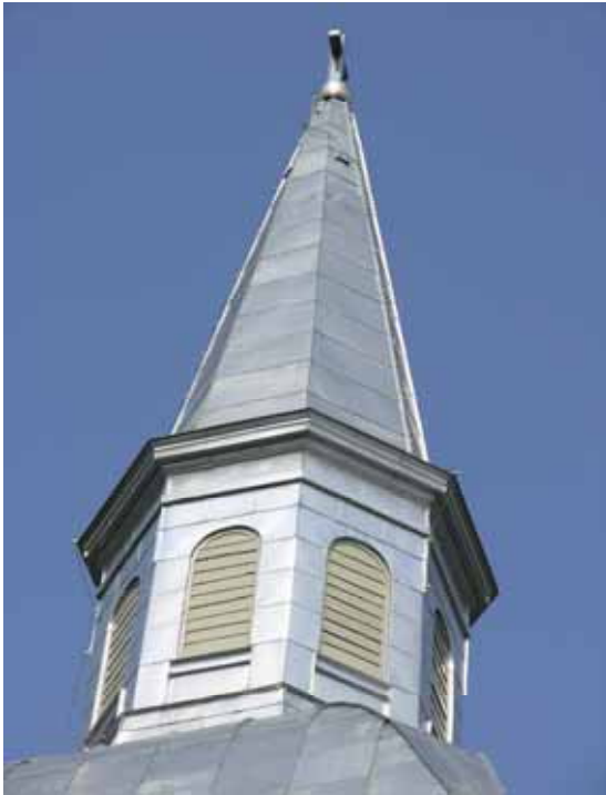
Tornspiran efter omläggning. I skivtäckningens övre del syns två av tornets fyra nya ventiler. Ljudöppningarnas luckor är nymålade i samma kulör som tidigare. Bildbeteckning lp20070122. Foto Cecilia Pantzar 2007.
