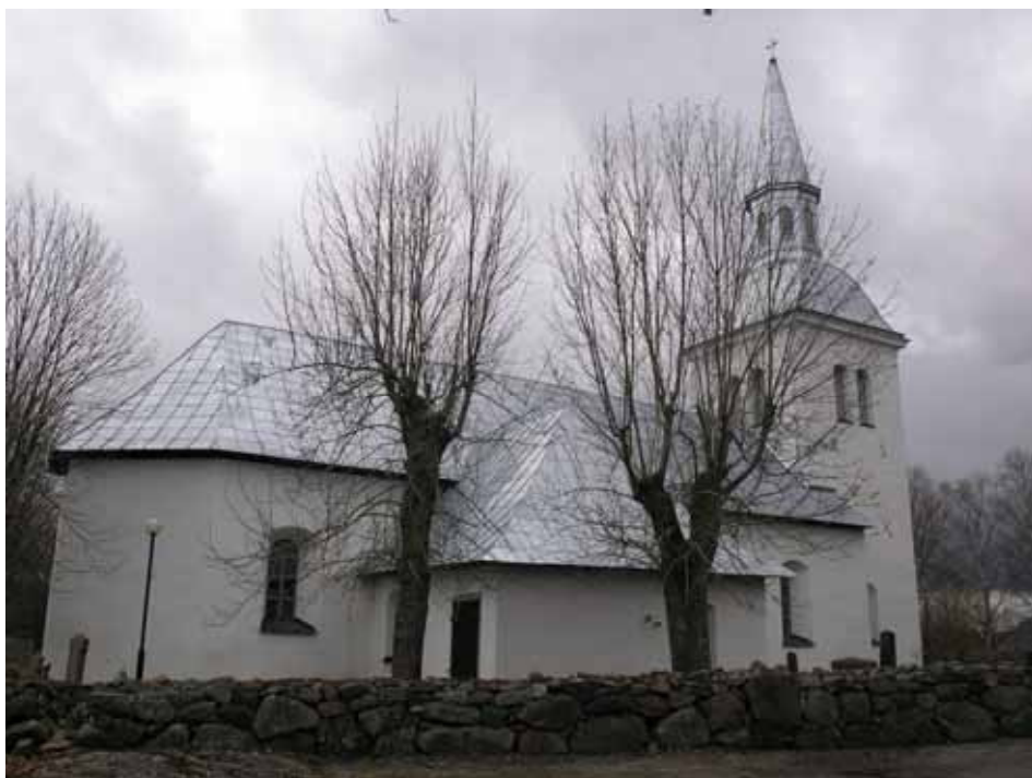
Kyrkan från nordöst efter takomläggningen. Den omålade plåten kommer att svartmålas först efter tre år. Bildbeteckning lp20070109. Foto Cecilia Pantzar 2007.
