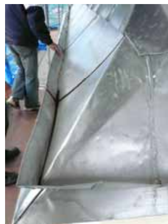
Tv. Detalj av tornets nedre takfall före omläggning och införande av fotränna. Th. Detalj av tornets nedre takfall med ny plåt och fotränna. Bildbeteckning lp20070117 och lp20070118. Foto Jean-Paul Darphin 2007.
