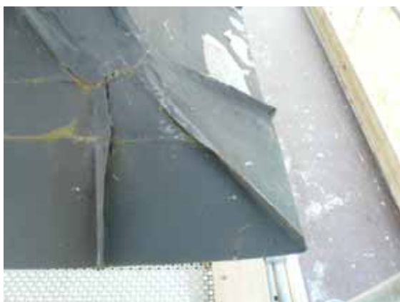
Tv. Detalj av tornets nedre takfall före omläggning och införande av fotränna. Th. Detalj av tornets nedre takfall med ny plåt och fotränna. Bildbeteckning lp20070117 och lp20070118. Foto Jean-Paul Darphin 2007.
