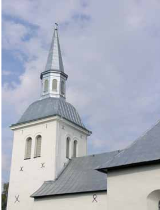
Kyrkans torn från sydöst efter omläggning. Lagg märke till den nya fotrännan och anslutande stuprör. Bildbeteckning lp20070120. Foto Cecilia Pantzar 2007.
