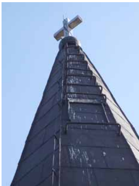
Tv. Spirans topp före takomläggning med nu borttagen lucka och stege i sydvästra takfallet. Th. Ståndskiva mellan långhus och torn i nord före omläggning. Bildbeteckning lp20070115 och lp20070116. Foto Jean-Paul Darphin 2007.
