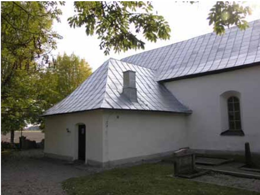
Sakristian från nordväst efter omläggning. Skorstenens nedre del ansluter med utkragande plåt istället för slät som tidigare. Från ståndskivan utgår en diskret vattenavledande plåt bort från fasaden. Den utsvängda takfoten är väl bibehållen. Bildbeteckning lp20070123. Foto Cecilia Pantzar 2007.
