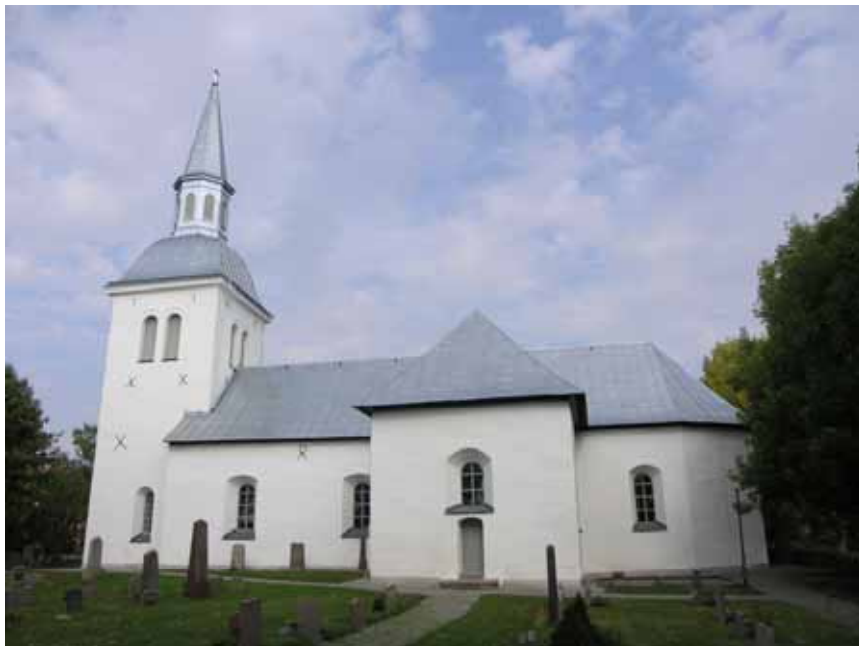
Kyrkan från söder efter omläggning. Utmed långhusets nock skymtar de nya färstöglorna för livlina. Bildbeteckning lp20070121. Foto Cecilia Pantzar 2007.
