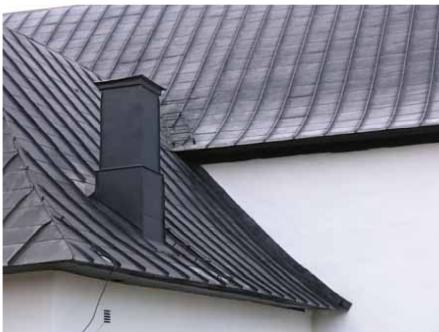
Sakristians västra takfall med skorsten och stegar före omläggning. Bildbeteckning lp20070119. Foto Lisa Sundström 2005.
