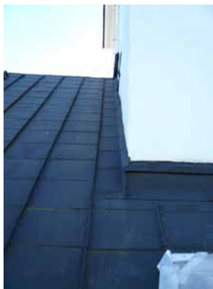
Tv. Spirans topp före takomläggning med nu borttagen lucka och stege i sydvästra takfallet. Th. Ståndskiva mellan långhus och torn i nord före omläggning. Bildbeteckning lp20070115 och lp20070116. Foto Jean-Paul Darphin 2007.
