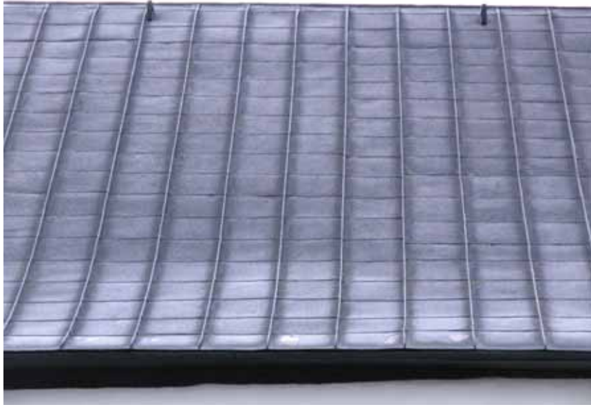
Långhusets norra takfall före plåtombeslagning med den gamla skivplåtens livgivande rytm. Notera livlinornas infästning vid nocken som nu är förflyttade till sydsidan. Bildbeteckning lp20070124. Foto Lisa Sundström 2005.
