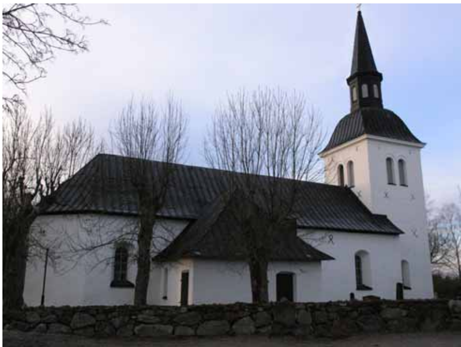
Skå kyrka från nordöst före takomläggning. Lägga märke till den utsvängda takfoten och det nätta takutsprånget . Bildbeteckning lp20070108. Foto Lisa Sundström 2005.
