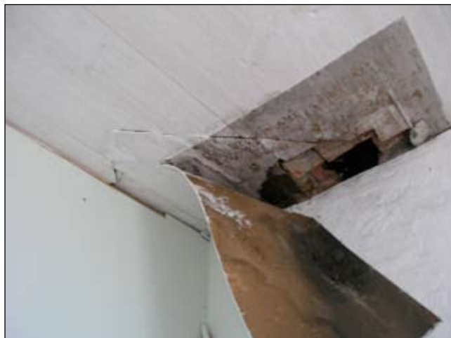
Fig. 25. Bakom pappen i taket visar sig ett äldre färgskikt i grå kulör. Där syns även en igensättning efter en tidigare eldstad/rökgång. Bildnr Lp 20080728.
