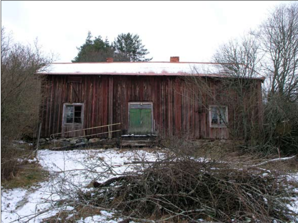
Fig 14. Fasad med entredörr och två fönster mot söder. Bildnr Lp 20080717.
