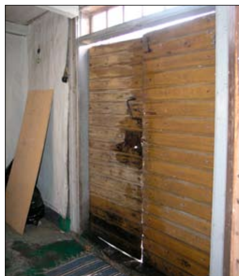
Fig. 19. Linoleummatta i förstugan som har täckmålats med en grön färg, liksom delar av golvlisten. Bildnr Lp 20080722.
