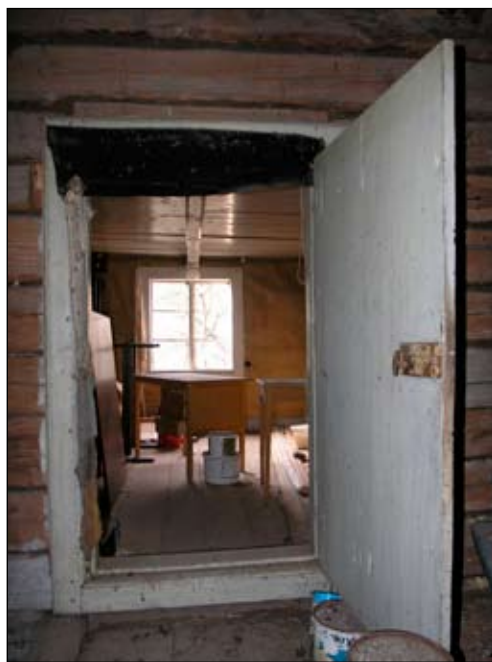
Fig. 29. Kammaren i övervåningen sedd från hallen. Bildnr Lp 20080732.
