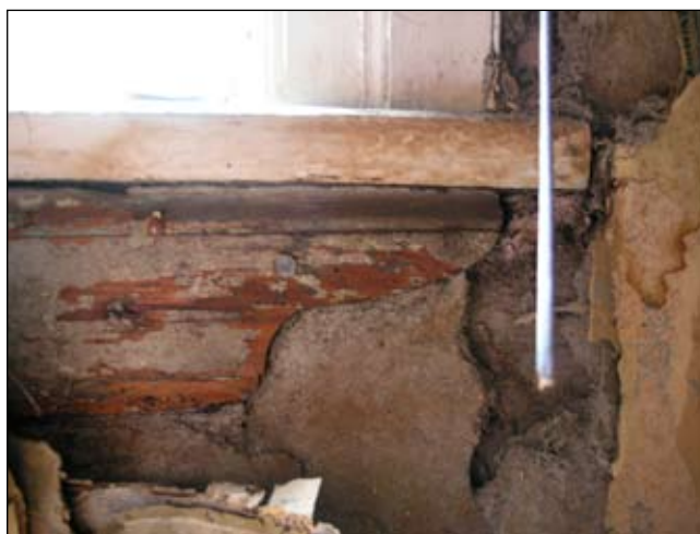
Fig. 22. Fönster i kammaren med profilerat understycke i trä. Under den syns rester av lerklining. Bildnr Lp 20080725.
