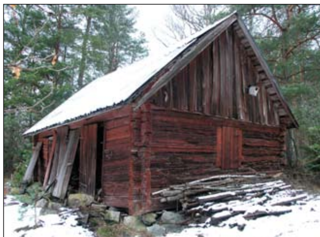
Fig. 6. Vedbod nordväst om mangårdsbyggnaden. Bildnr Lp 20080739.
