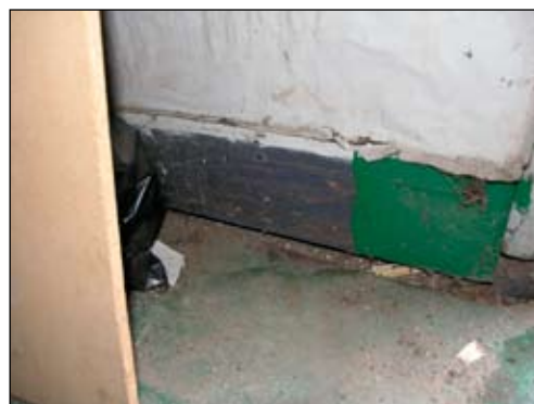
Fig. 19. Linoleummatta i förstugan som har täckmålats med en grön färg, liksom delar av golvlisten. Bildnr Lp 20080722.
