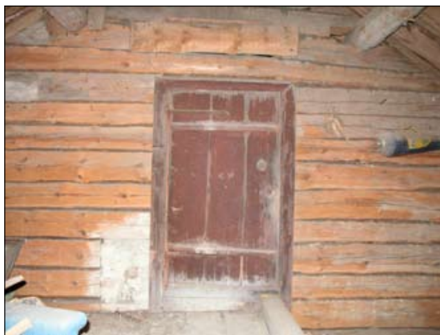
Fig. 26. Hallen i övervåningen med dörren till vinden. Bildnr Lp 20080729.
