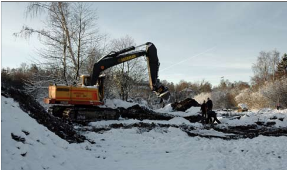
Fig 6. Schaktarbete efter snöfall. Foto: Anders Johnsson. Bildnr: Lp20070104.
