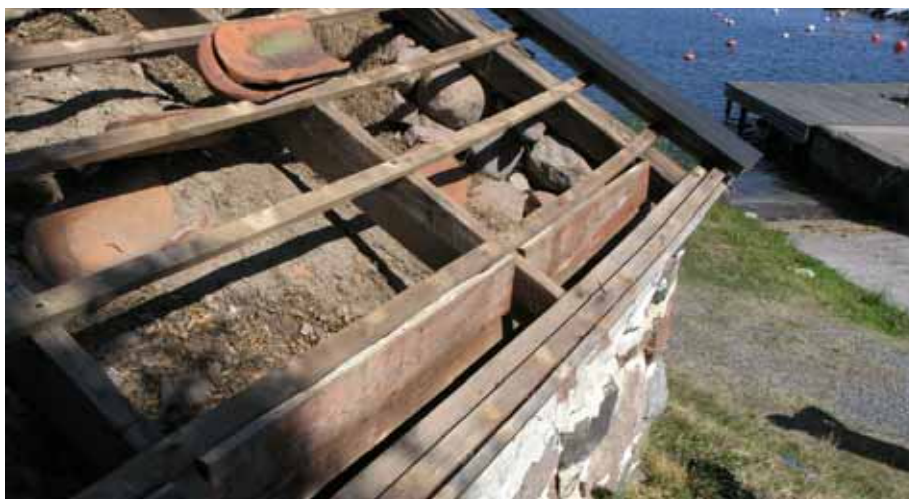
Takkonstruktionen före renoveringen. Som framgår var den tidigare bärläkten kraftigt försvagad. Här ses också den ursprungliga bräda som löper mellan varje högben och som nu kompletterats runt om. Notera även högbenens olika dimensioner, av vilka den tunnare sedermera är ersatt av den kraftigare typen. Foto Andreas Lindblad, Stockholm läns museum, 2008
