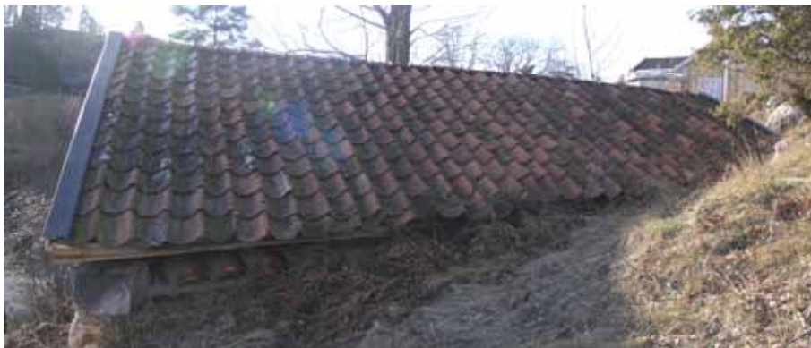
Jordkällaren före renoveringen. Foto Andreas Lindblad, Stockholm läns museum, 2008
