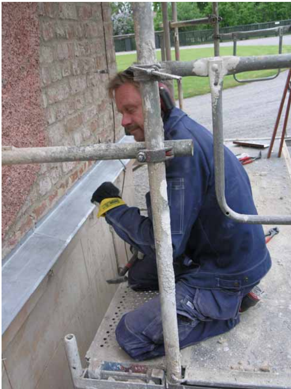
Ny plåt under läggning. Foto: Lisa Sundström, 2007. Bild nr: lp20080026
