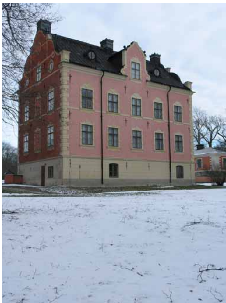
Restaureringen av fasaderna påbörjades med restaurering av fasaden åt sjösidan. Foto: Lisa Sundström, 2007. Bild nr: lp20080028
