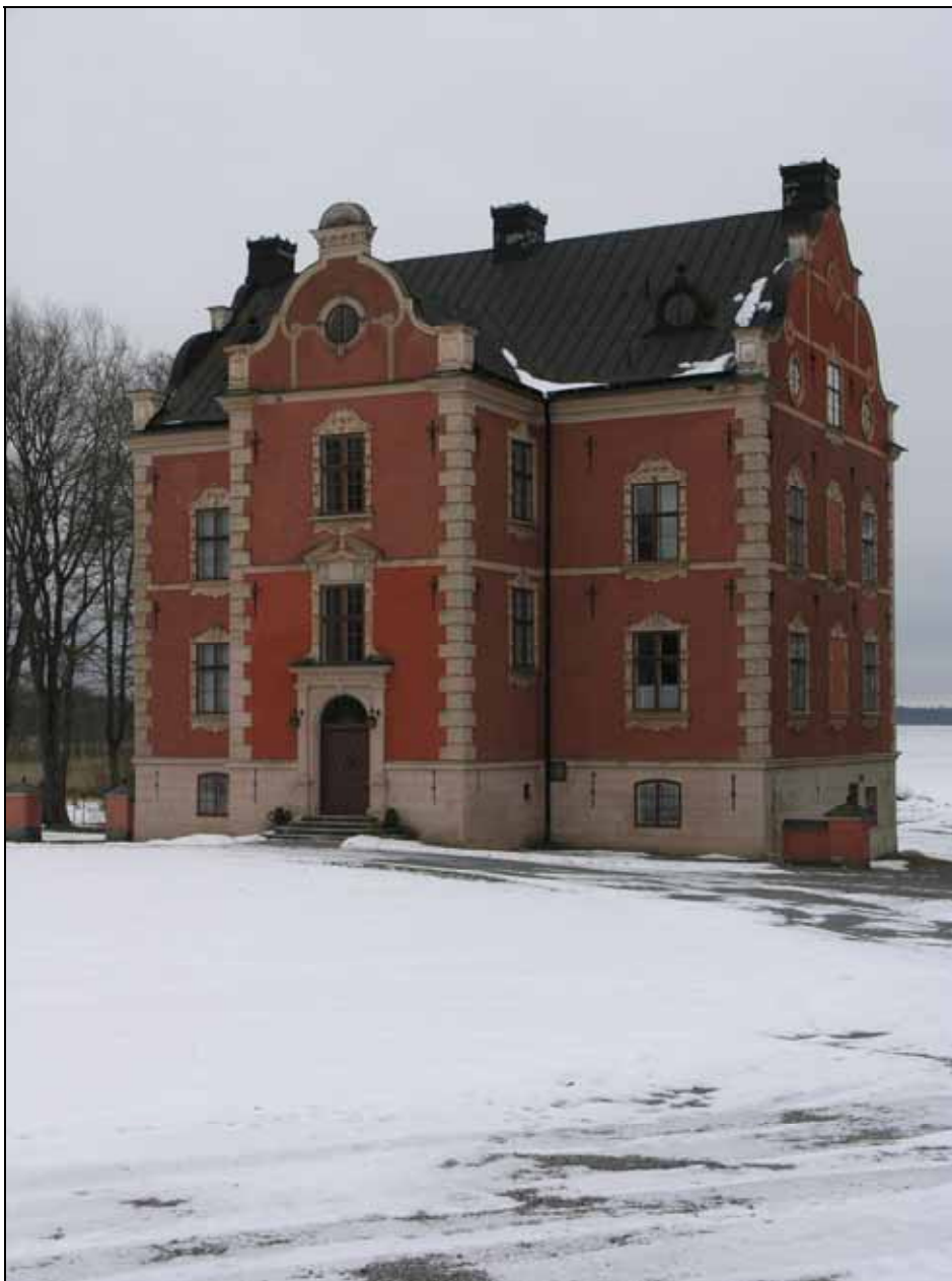
Skånelaholms slott före restaurering. Foto: Lisa Sundström, 2006. Bild nr: lp2008011
