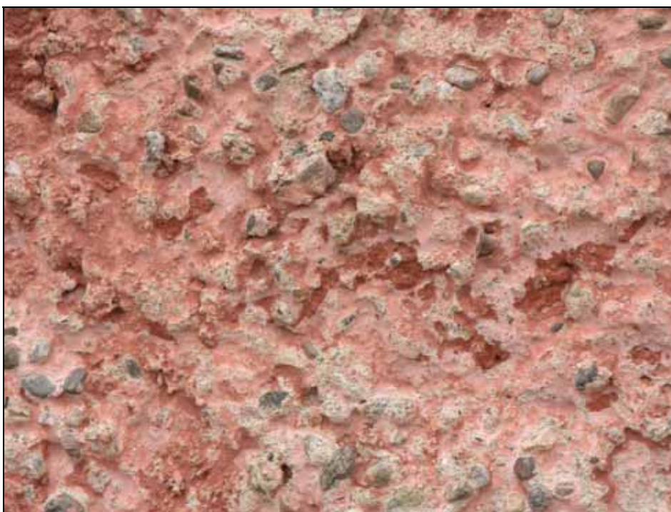
Bevarade äldre rosa färgskikt under den befintliga tegelröda färgen. Foto: Lisa Sundström, 2007. Bild nr: lp20080013
