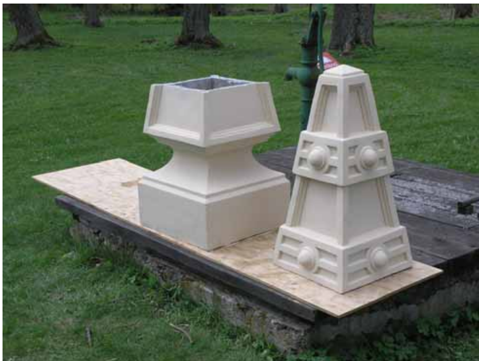
Nya obelisker tillverkades av fiberbetong med de befintliga som förebild. Foto: Lisa Sundström, 2007. Bild nr: lp20080023
