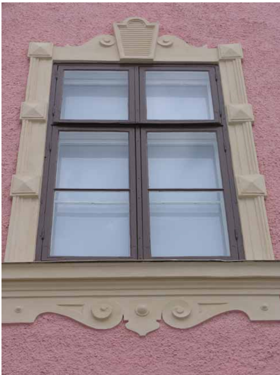
Fönstersnickerier kittlagades och ommålades. Foto: Lisa Sundström, 2007. Bild nr: lp20080025
