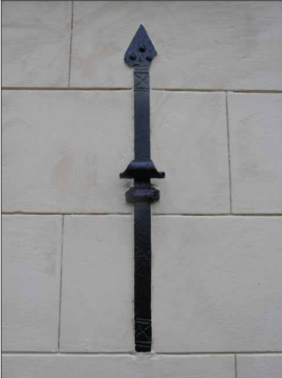
Lagade och målade ankarjärn i sockelvåning. Foto: Lisa Sundström, 2007. Bild nr: lp20080017
