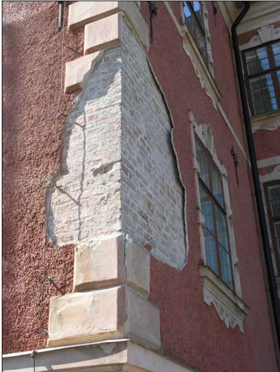
Puts som släppt från underlaget har fästs med rostfri dubb. Foto: Lisa Sundström, 2007. Bild nr: lp20080012
