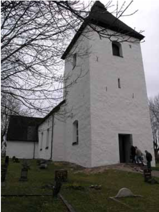
Kyrkan från nordväst efter restaurering. Rampen till västentrén ännu inte återställd. Bildbeteckning lp20080084. Foto Cecilia Pantzar 2007.
