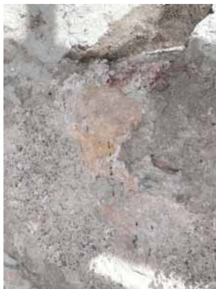
Tv. Fönsteromfattning av tegel med bevarad äldre slätputs, avfärgad i både gult och rött. Th. Äldre putslager med avfärgning i gult. Bildbeteckning lp20080079 och 80. Foto Jean-Paul Darphin 2007.
