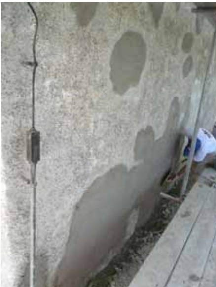
Tv. Putslagning pågår. Th. Långhusets vindskiva åt nordväst före målning. Ankarjärnen är rostskyddsmålade. Bildbeteckning lp20080071 och 72. Foto Jean-Paul Darphin 2007.
