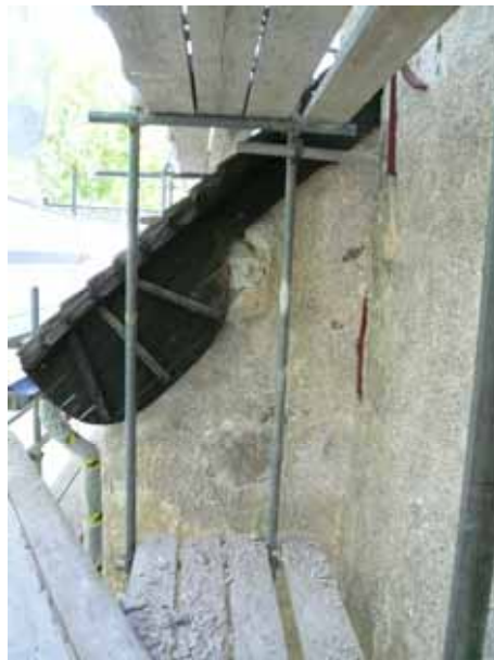
Tv. Putslagning pågår. Th. Långhusets vindskiva åt nordväst före målning. Ankarjärnen är rostskyddsmålade. Bildbeteckning lp20080071 och 72. Foto Jean-Paul Darphin 2007.
