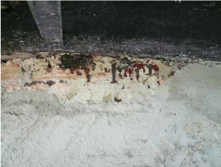
Långhusets takföt med äldre färggrinningar ner på putsen, av rödpigmenterad tjära. Färgspåren visar att takföten har varit rödmålad och troligtvis även spåntaken i sin helhet. Bildbeteckning lp20080082. Foto Jean-Paul Darphin 2007.
