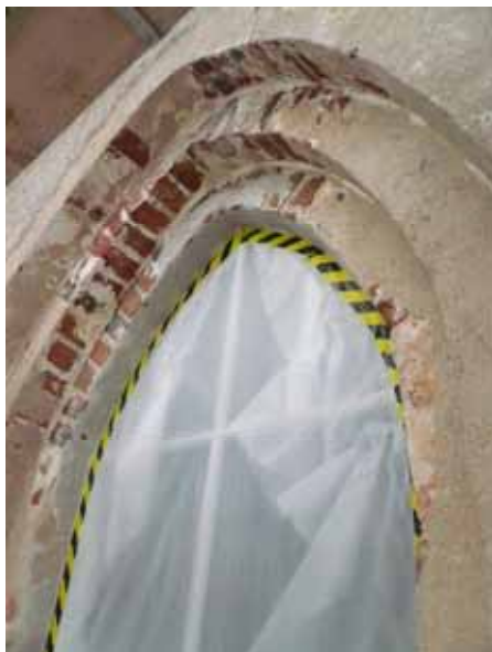
Tv. Fönsteromfattning av tegel med bevarad äldre slätputs, avfärgad i både gult och rött. Th. Äldre putslager med avfärgning i gult. Bildbeteckning lp20080079 och 80. Foto Jean-Paul Darphin 2007.
