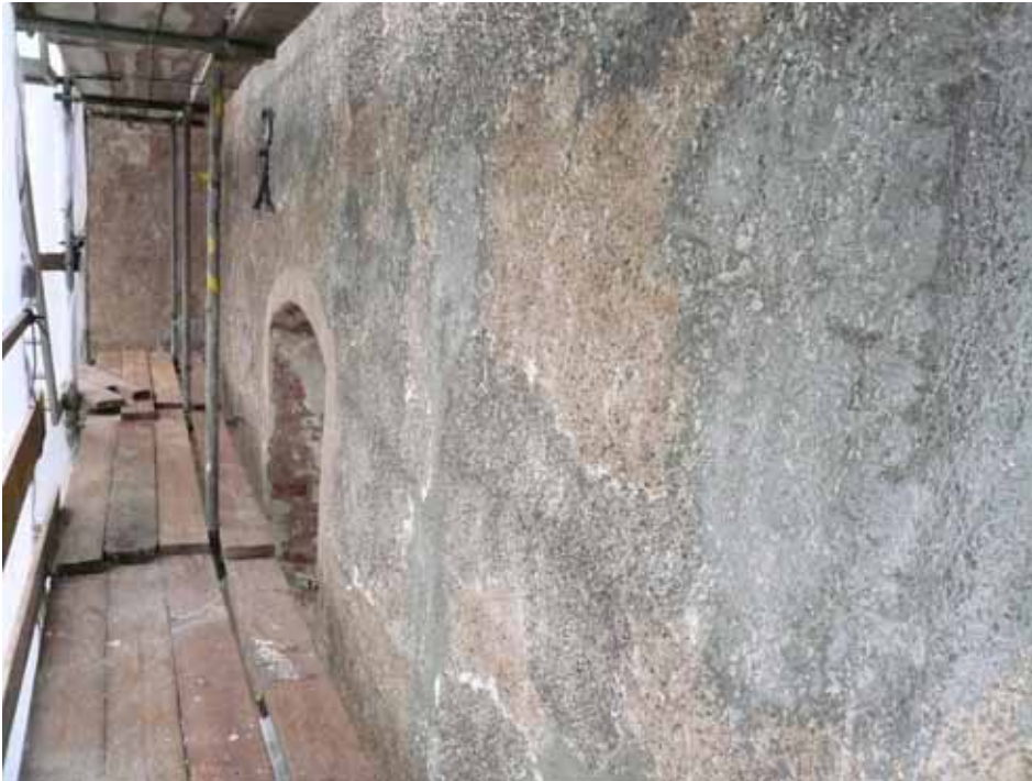
Fasader efter rengöring. Äldre avfärgningar och putslagningar framträdde tydligt. Bildbeteckning lp20080070. Foto Jean-Paul Darphin 2007.
