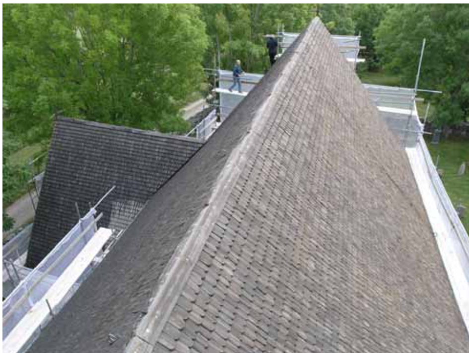
Kyrkans tak från väster före restaurering. Bildbeteckning lp20080073. Foto Jean-Paul Darphin 2007.
