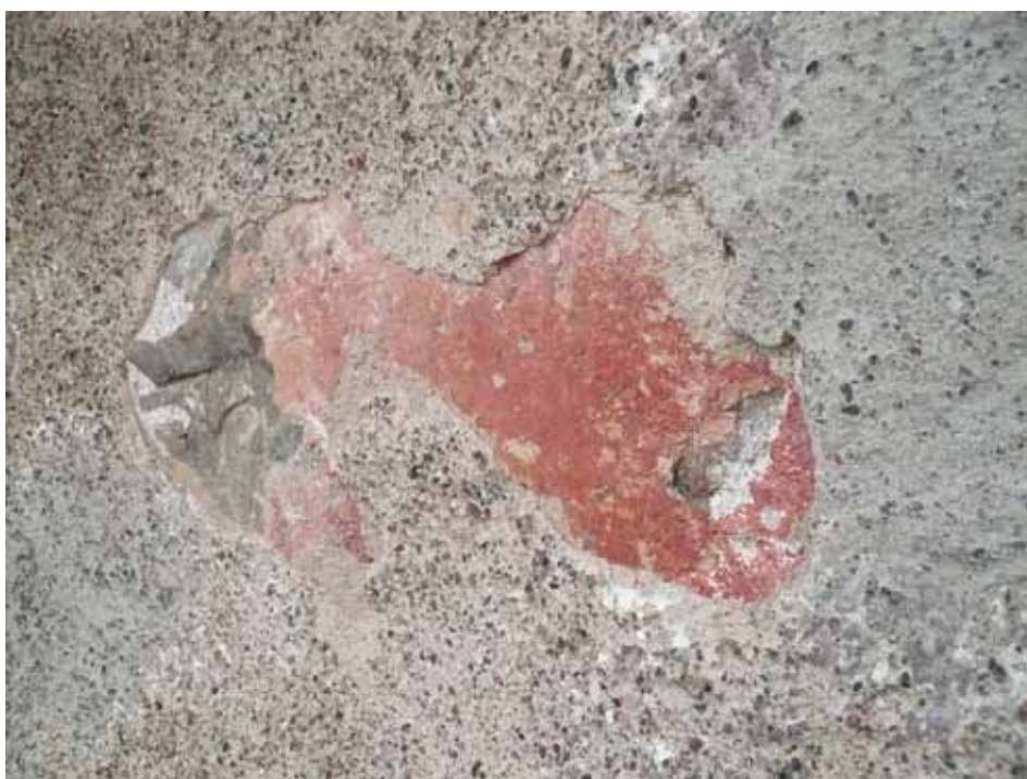
Äldre slätputs med en mättad röd avfärgning, troligtvis tillkommen under 1800-talet. Bildbeteckning lp20080081. Foto Jean-Paul Darphin 2007.
