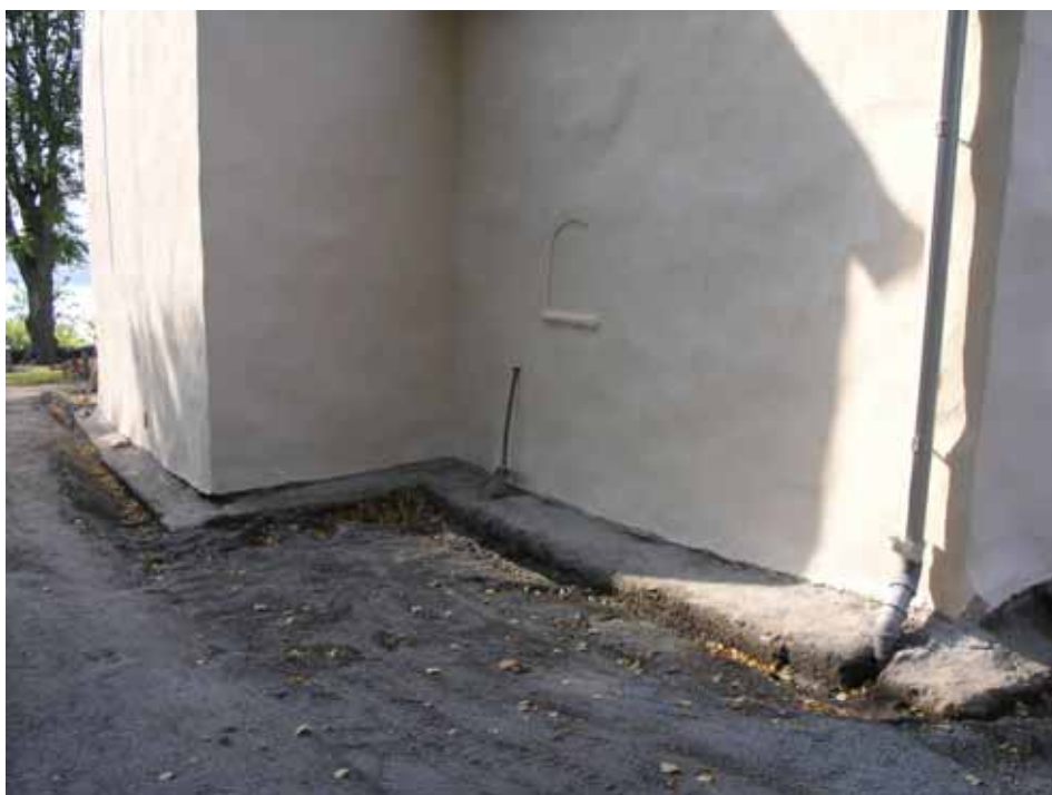
Grävning för dränering på kyrkans östra sida. Lägg märke till den utskjutande betongklacken som frilades runt sakristia och kor. I förgrunden syns sakristian och därefter koret. Bildbeteckning lp20080099. Foto Cecilia Pantzar 2007.
