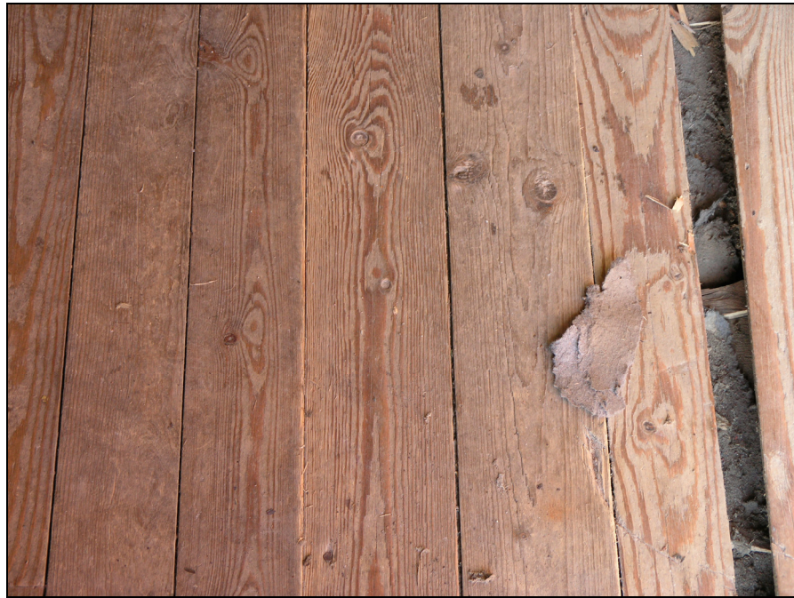
Det befintliga golvet med brädor i olika bredder. Foto: Lisa Sundström. Bildnr: lp20090160.
