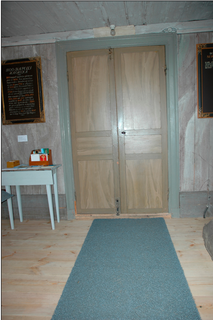
Nytt golv av furu lades på samma ledd som det befintliga underliggande breda golvet. Foto: Lisa Sundström. Bildnr: lp20090164.
