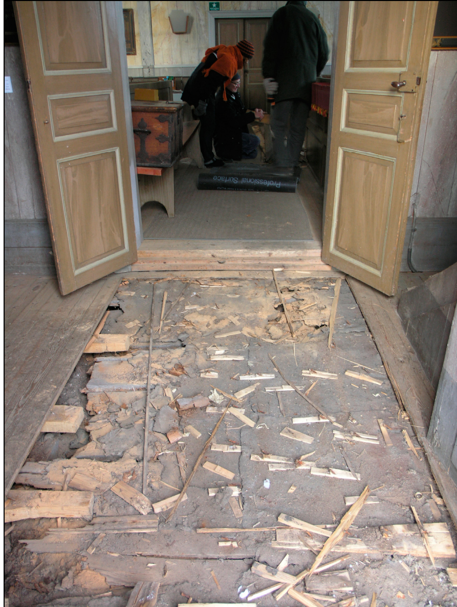
Det befintliga golvet avlägsnades. Foto: Lisa Sundström. Bildnr: lp20090163.
