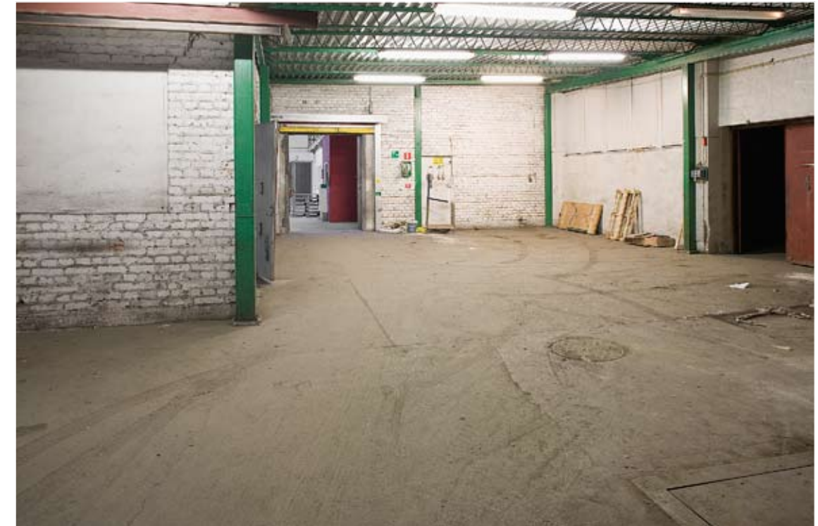
Lastkajen med byggnad 15.1 till vänster i bild 19.1 till höger samt entré till byggnad 16
