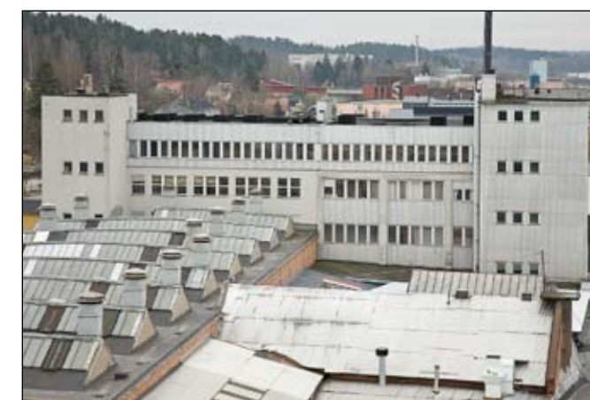
Byggnad från norr. Ldng20090412
