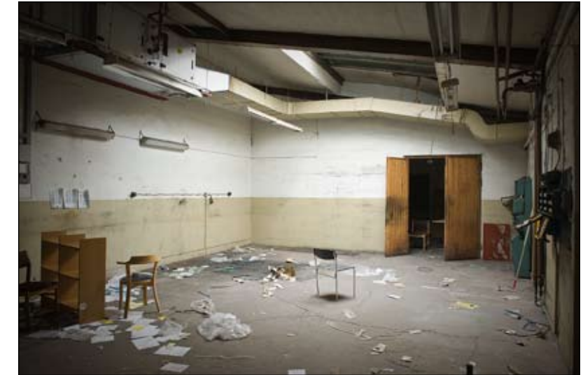
Verkstadslokal (15) uppförd som svarv- och slipavdelning 1951. Ldng20090229
