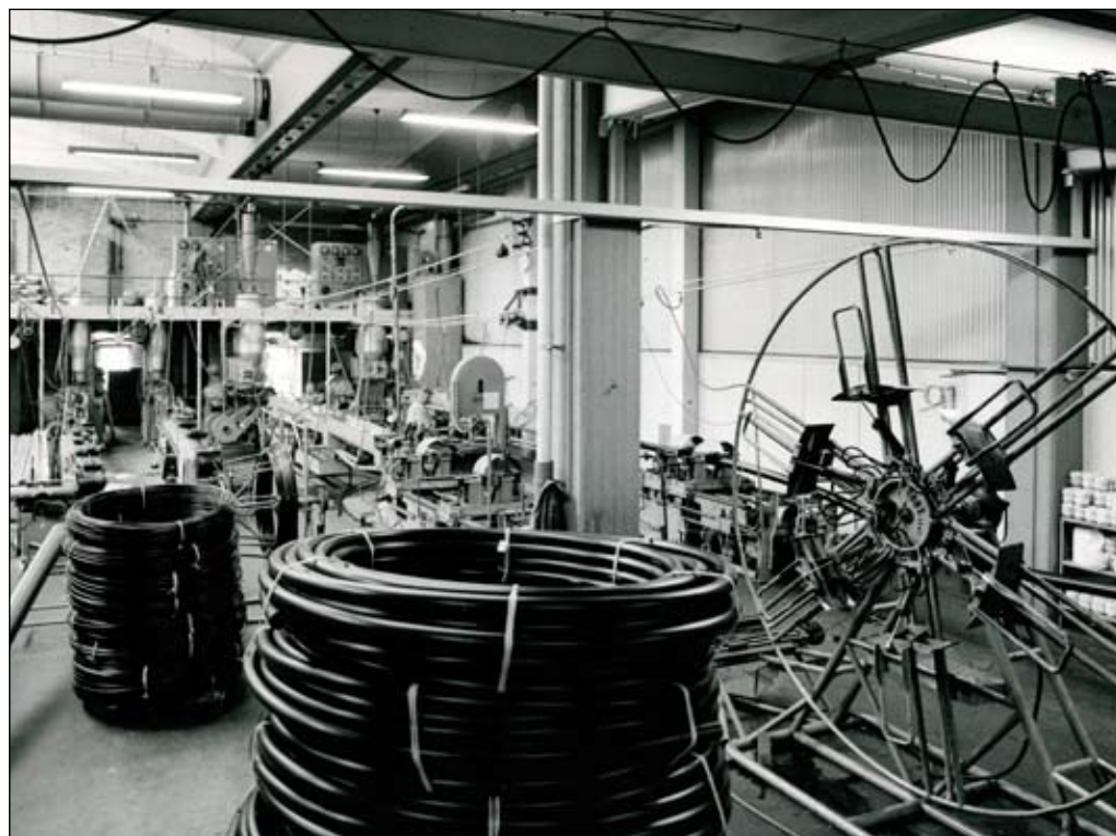
Interiör från tillverkning plaströr vid Väsbyverken. Foto: K.W. Gullers, 1964, bildnr: UV1633, Upplands Väsby kommuns bildarkiv.
