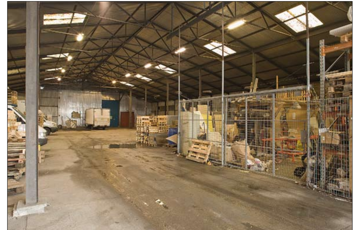
Lagerbyggnad uppförd 1953, interiör. Ldng20090181
