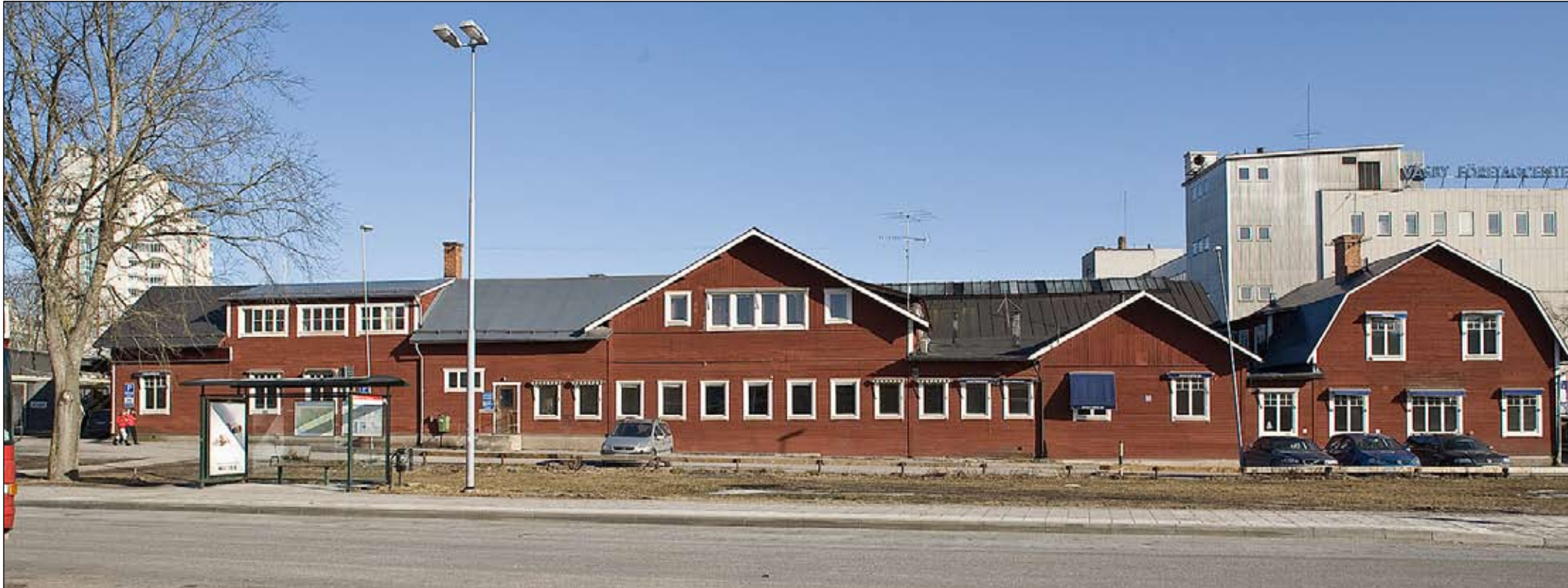
Den röda längan med byggnader från 1903-1917. Ldng20090344
