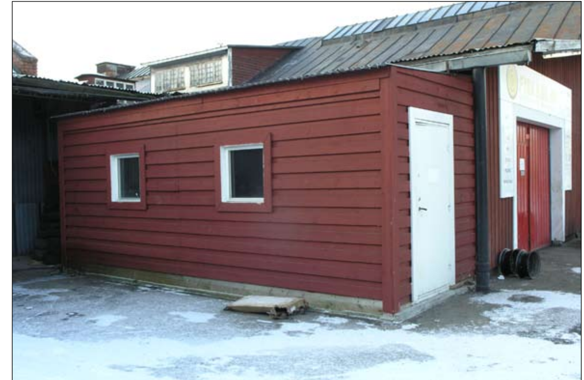
Kontorstillbyggnad till bilverkstad Fyra Hjul AB. Lp20090303
