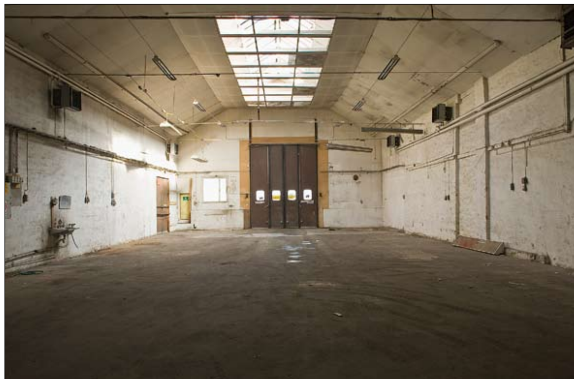
Verkstadslokalen i den äldsta verkstaden från 1903. Ldng20090353
