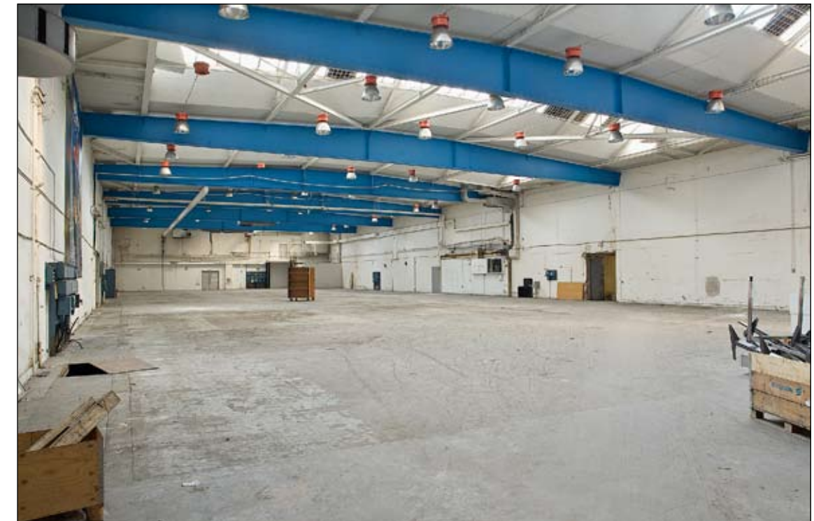
Öde verkstadshall uppförd 1951 för varmpressning och bearbetning av mässing. Ldng20090361
