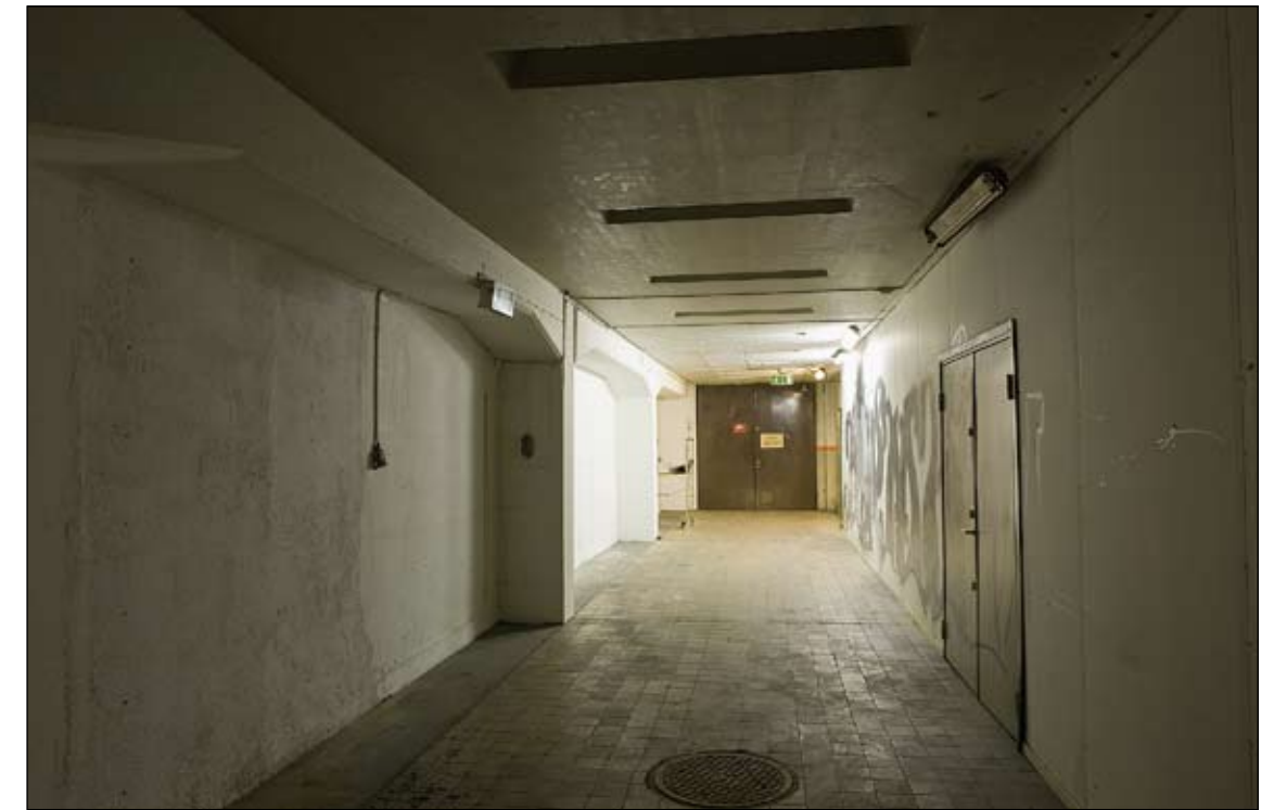
Transportgång i bottenvåningen i förrådsbyggnad uppförd 1951 .Ldng20090380
