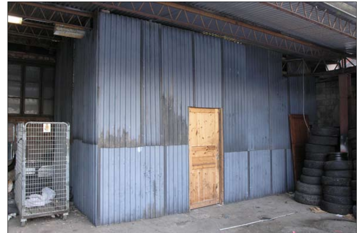
Förrådsbyggnad uppförd efter 1989. Foto Lisa Sundström. Lp20090304
