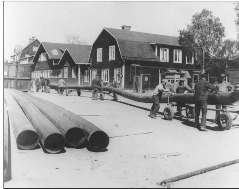
▲ Lastning av plaströr, 1950. Bild.nr: UVK 00399, Upplands Väsby kommuns bildarkiv.
