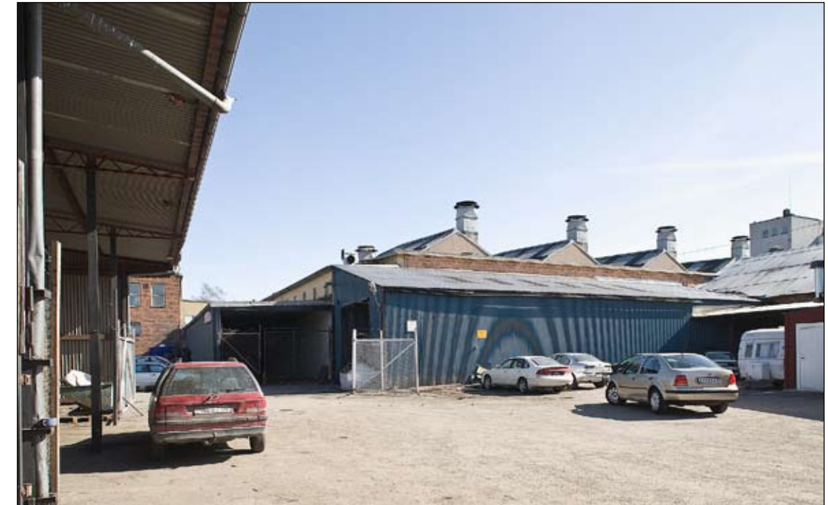
F.d. förrådsbyggnad. Idag använd som bilverkstad av Väsby Bilcenter. Ldng20090401
