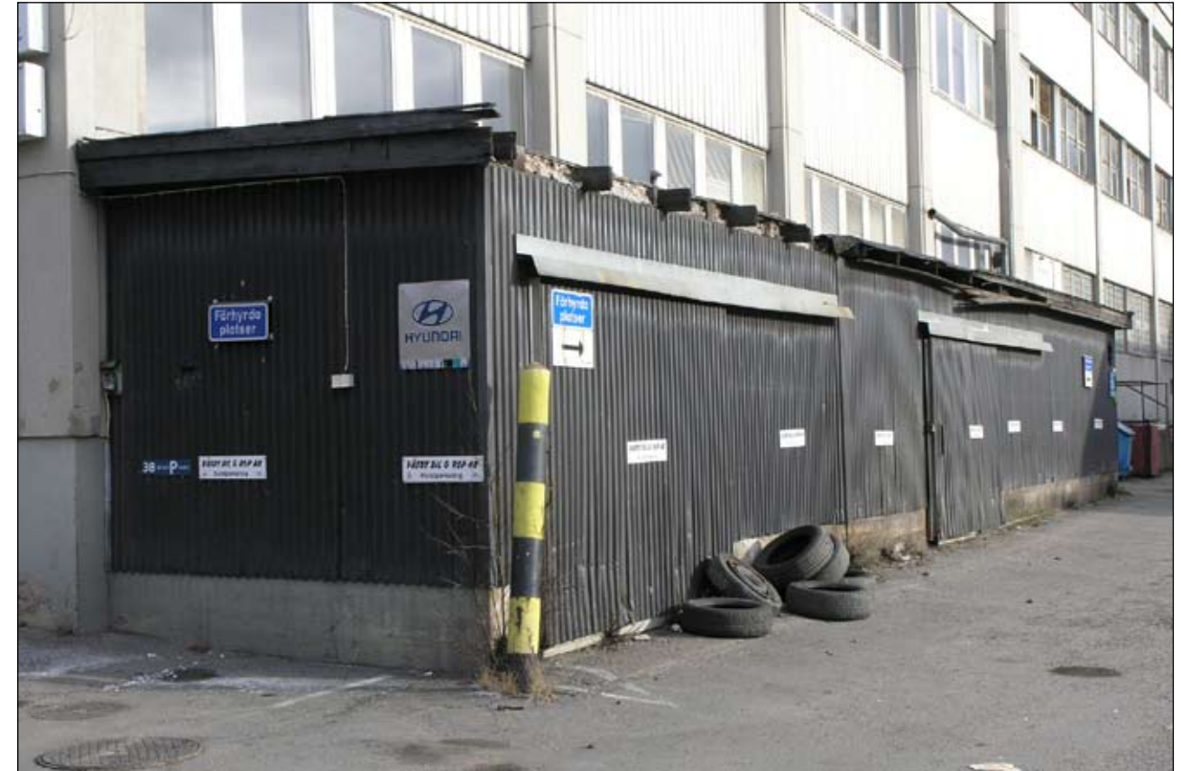
Byggnad för vattenrening. Foto Lisa Sundström. Lp20090302
