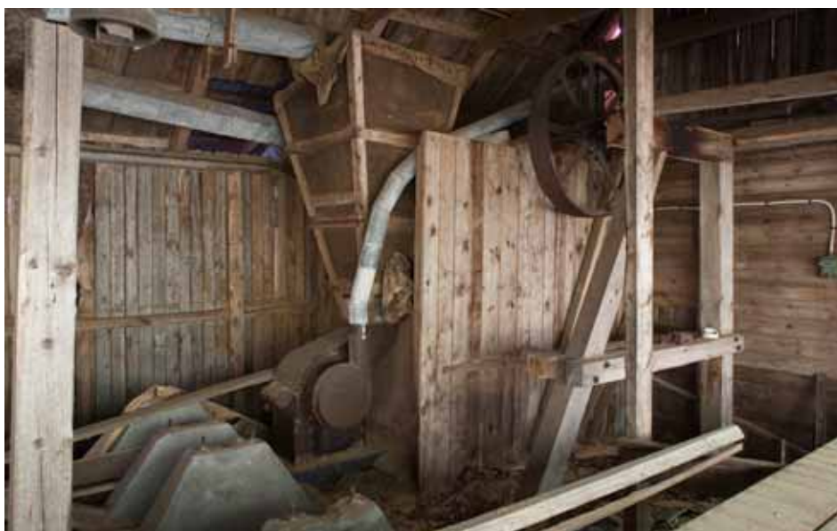
Kvarn för hyvelspån, kutterspån samt spånledning. De gjutna plintarna på bilden är rester efter den forna ångmaskinen. Foto: Elisabeth Boogh, Stockholms läns museum, 2009, Idng20090858h.
