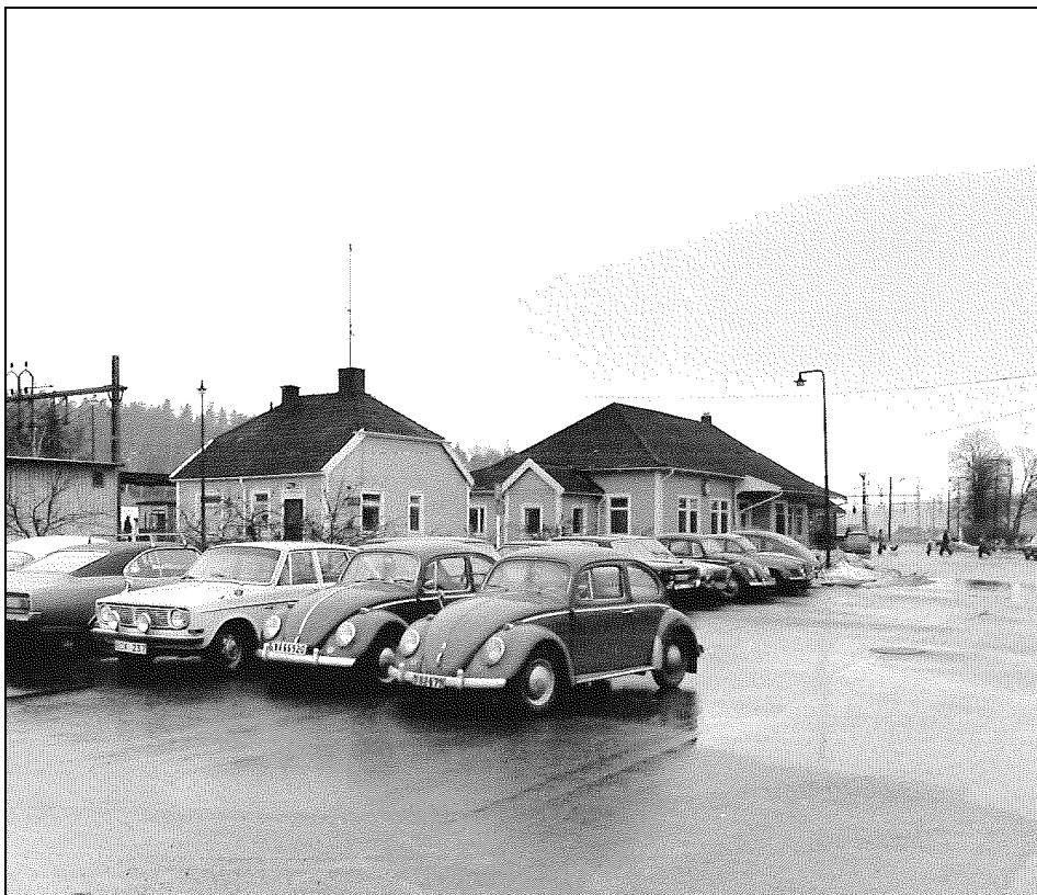
Stationshusen efter ombyggnaden under sent 1960-tal. Foto: C-H Ankarberg, 1973, Stockholms läns museum.
