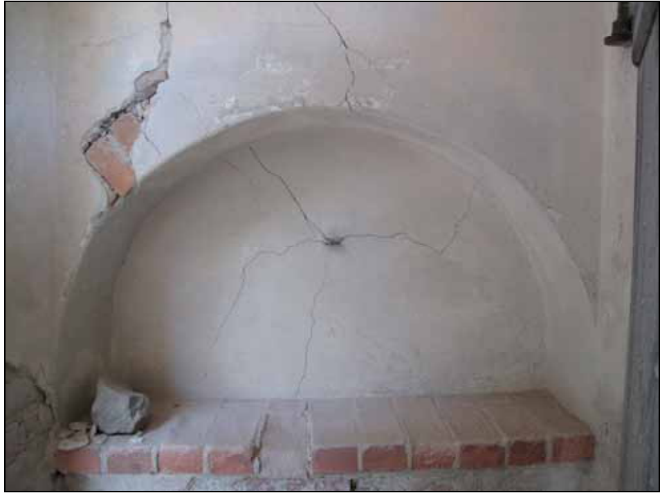
Västra stigluckans södra nisch under renovering. Foto: Lisa Sundström, bildnr: lp20090405, Stockholms läns museum.
