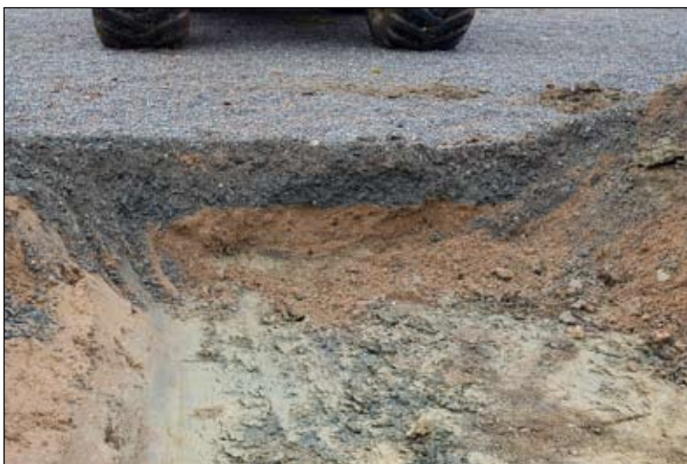
Fig 4. Marken under fotbollsplanen var tydligt avschaktad. Under gruset och sanden kom direkt ren lera. Foto Göran Werthwein, SSLM bild nr LP 20080895.
