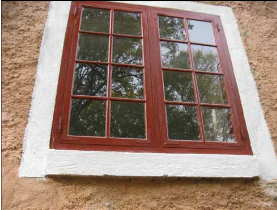
Traktorgaraget. Nya karmar och fönsterbågar. Foto: Bodil Toll. Lp20090435.
