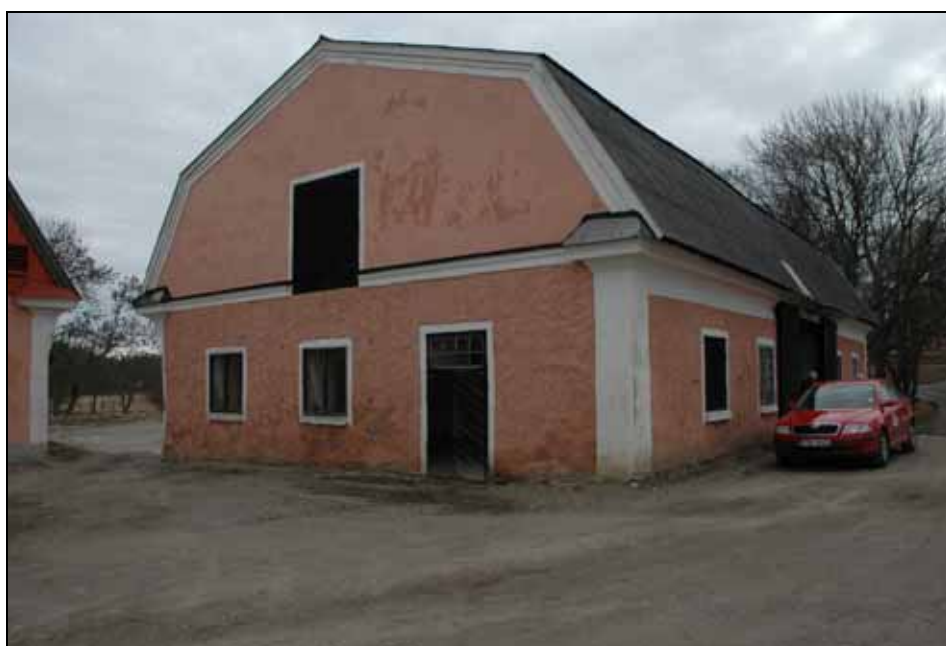
Traktorgaraget, västra fasaden. Före renovering. Foto:Ulrika Sahlsten. Lp20090426.
