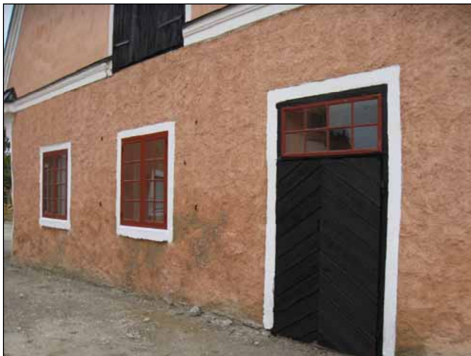
Traktorgaraget. Västra gaveln. Nya karmar och fönsterbågar samt bevarat och renoverat överljusfönster. Foto: Bodil Toll. Lp20090434.
