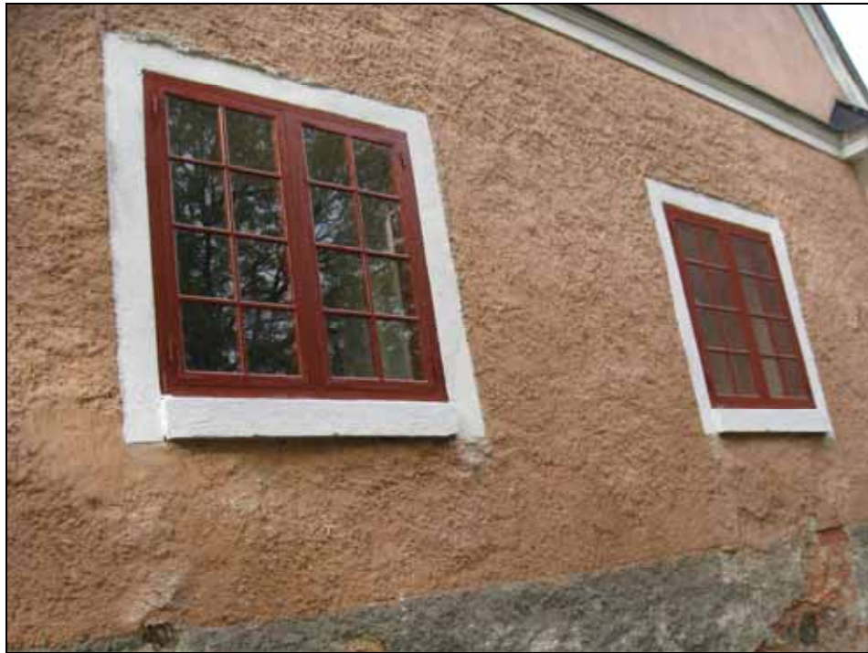
Traktorgaraget. Nya karmar och fönsterbågar efter renovering. Foto: Bodil Toll. Lp20090433.
