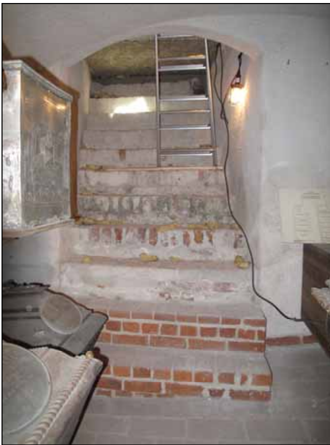
Nedgång till gravvalvet på trappor av tegel. De nedre trappstegen är ommurade, troligen under 1930-talet.
