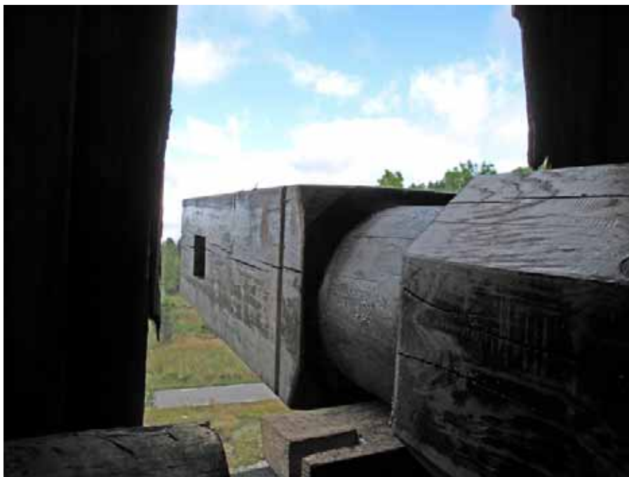
Gångåsens rundsvavade lagring vilar i storlagret på kvarnhusets främre gavel. För bättre rörlighet användes förr bl a sniglar som smörjmedel. Bildnr lp20090493
