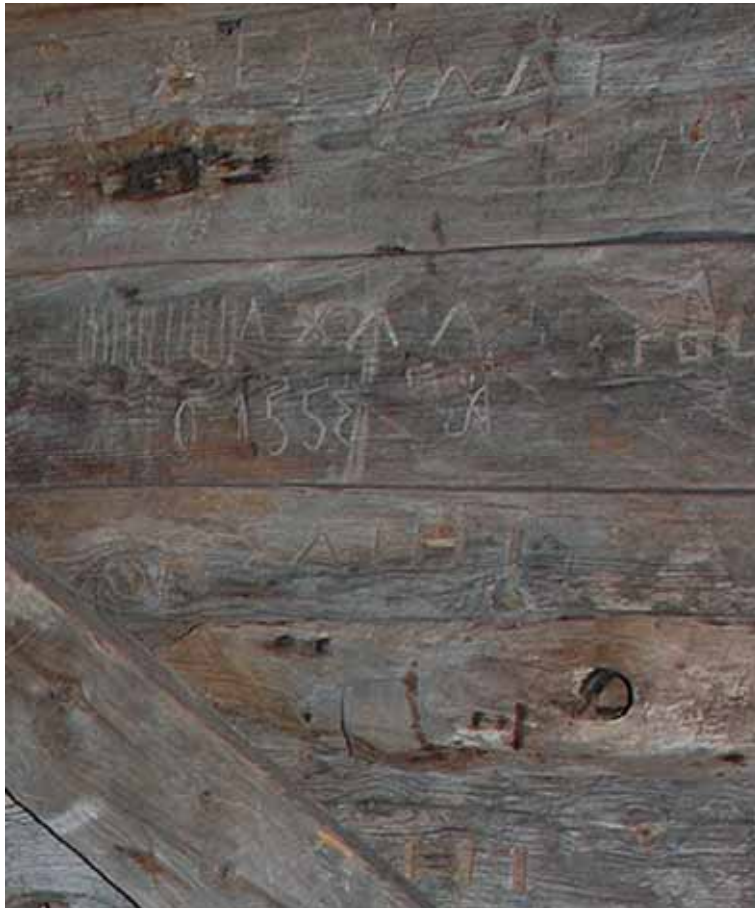
Att timmerstommen är uppmärkt med romerska siffror tyder på att kvarnen plockats ner och flyttats. Bildnr lp20090479
