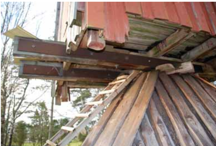
Brostockarnas har förstärkts med hjälp av breda plattjärn. Bildnr 20090486
