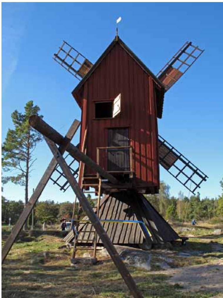
Kvarnhäst, trappa med balkong och räcke, dörr samt lucka har byggts nytt. Bildnr lp20090501
