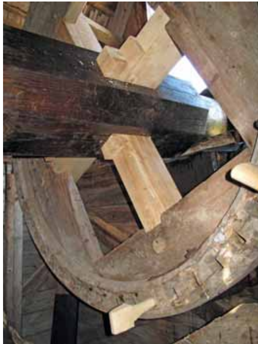
Ny kugge håller på att inpassas. Bildnr lp20090497
