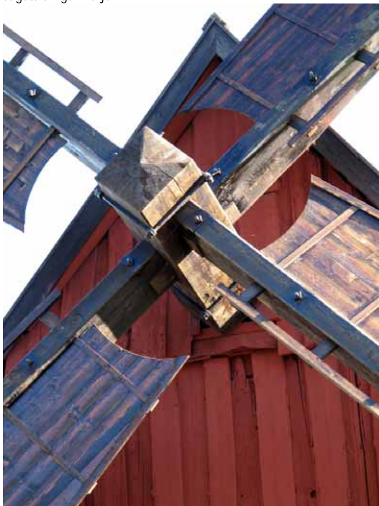
Kvarnvingarna är monterade på gångåsen. Bildnr Ip20090499
