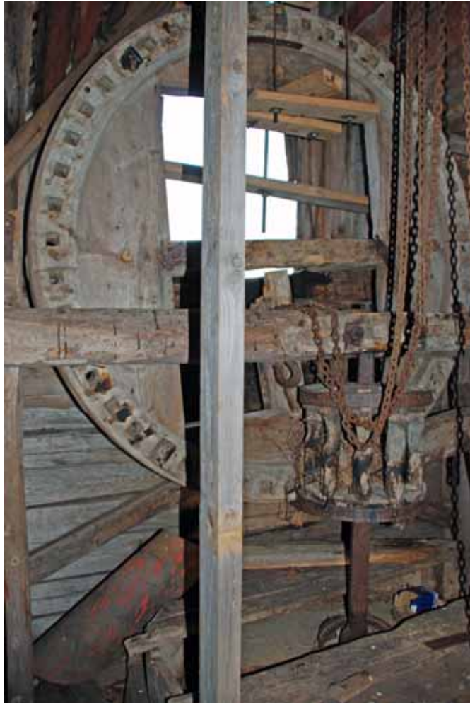
Kronhjulet efter att gångåsen demonterats. Flertalet kuggar saknas. Bildnr Ip20090487
