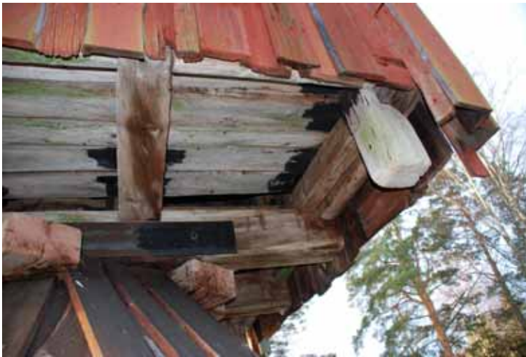
Kvarnhuse underifrån med bottenvåningens bjälklag. Bildnr Ip20090485
