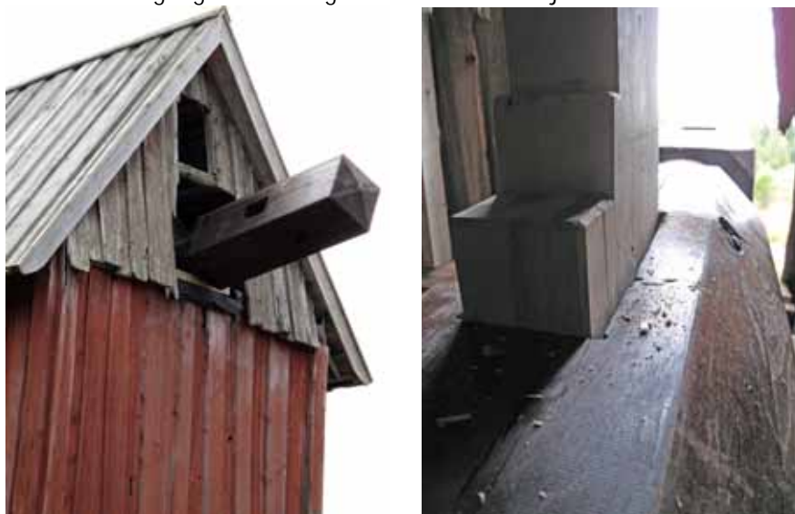
T.v. Den nya gångåsen på plats med hål för vingbalkarna. T.h. Den åttasidiga delen av gångåsen med kronhjulets infästning. Bildnr lp20090491 och lp2009092
