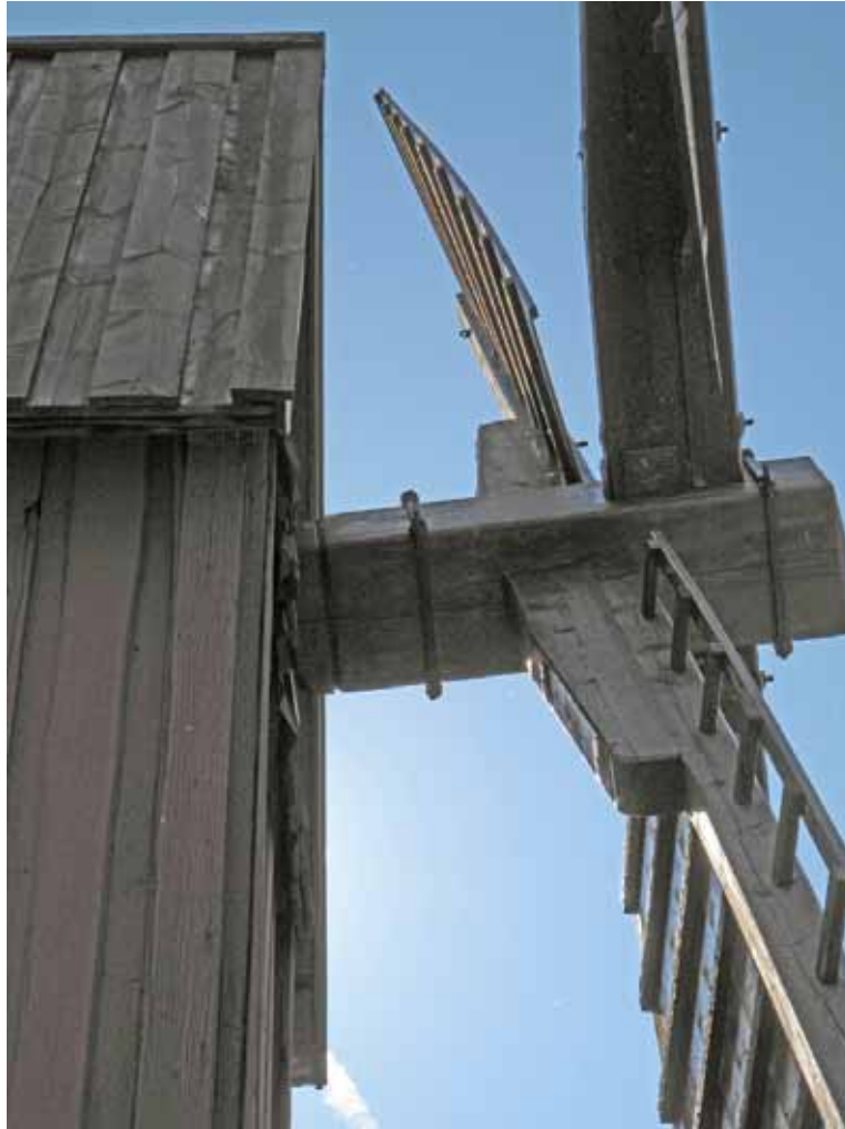
Vingstockarna är infästa i gångåsen. Bildnr lp20090500
