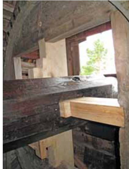
Kronhjulets balkar fästa i hjulet med dymlingar. Bildnr lp20090495 Balkarnas infästning i gångåsen. Bildnr lp20090496
