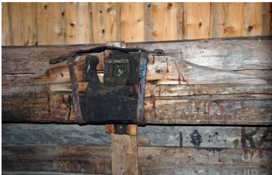
Kraftigt järnbeslag på kvarnhusets bakre gavel för infästning av gångsåsen vars bakre ände vilar i det s.k. lillagret. Bildnr Ip20090490
