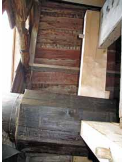
Kronhjulets balkar fästa i hjulet med dymlingar. Bildnr lp20090495 Balkarnas infästning i gångåsen. Bildnr lp20090496
