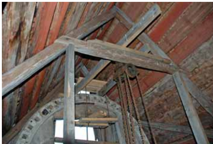
Kronhjulets läge i övre delen av kvarnhuset. Bildnr Ip20090488
