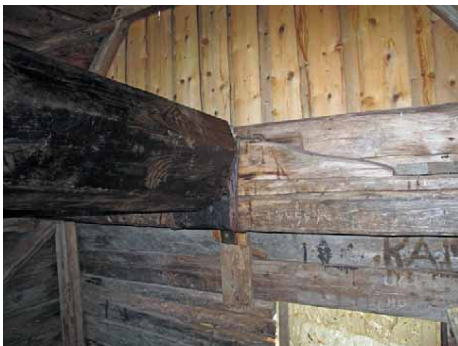
Gångåsen vilar i det s.k. lillagret i kvarnloftets bakre gavel. Lillagret är försett med ett löstagbart överfall som förhindrar att gångåsen hoppar ur lagret. Bildnr lp2009094
