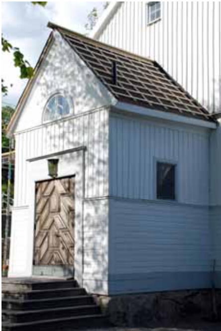
Vapenhusets tak med ny ströläkt och bärläkt lagt på tjärpapp från år 2000. Bildbeteckning lp20090553 Foto Gunilla Nilsson
