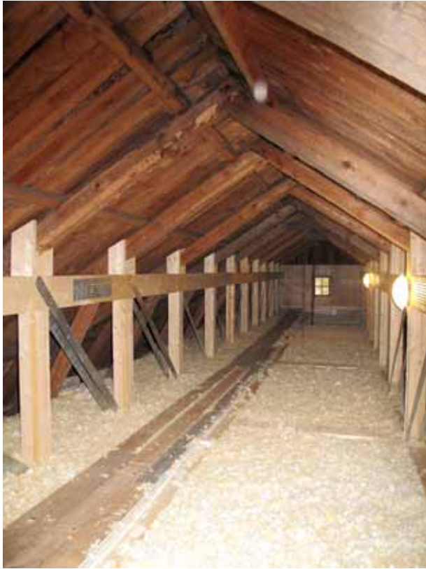
T.v. Vinden efter förstärkning av takstol och gavlar. T.h. Ny fackverkskonstruktion infäst i den gamla takstolen. Bildbeteckning lp20090525 och lp20090526. Foto Gunilla Nilsson 2009
