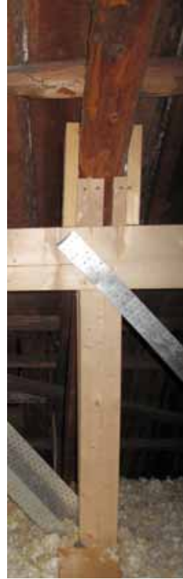
T.v. Vinden efter förstärkning av takstol och gavlar. T.h. Ny fackverkskonstruktion infäst i den gamla takstolen. Bildbeteckning lp20090525 och lp20090526. Foto Gunilla Nilsson 2009
