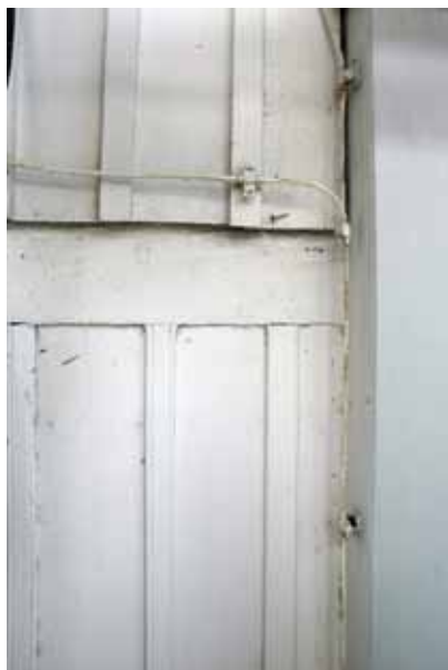
I östra gavelröset finns ny panel spikad på äldre panel troligen från tidigt 1800-tal. Bildbeteckning lp20090554 Foto Gunilla Nilsson
