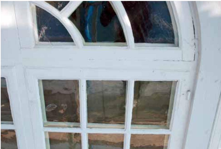
Fönster från 1800-talet. Bågar med träspröjs, blåst glas, tidstypiska gångjärn och hörnbeslag. Målat i vitt med grå omfattning på långhusets norra sida. Bildbeteckning Ip20090552. Foto Gunilla Nilsson 2009
