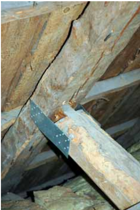
Knutpunkt med äldre förskjutning. Bildbeteckning Ip20090539,
