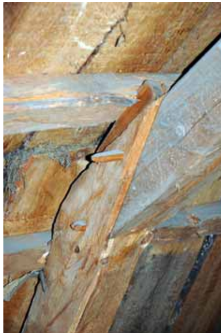
Kilar har tidigare slagits in mellan tak och takstol. Ip20090540 Foto Gunilla Nilsson 2009
