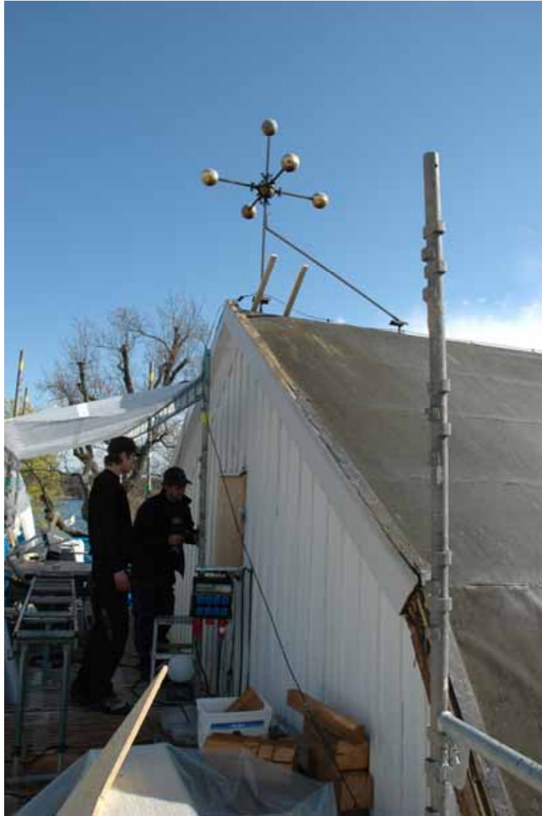
Tak med tjärpapp och kulkors före renovering, östra gaveln. Bildbeteckning Ip20090522 Foto Gunilla Nilsson
