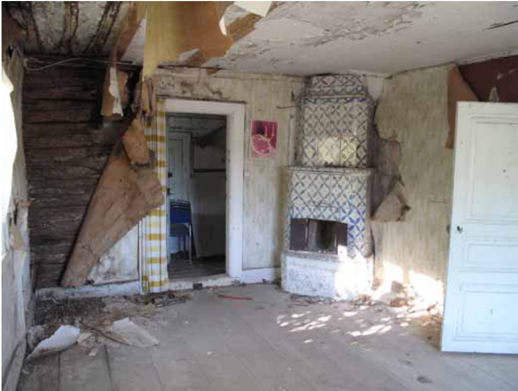
Rum 2 med hallen i fonden. Breda golvbrädor och dekorativ kakelugn. På innerväggar sitter tapeterna direkt på timret, medan ytterväggarna är reveterade. Tapeter och takpapp lossnar och drar med sig hela sjök. Bildnr lp20090516. Foto Cecilia Pantzar.
