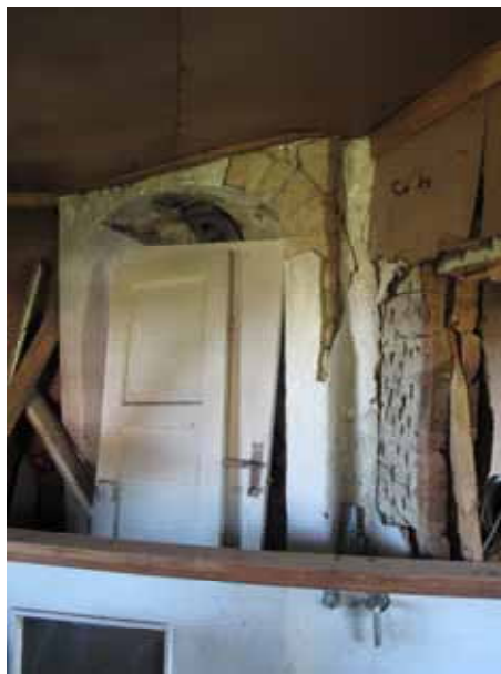
Tv. Rum 4. I det inre hörnet finns en rörspis. Till höger om rörspisen syns resterna av den nu avkapade mellanväggen som har löpt mellan rum 4 och 5. Th. Rum 5. Dörren leder till hallen. Taket är på väg att rasa in. Även bjälklaget har påtagliga rötskador lokalt. Här finns precis som i rum 4 ett akut behov av stämning. Bildnr lp20090521 och lp20090522. Bildnr. Foto Cecilia Pantzar.
