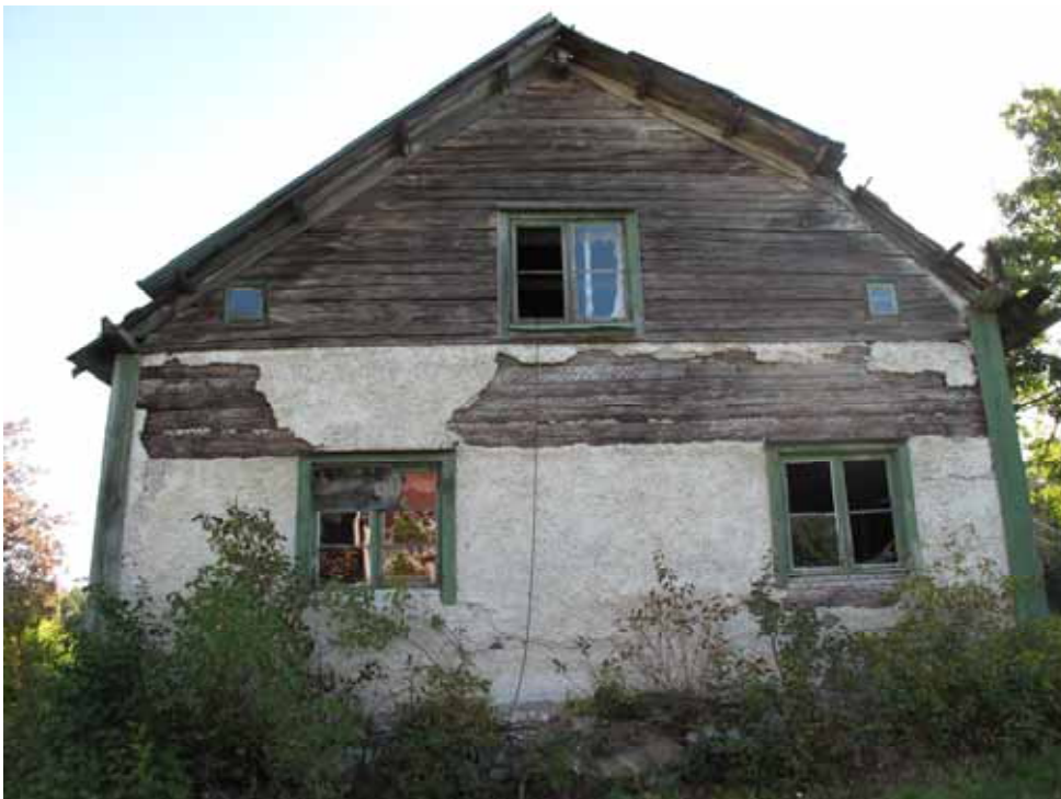
Västra gavelväggen har endast varit putsad nedtill. På gavelröset finns inte de träpluggar som finns på övriga fasadytor. Till vänster syns fönster av typ F1, till höger F2, i gavelröste finns ett av typ F2 och två mindre gluggar av typ F5. Bildnr lp20090509. Foto Cecilia Pantzar.
