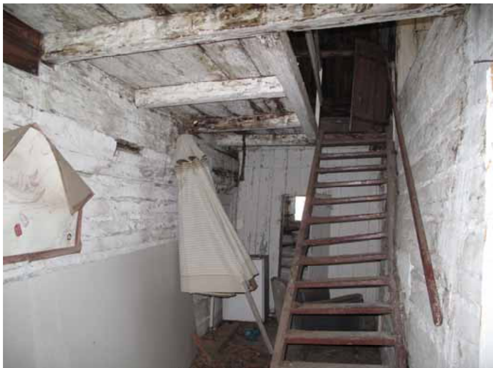
Hallen åt norr, med vindstrappa. De vitmålade timmerväggarna löper genom hela husets bredd. Bildnr lp20090512. Foto Cecilia Pantzar.
