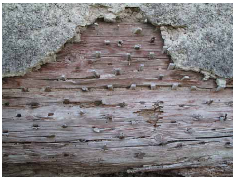
Fasaderna har tätt sittande träpluggar tillfogade i samband med att timmerväggarna blev överputsade med den i stora delar bevarade spritputsen. Lagg märke till den röda avfärgningen, spår efter färgsättning före putsens tillkomst. Bildnr lp20090505. Foto Cecilia Pantzar.
