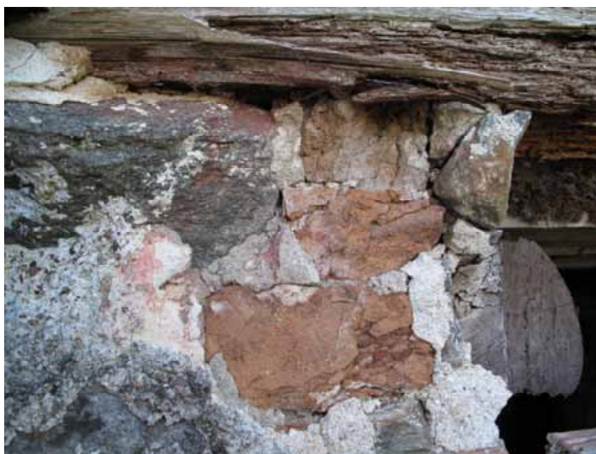
På norra långsidans sockel finns kvarvarande kalkputs med spår efter rosaröd avfärgning. Till höger skimtar ingången till källaren. Bildnr lp20090531. Foto Cecilia Pantzar.
