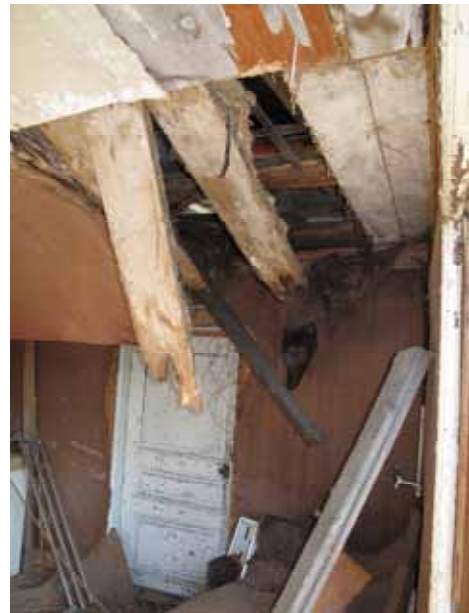
Tv. Rum 4. I det inre hörnet finns en rörspis. Till höger om rörspisen syns resterna av den nu avkapade mellanväggen som har löpt mellan rum 4 och 5. Th. Rum 5. Dörren leder till hallen. Taket är på väg att rasa in. Även bjälklaget har påtagliga rötskador lokalt. Här finns precis som i rum 4 ett akut behov av stämning. Bildnr lp20090521 och lp20090522. Bildnr. Foto Cecilia Pantzar.
