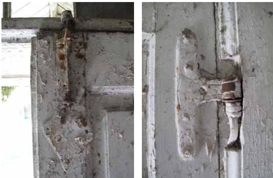
Beslag på portens insida. Till vänster ett låsbeslag och till höger ett gångjärn. Bildnr lp20090524 och lp20090525. Foto Cecilia Pantzar.
