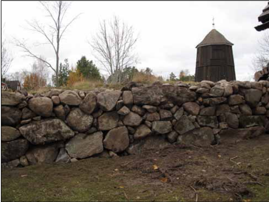
Omläggning av mur vid Malsta kyrka. Foto: Lisa Sundström. Bildnr: lp20090505.
