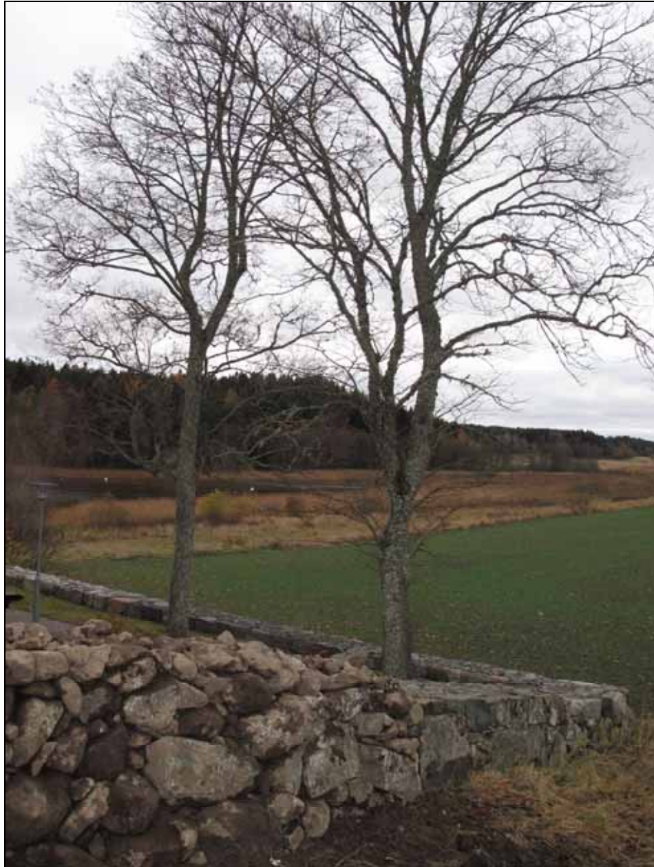
Omläggning av bogårdsmuren norr om kyrkan från den del som lades om under 1990-talet. Murdelen i väst är omlagd för ett 10-tal år sedan och är lagd med en alltför väl lagd karaktär. Foto: Lisa Sundström. Bildnr: lp20090507.
