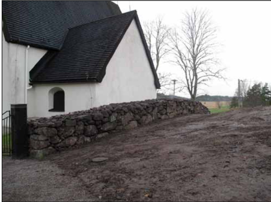
Efter omläggning av Malsta kyrkas norra bogårdsmur. Foto: Lisa Sundström. Bildnr: lp20090405.
