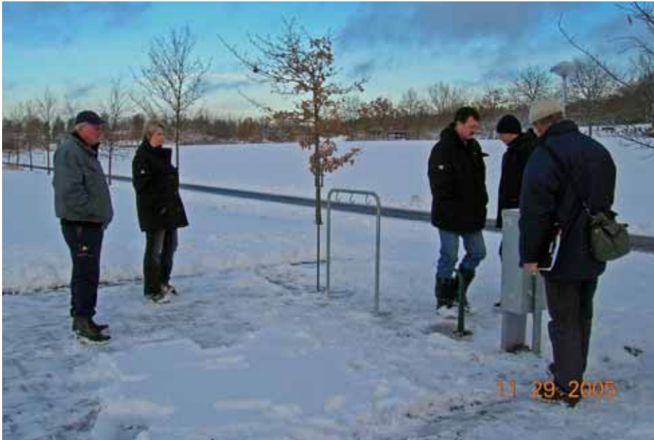
Besiktning av anläggningsarbetet i november 2005. Återstår plantering av träd och buskar. Bildnr lp20090561 Foto Gunilla Nilsson 2005
