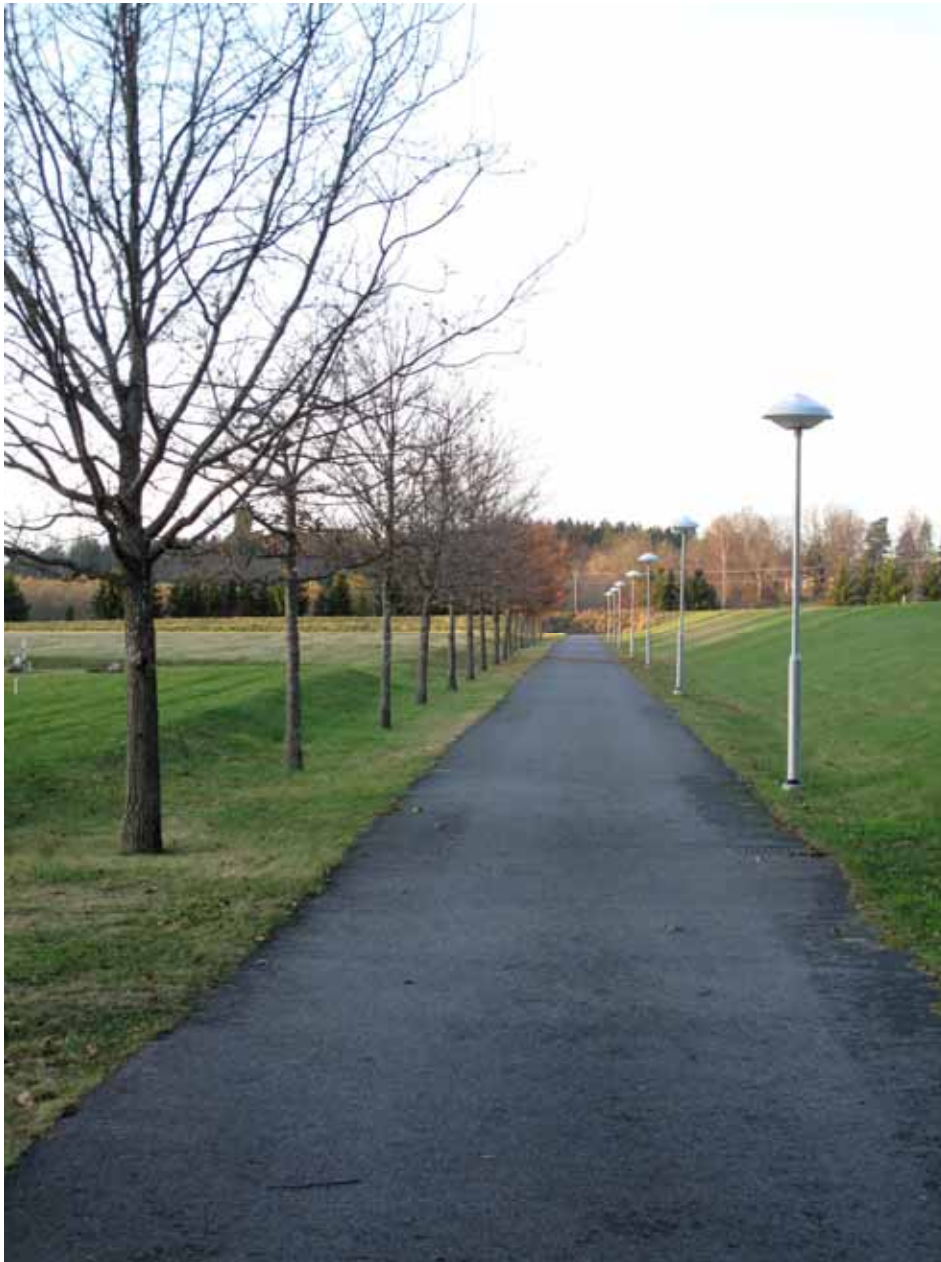
Gångvägen efter dränering och asfaltering. Ny belysningsarmatur på höga stolpar. Vänster om vägen ligger det för urngravar iordningställda kvarter nr 12. Den enkelsidiga allén med ekar är av äldre datum. Bildnr lp20090558 Foto Gunilla Nilsson, 2005.
