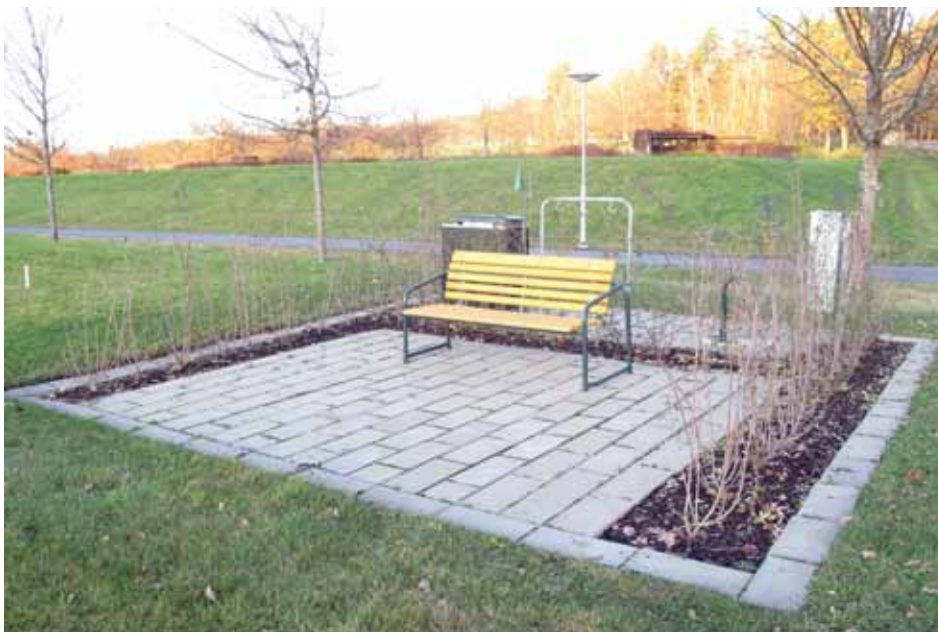
Redskapsplats i kvarter nr 12 med markbeläggning av betong, plantering med liguster samt redskapshållare, grönlackad vattenpost, elplint och markkuttag för slangbevattning. Bildnr lp20090562 Foto Gunilla Nilsson 2009
