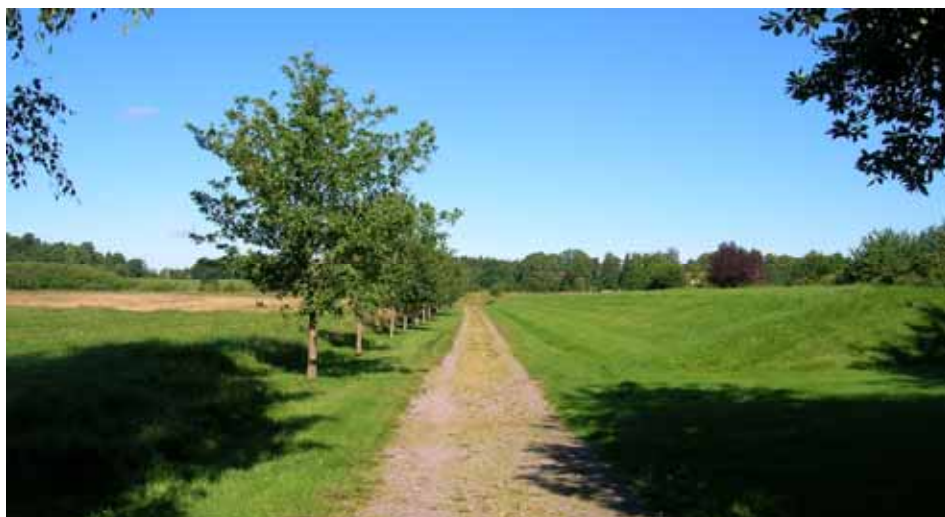
Gångvägen före omläggning. Till vänster om vägen syns kvarter nr 12 innan anläggningsarbetet startat. Bildnr lp20090557 Foto Gunilla Nilsson 2005
