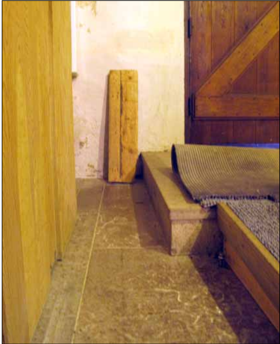
Fig 13. Trappplan med höjden 17 cm. Foto: Gunilla Nilsson, bild nr: lp20090577
