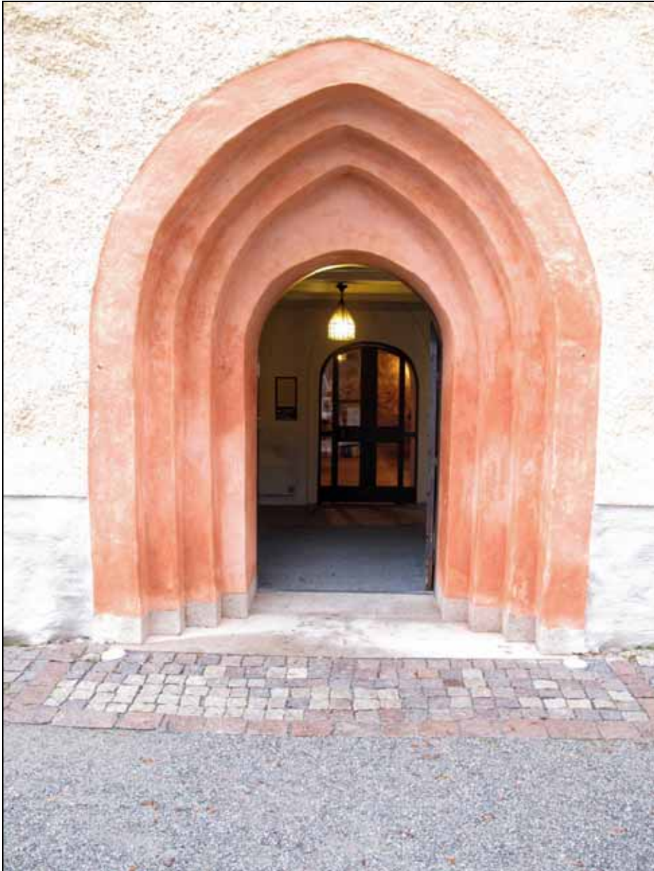
Fig 9. Marknivån utanför ingången ligger högre än golvet i vapenhuset. Foto: Gunilla Nilsson, bild nr: lp20090573
