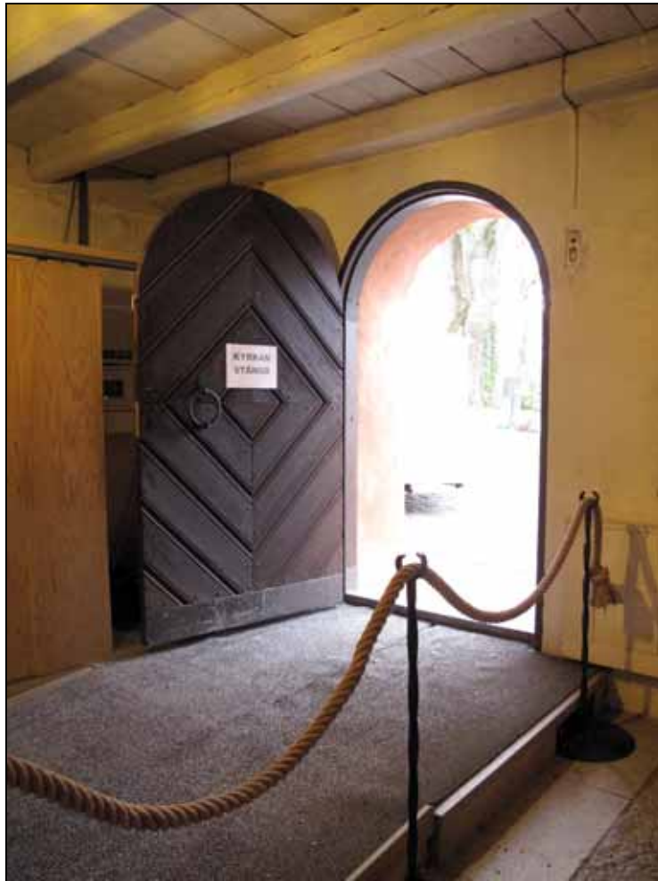
Fig 10. Nivåskillnaden överbryggas av en ramp i vapenhuset. Foto: Gunilla Nilsson, bild nr: lp20090574
