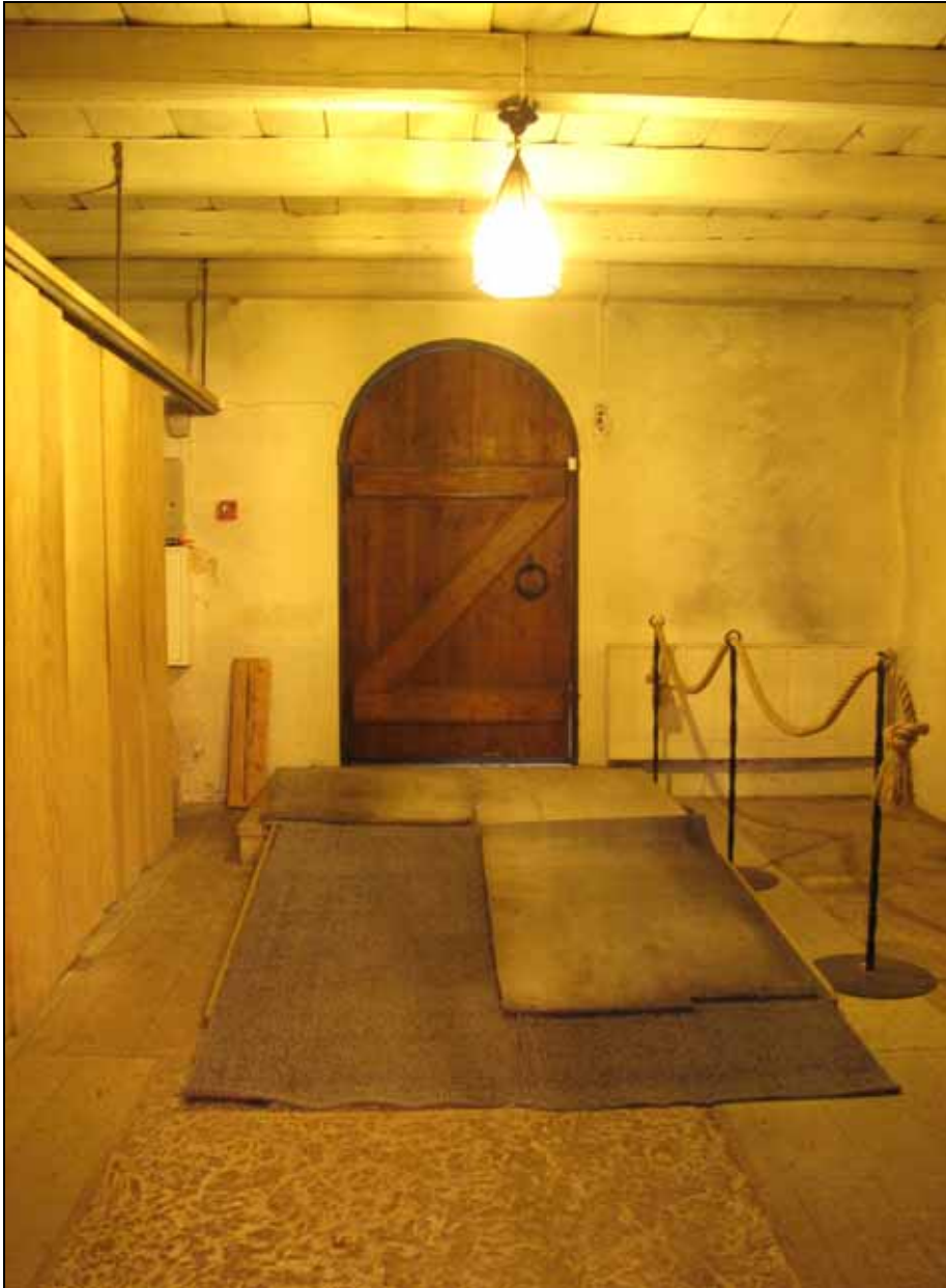
Fig 12. Golvet i vapenhuset är omlagt 1971 då även förvaringen längs östra väggen kom till. Fem gravstenar i golvet saknar alla troligen gravar under golvet. Trappplan med kalkstenshäll innanför dörren och löst liggande ramp av trä. Hela ytan täcks av gångmattor i grå plast. Foto: Gunilla Nilsson, bild nr: lp 20090576
