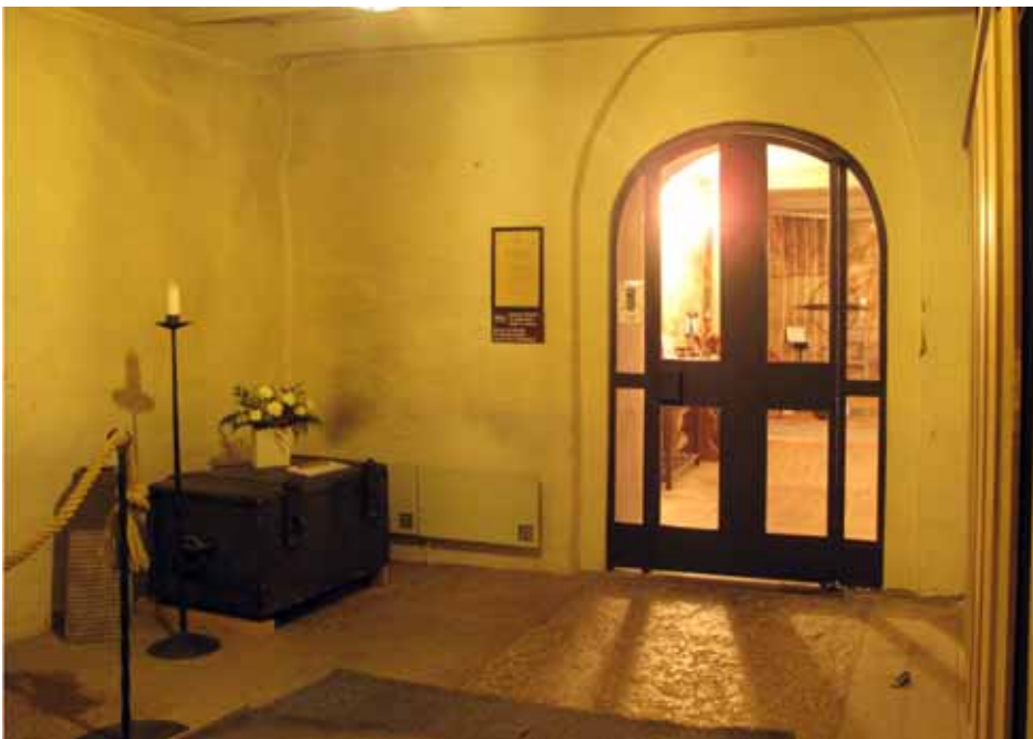
Fig 15. Vapenhuset mot nordväst. Långhusets sydportal med glasad enkeldörr från 1971. Trätaket skär över omfattningsbågen mot långhuset. Foto: Gunilla Nilsson, bild nr: lp20090579
