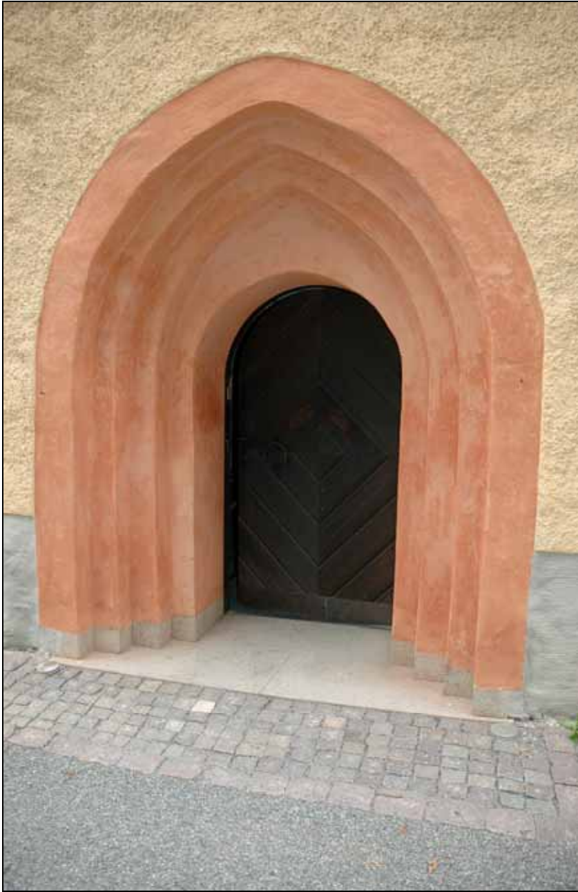
Fig 3. Portalens entréplan och sockel i granit ersatte 1971 tidigare kalkstensplan och putsade sockelhyllor av cement i den tresprångiga smygen. Foto: Gunilla Nilsson, bild nr: lp20090567
