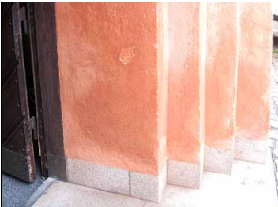
Fig 7. Portalens putsade språng med infäld stensockel och entréplan av krysshamrad granit från 1971. Dörrens träkarm är inhuggen i muren 1934. Tröskel med 7 cm anslag mot stålskott hörn. Foto: Gunilla Nilsson, bild nr: lp20090571
