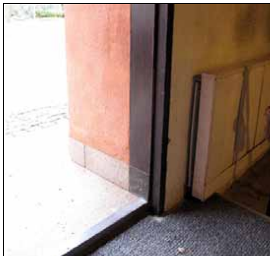
Fig 11. Detalj av karmens infästning i muren. Foto: Gunilla Nilsson, bild nr: lp20090575
