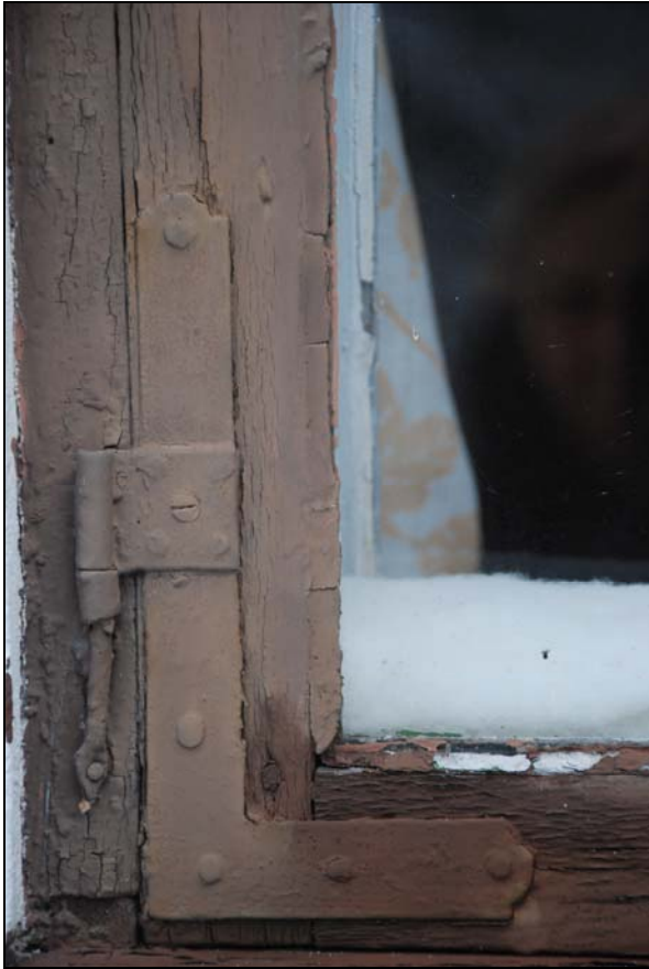
Gångjärn typiska efter 1800-talets mitt.
