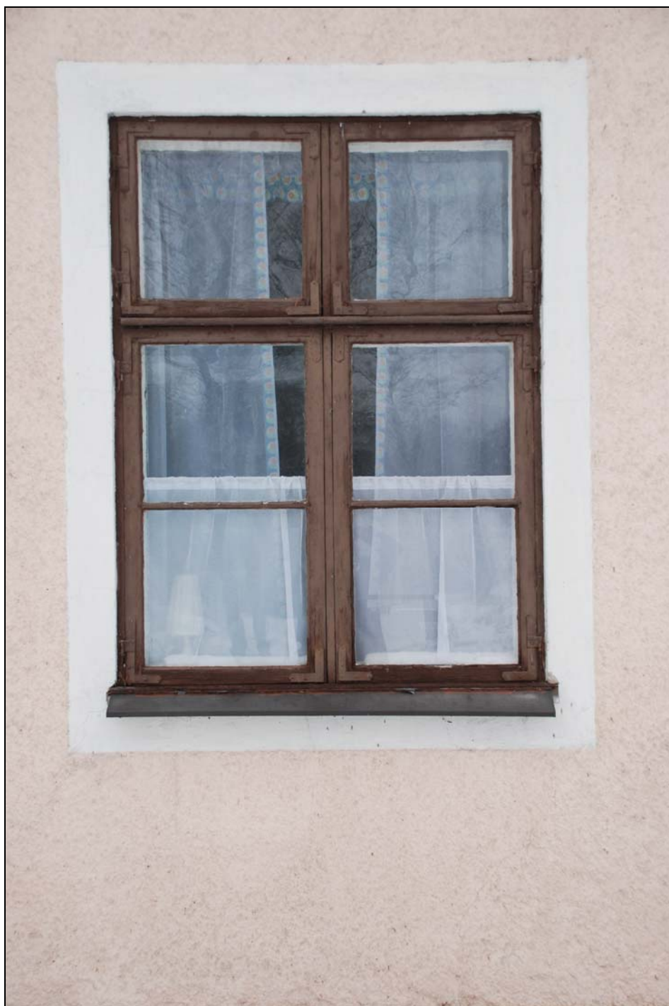
Ursprungliga fönstersnickerier och beslagning med tidstypisk 1880-talsutformning.
