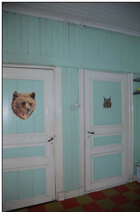
Trefyllningsdörrar till kök och skosal.
