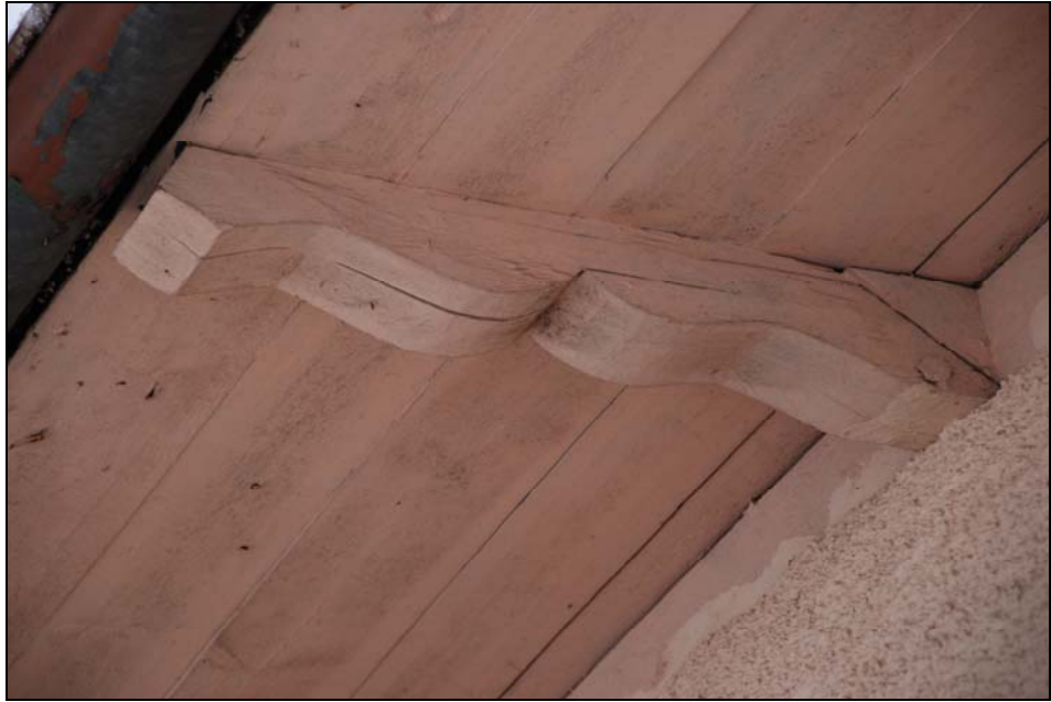
Utskjutande takfot med profilerade takkonsoler målade rosa.
