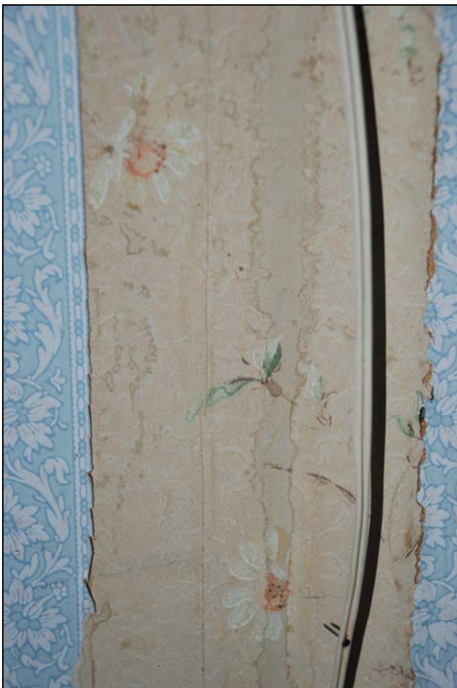
Underliggande tapetlager.
