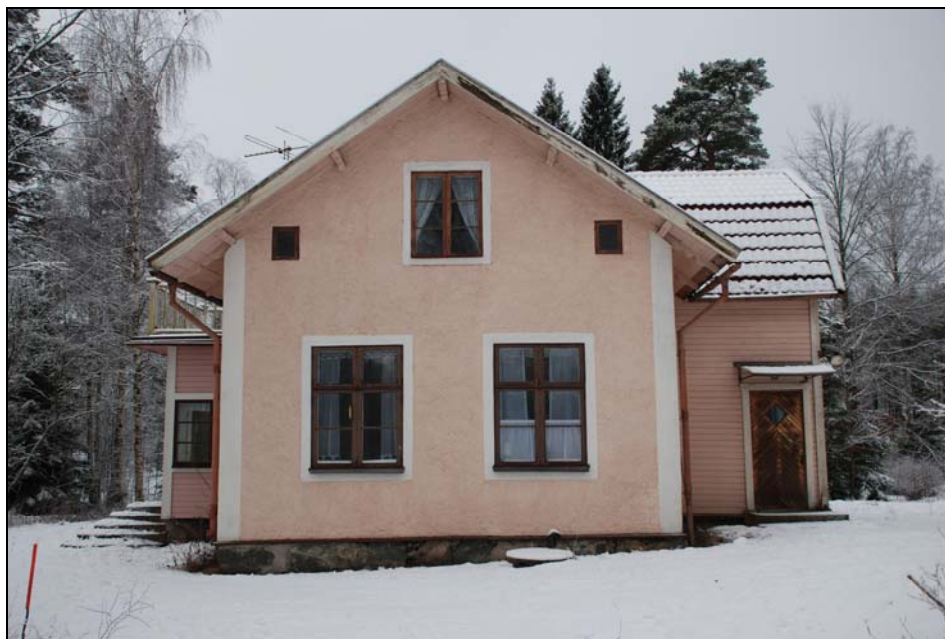
Lingsbergs gamla skola mot öster. Vindsfönster förstoraade 1927, kattvindsfönster upptagna 1927.
