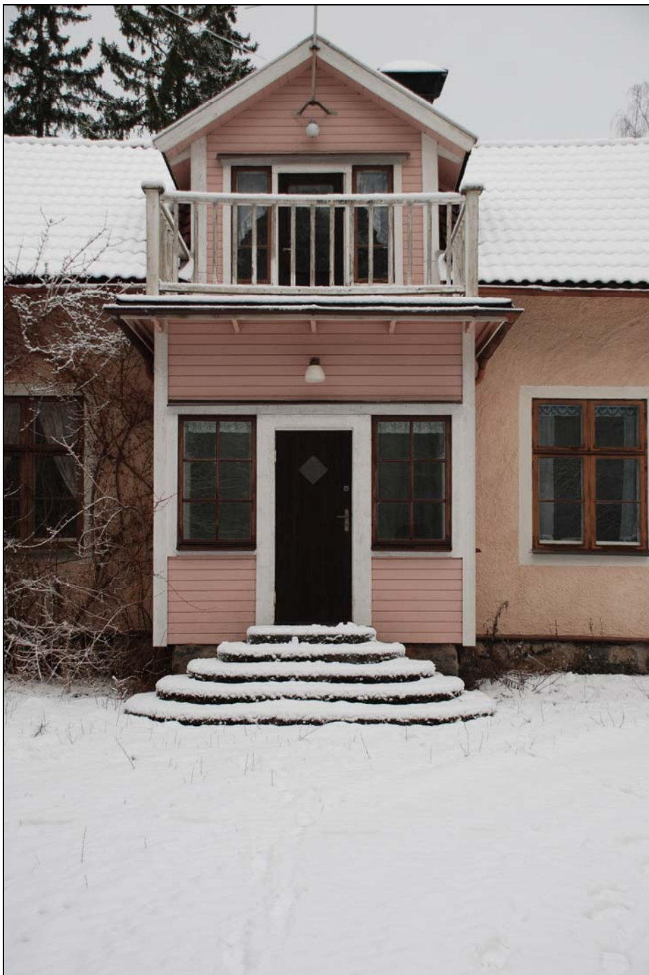
Farstukvist med fronton och överliggande balkong utförd 1927, renoverad 1977.
