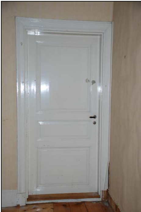
Trefyllningsdörr mot den norra farstukvisten (den ursprungliga entrén).
