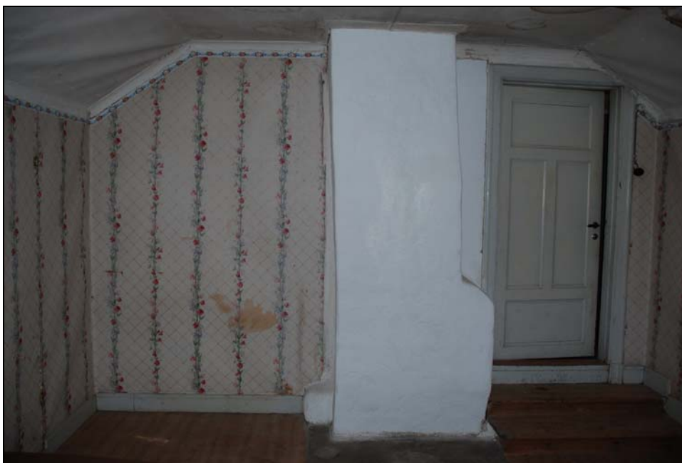
Vindskammare i öst med murstock.
