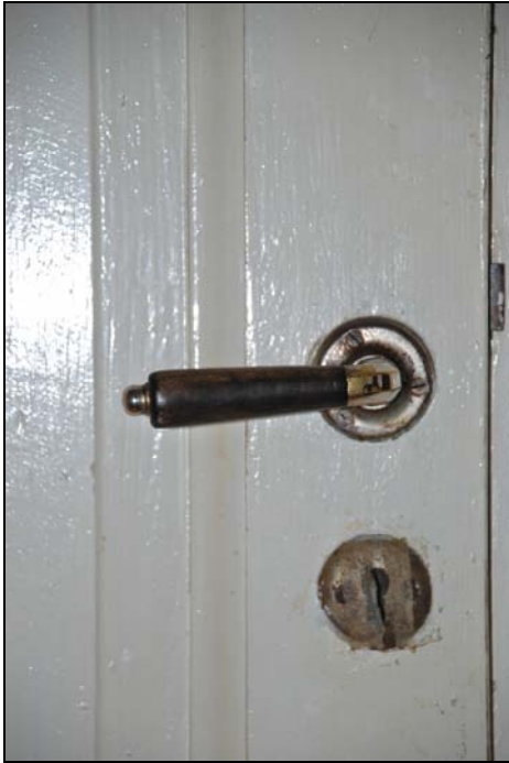
Dörrvred och nyckelskylt i dörr mot s. farstukvisten. Stolpgångjärn med konisk kula på dörrar.
