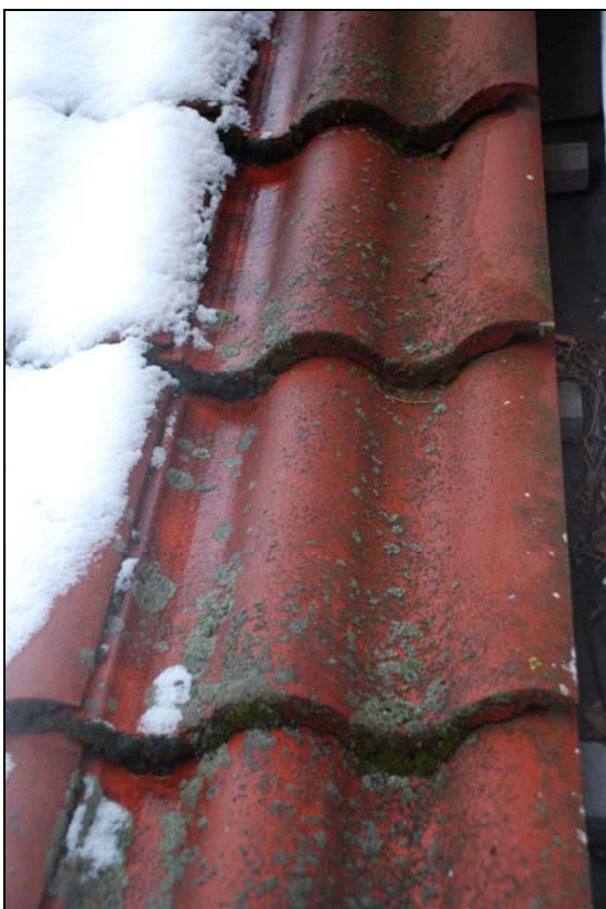
Tvåkupigt betongtegel lagt 1985.
