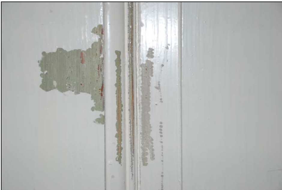
Underliggande färgskikt på dörrar med ljusgrå foder och speglar, gröngrå dörrramverk.
