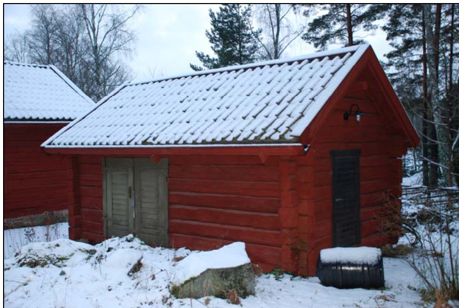
Förråd och dusch uppfört av timmer från en äldre byggnad i Vallentuna.
