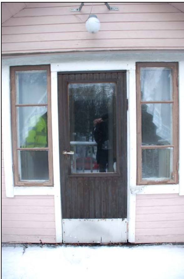
Den ursprungliga balkongdörren har ersatts mot ny i sen tid, intilliggande fönster från 1927.
