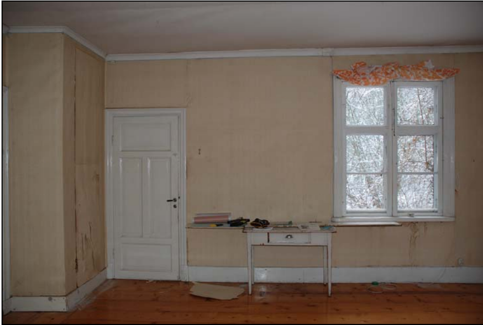
Skolsal. Dörr mot södra farstukvisten upptagen 1927 i tidigare fönsteröppning.
