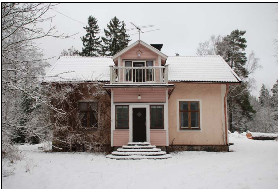
Lingsbergs gamla skola från 1884 åt Lingsbergsvägen med tillbyggd fastu med överliggande balkong från 1927, renoverad 1977.
