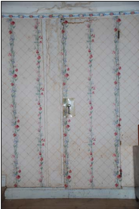
Tapetserad bräddörr till kattvind i kammare.
