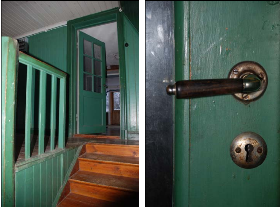
Norra farstuvistens andra våning med ingång till vinden, troligen inredd under 1920-talet.
