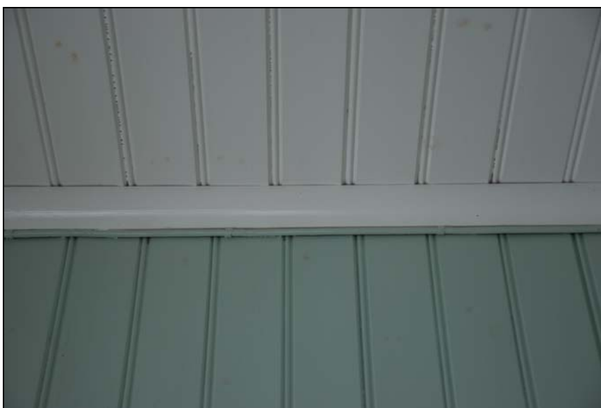
Pärilsponspanelade väggar och tak i farstukvist.
