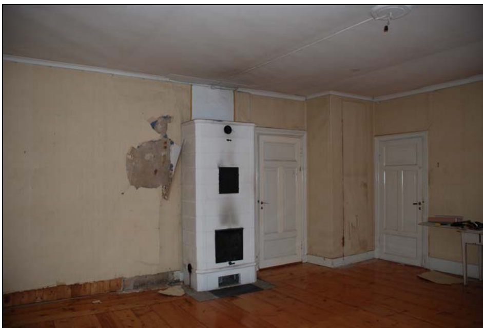
Skolsal med breda brädgolv. Kakelugn från Stockholms kakelugnsmakeri, 1977. Till vänster dörr mot kammare, till höger mot södra farstuvisten.
