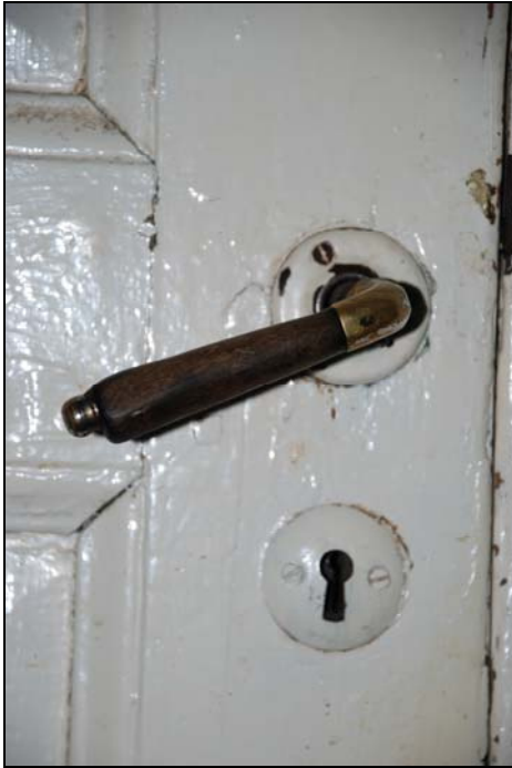
Dörrvred och nyckelskylt till trefyllningsdörrar i n. farstun.
