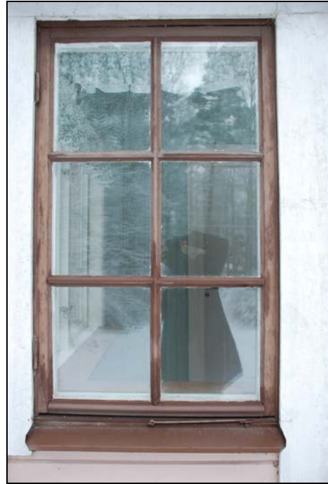
Fönstersnickerier i farstukvist, 1970-tal.
