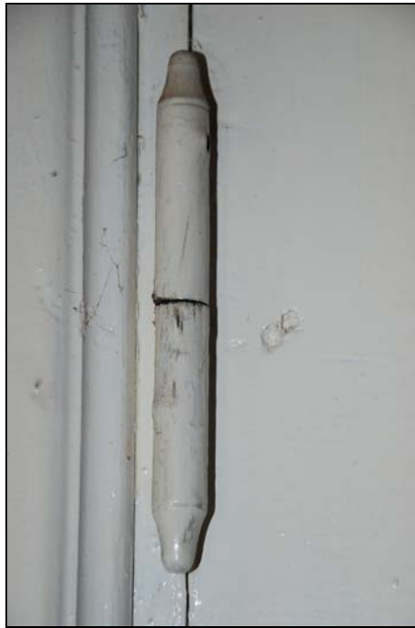
Dörrvred och nyckelskylt i dörr mot s. farstukvisten. Stolpgångjärn med konisk kula på dörrar.
