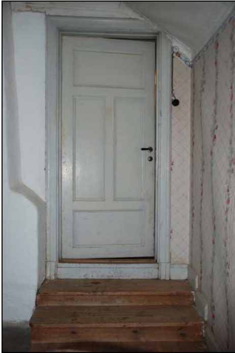
Fyrfyllningsdörr i kammare.
