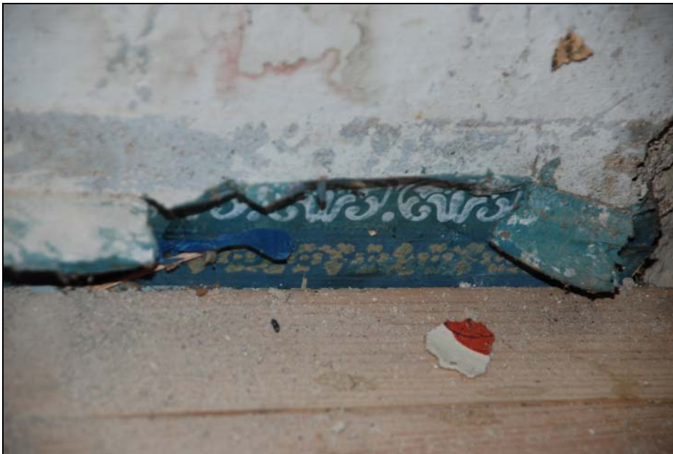
Spår på vägg kattvind med äldre tapet vid golv tyder möjligen på att vindsgolvet är sänkt.
