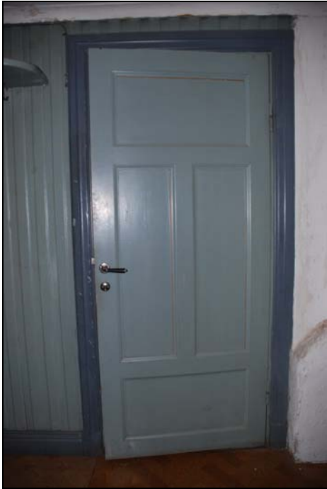
Fyrfyllningsdörr till kammare i öster.
