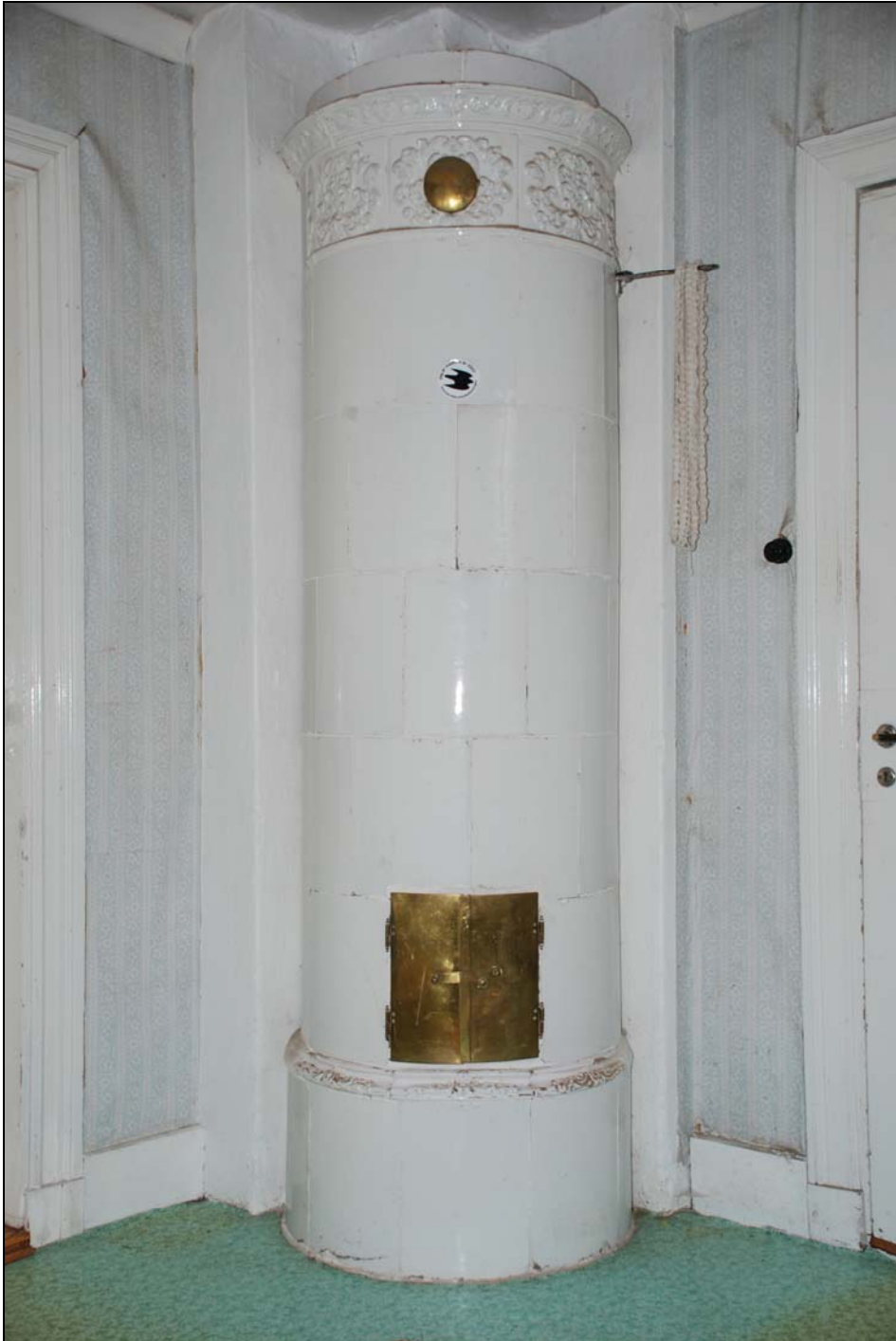
Rund kakelugn i kammaren från byggnadstiden 1880-tal..
