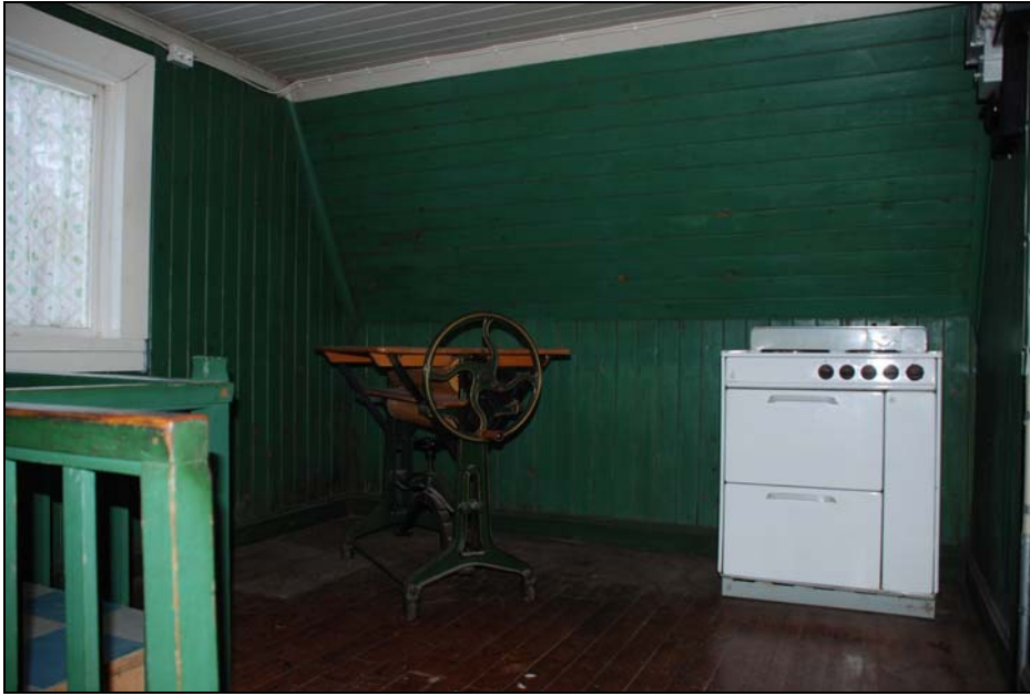
Farstuns andra våning med fasspontpanelade väggar och tak, fernissat brädgolv.
