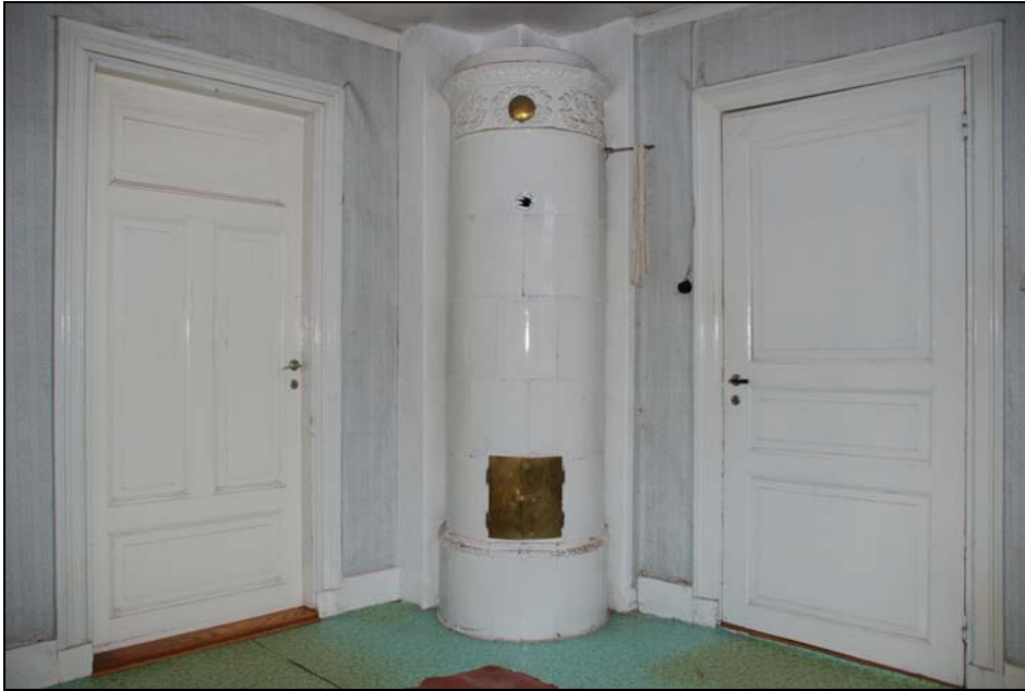
Fyrfyllningsdörr till sal till vänster, trefyllningsdörr till kök till höger i bild.
