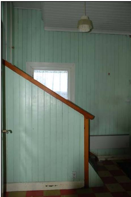
Fasspontpanelade väggar i n. farstun.
