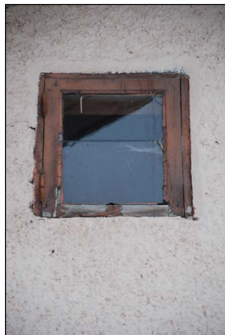
Fönster till kattvindar från 1927.
