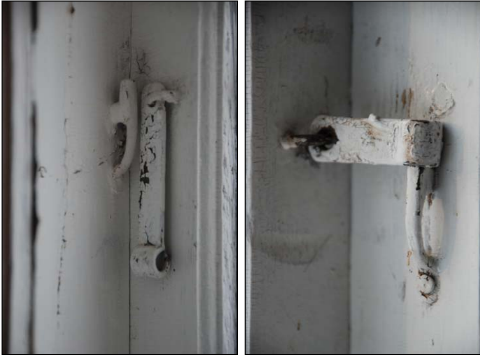
Raka uppställningsbeslag av 1800-talstyp på samtliga fönster.
