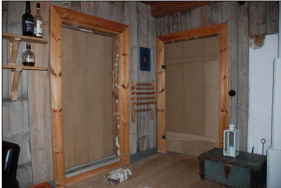
Dörrar och foder tillverkade i sen tid. Väggar klädda med slät, grånad panel.
