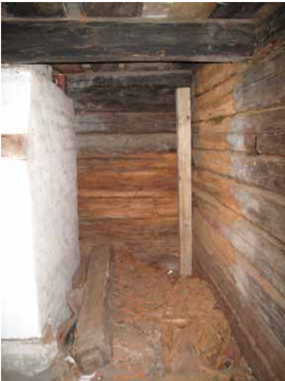
Sydvästra knuthörnet bakom den öppna spisen kompletterades med en stöd Stolpe. Utrymmet mellan spis och vägg har tidigare rymt en bakugn. Lp20110371.
