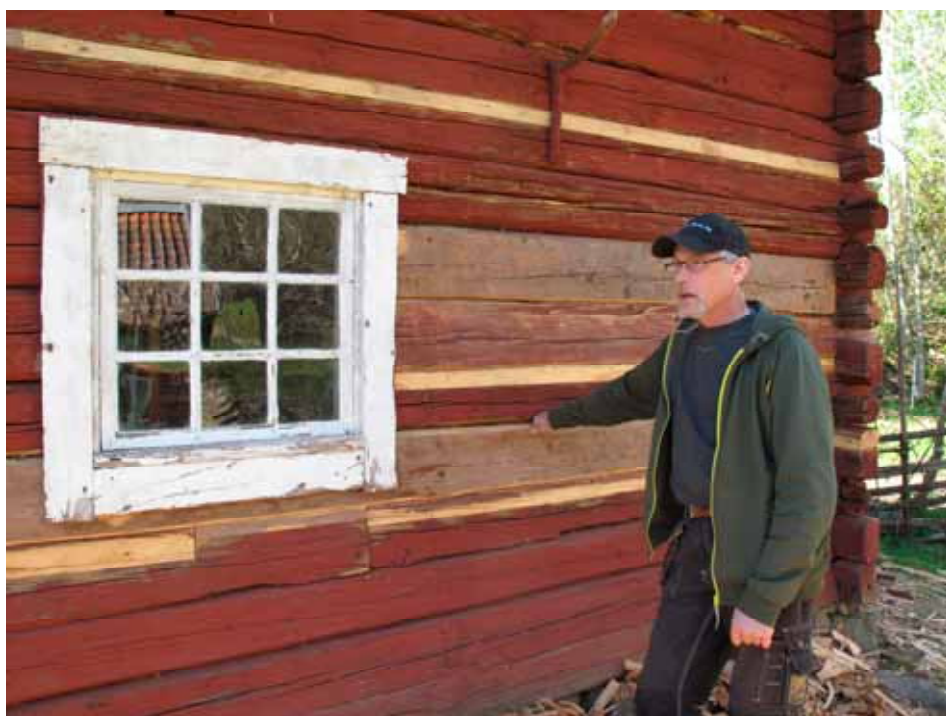
Ola Lundqvist framför nordväggen vid slutbesiktningen i maj. Lp20110370.
