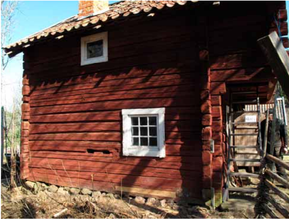
Sydfasaden efter lagning i syllen. Lp20110368.
