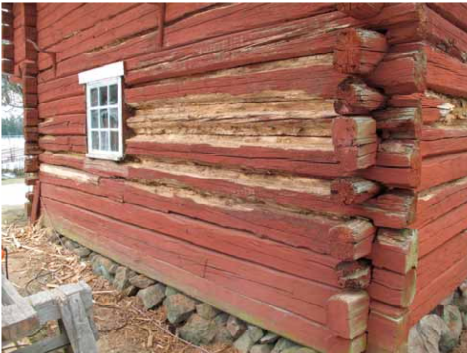
Nordfasaden efter rensning av rötskador. Lp20110377.
