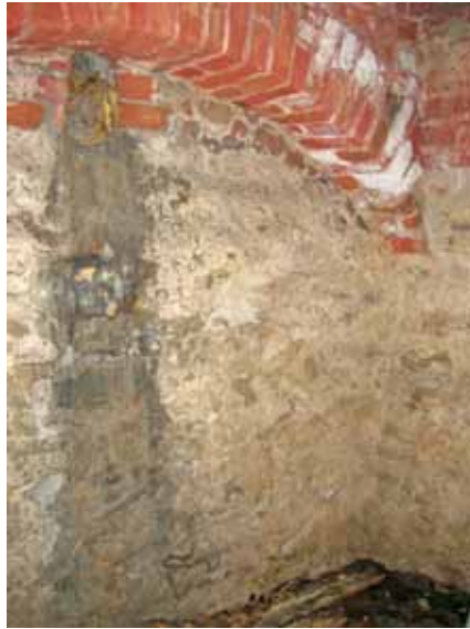
Avlastningsbåge vid östra muren med glugg igentäppt av skräp och löv. Bildnr: lp20100287 och lp20100288
