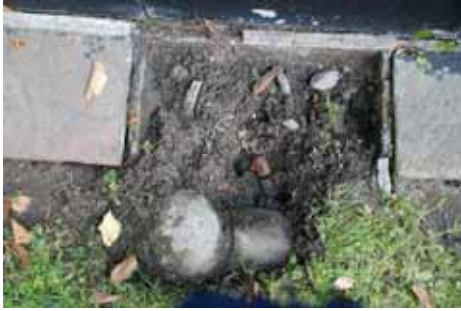
Plattor av sten lagda i en vagger av bruk med utjämmande grus och fogade med cement mellan plattorna och mot grunden. Bildnr: lp20100273 och lp20100274
