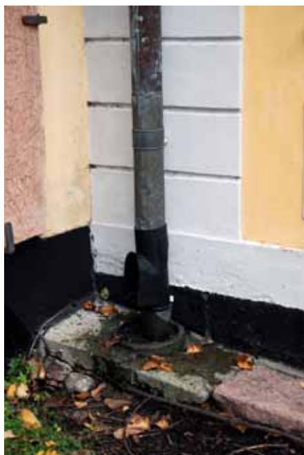
T.v. Stupspråk i hörn mot kyrkans långhus leder ner vatten från stora delar av kyrkans takfall mot söder. T. h. Stenläggning intill gravkoret lyftes upp och sparades. Bildnr: lp20100270 och lp20100271
