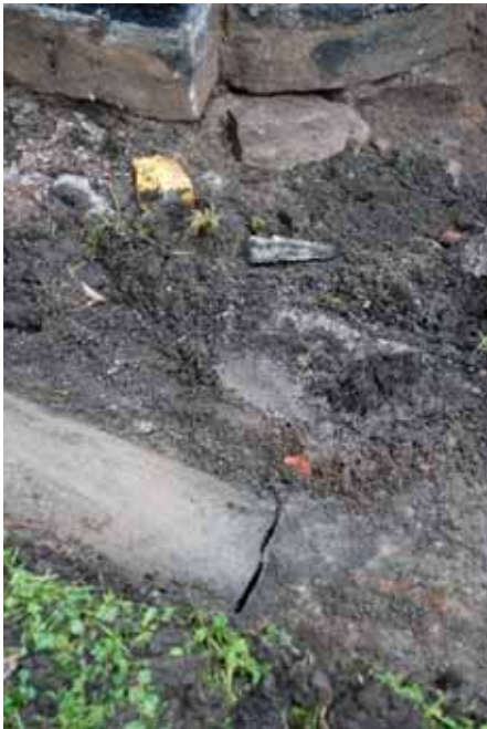
Tv. Brott på dagvattenledningen har orsakat läckage. Th. Del av ledningen vid gravkorets hörn är gjuten på plats. Bildnr: lp20100275 och lp20100276
