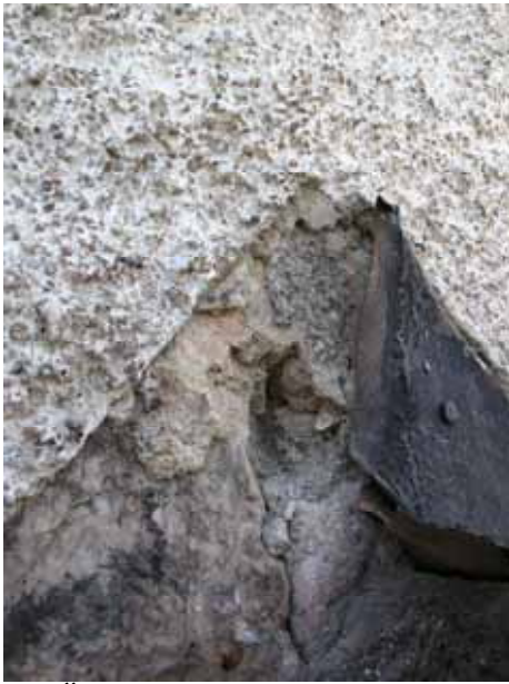
Tv. Äldre putsyta under västpartiets ståndskiva belägen på rundhusets västra fasad. Under den yttre spritputsen syns en äldre slät kalkputs med svagt gul kalkavfärgning. Th. Norra sidan av västpartiets taklag. Flertalet takstolar hade samstämmig streckad numrering på sparre, stödben och tass. Lp20100332 och lp20100347.
