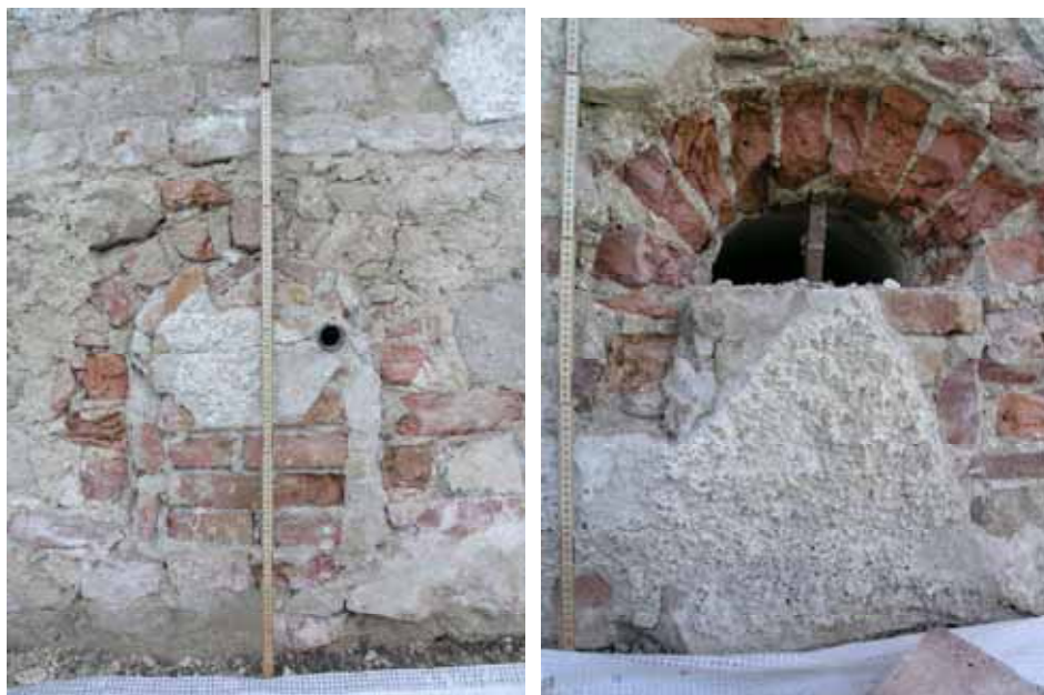
Gluggar i västpartiets västra mur. En ventil monterads i den redan delvis öppnade södra gluggen, bilden till höger. Lp20100337 och lp20100336.
