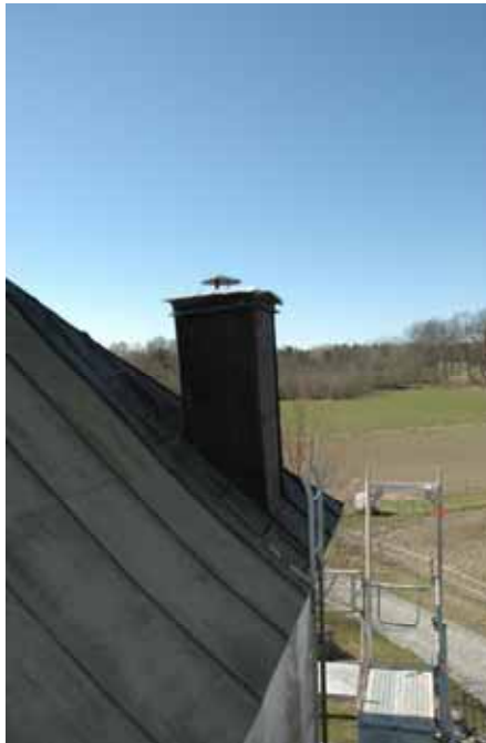
Tv. Västpartiets norra takfall före takläggning. Lagg märke till den nätta anslutningen mellan stånskiva och takfall. Th. Västpartiets norra takfall från nordöst före takläggning. Skorstenen revs. Lp20100300 och lp20100295.
