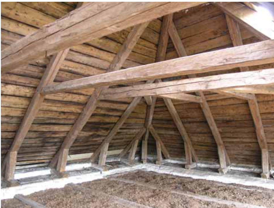
Vy från nordöst av taklag över västpartiet med bjälklag isolerat med torvströ. Lp20100329.
