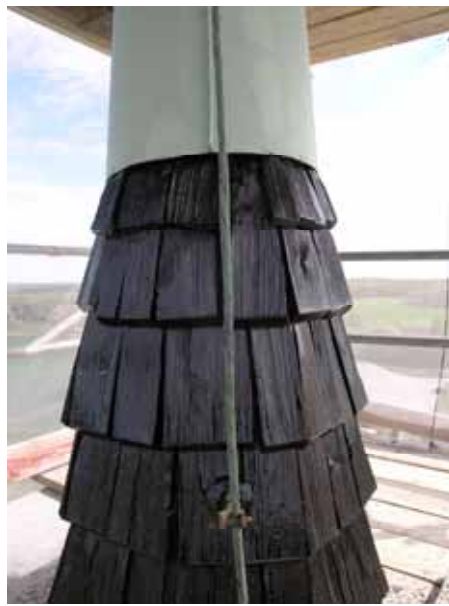
Spiran inspekteras av Ingemar Sundberg efter renovering. Nu med ny kopparhuv som har luftning i övre struten, förgyllt klot och tjärade takspån. Åskledarfästningen är ännu inte utbytt på bilden till höger. Lp20100324 och lp20100325.
