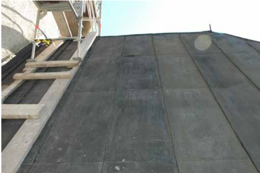
Norra takfallet före takläggning. Lp 20100302.
