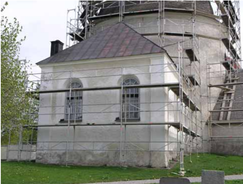
Västpartiet, det så kallade "bakkoret", från sydväst före takläggning och fasadarbeten.. Lp20100322.
