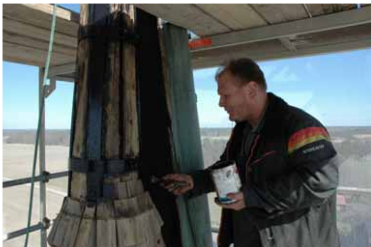
Toppspiran på rundhuset repareras. Både hjärtstock och järnband kunde bevaras. Järnringar och kopparhuv byttes ut. Lp20100296.
