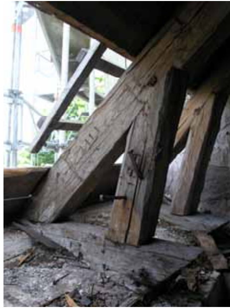
Tv. Äldre putsyta under västpartiets ståndskiva belägen på rundhusets västra fasad. Under den yttre spritputsen syns en äldre slät kalkputs med svagt gul kalkavfärgning. Th. Norra sidan av västpartiets taklag. Flertalet takstolar hade samstämmig streckad numrering på sparre, stödben och tass. Lp20100332 och lp20100347.
