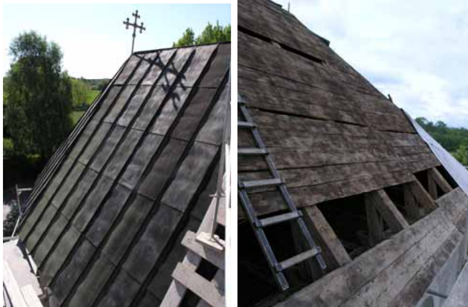
Tv. Korets plåttak före omläggning, norra takfallet. Th. Undertak på västpartiets norra sida. Lp20100320 och lp20100326.
