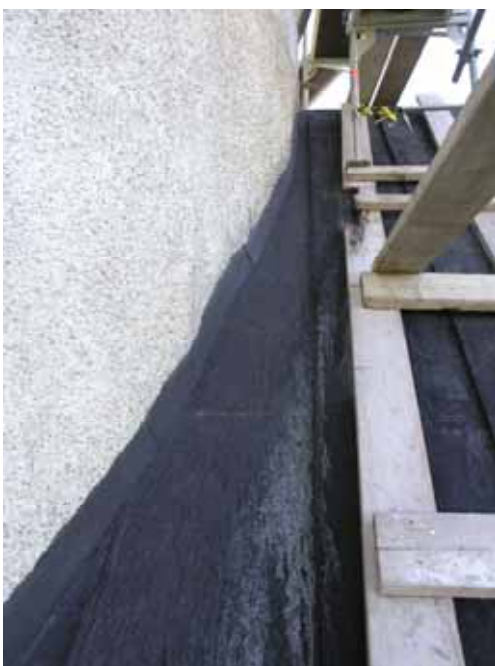
Tv. Västpartiets norra takfall före takläggning. Lagg märke till den nätta anslutningen mellan stånskiva och takfall. Th. Västpartiets norra takfall från nordöst före takläggning. Skorstenen revs. Lp20100300 och lp20100295.
