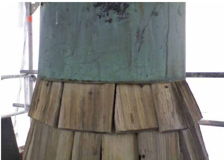
Rundhusets tornspira före renovering. Bild Lp20100312.
