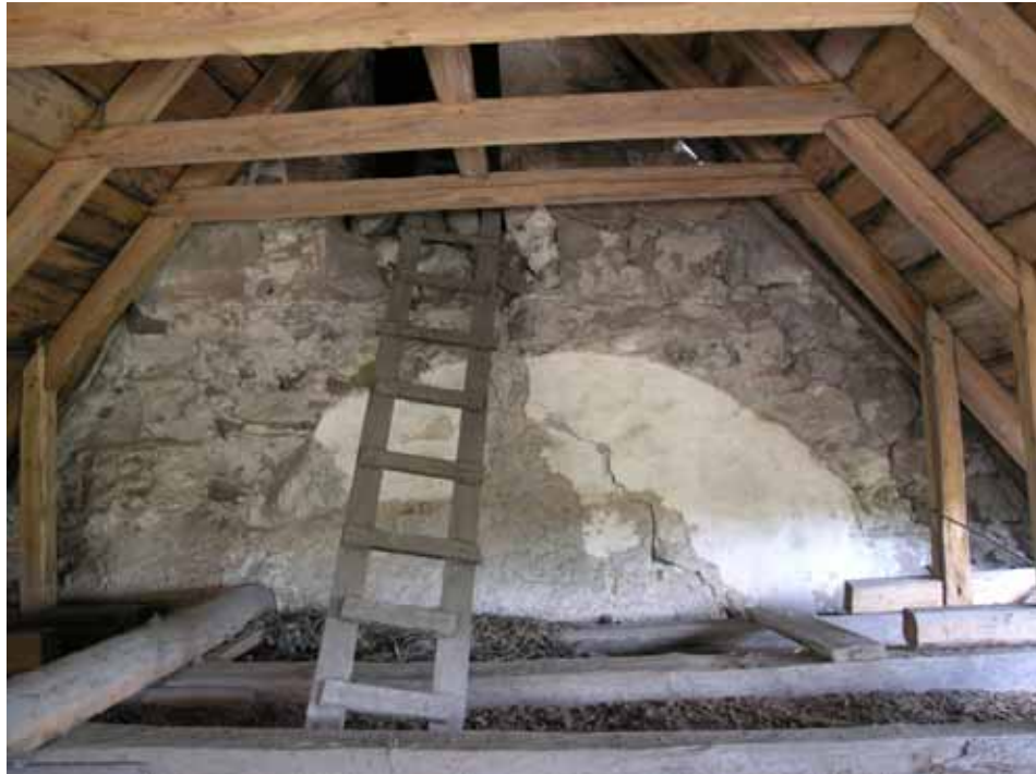
Rundhusets östfasad synlig på vinden över koret. Den slätputsade ytan tillhörde interiören i koret som fanns före korombyggnaden 1719. Putskanten sammanfaller med anfanget för ett rivet valv. Lp20100333.
