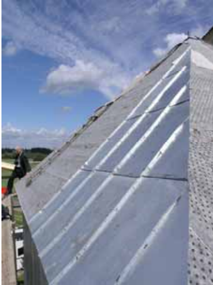
Tv. Västpartiet under takläggning från sydväst. Th. Västpartiet efter takläggning med ny variant på stånskiva och rännal. Jämför bilden ovan på samma plåtdetalj. Lp 20100331 och lp20100305.
