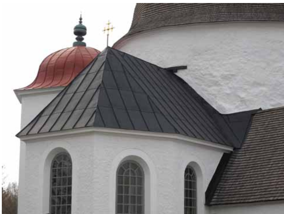
Koret från sydöst efter renovering. Det nylagda plåttaket ansluter till rundhuset med en mindre tilltagen ståndskiva än tidigare. Lp20100307.
