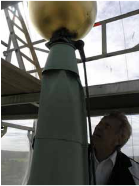
Spiran inspekteras av Ingemar Sundberg efter renovering. Nu med ny kopparhuv som har luftning i övre struten, förgyllt klot och tjärade takspån. Åskledarfästningen är ännu inte utbytt på bilden till höger. Lp20100324 och lp20100325.
