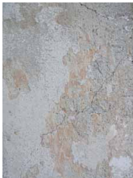
Tv. Slåtputsad pilaster med gula färgspår på västpartiets södra sida, pilaster mot rundhuset. Th. Slåtputs på Gierttas gravkor, västra sidan, med spår efter röd avfärgning. Lp20100303 och lp20100346.
