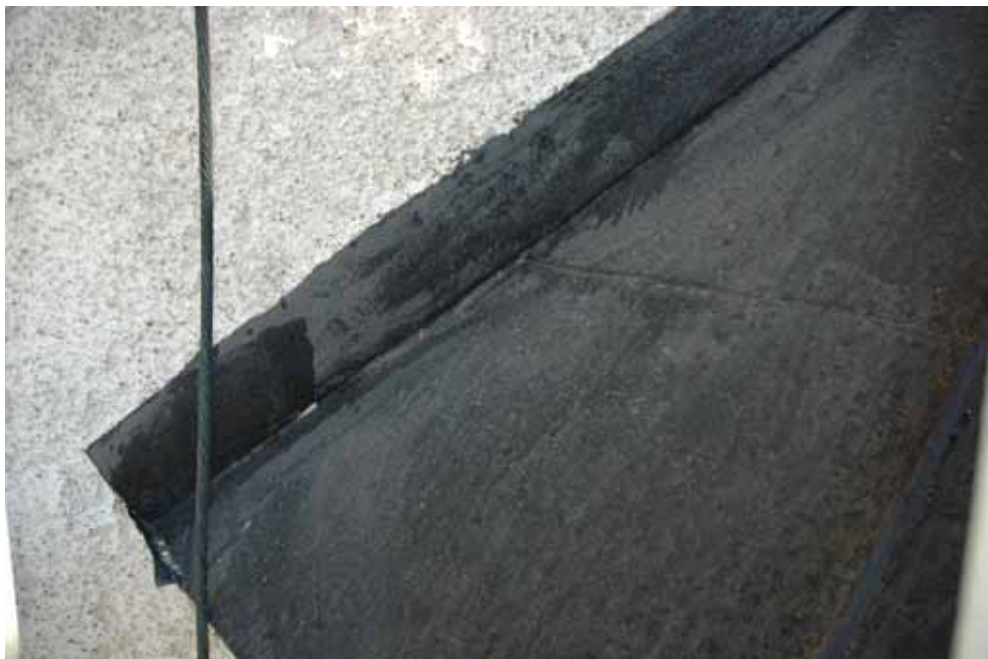
Detalj av västpartiets nordöstra hörn före takläggning. Takfoten närmast fasaden hade en nätt uppvikt ständränna för vattenavledning. Lp20100301.
