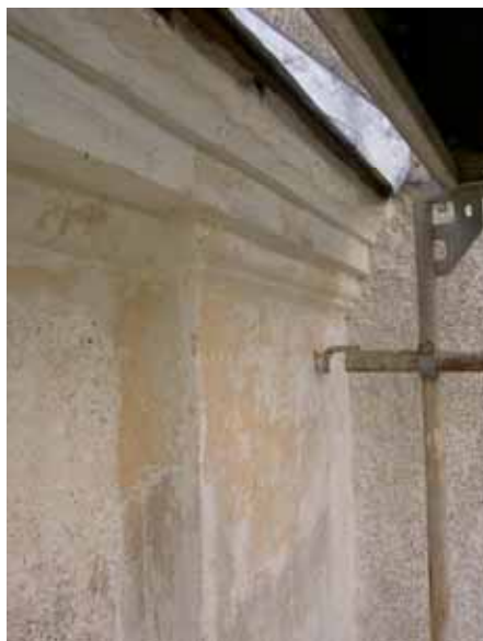
Tv. Slåtputsad pilaster med gula färgspår på västpartiets södra sida, pilaster mot rundhuset. Th. Slåtputs på Gierttas gravkor, västra sidan, med spår efter röd avfärgning. Lp20100303 och lp20100346.
