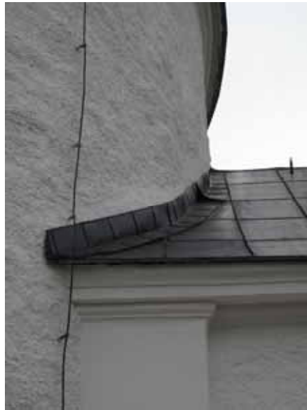
Tv. Västpartiet under takläggning från sydväst. Th. Västpartiet efter takläggning med ny variant på stånskiva och rännal. Jämför bilden ovan på samma plåtdetalj. Lp 20100331 och lp20100305.
