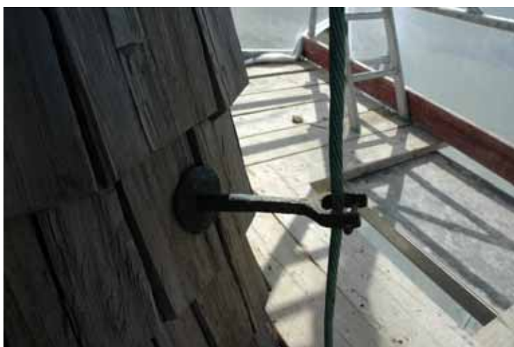
Äldre infästning för åskledare som ersattes av nya mindre fästen. Endast ett bevarades. Lp20100299.
