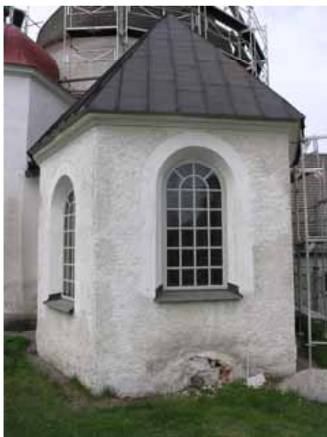
Tv. Koret före renovering. Lägg märke till den igenmurade gluggen tillhörande gravkammaren, som är delvis synlig i östfasadens nedre del. Th. Målning av fasader. Lp 20100318 och lp20100341.
