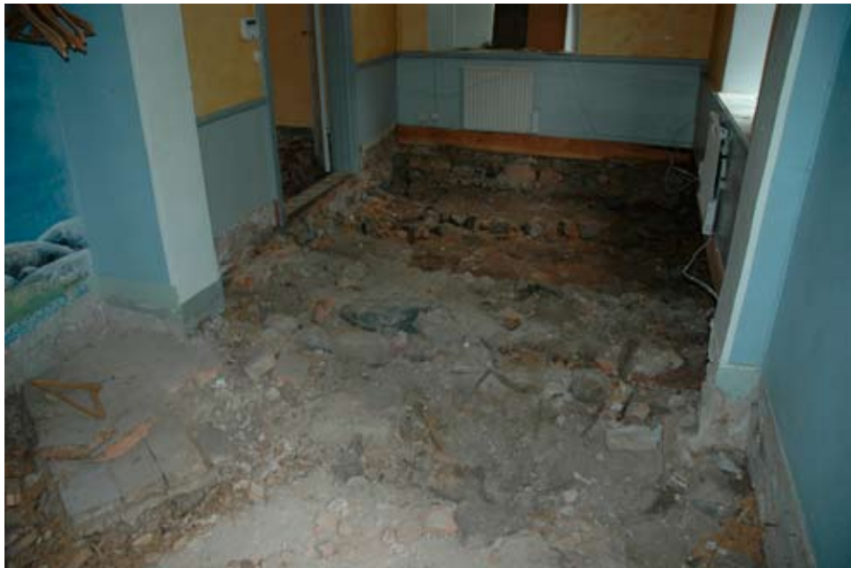
Fig 8. Obj 15 & 16. Till vänster i bild syns fundament till en kakelugn från den nuvarande byggnaden. Rummet bakom har en stenläggning som är något svårtolkad.
