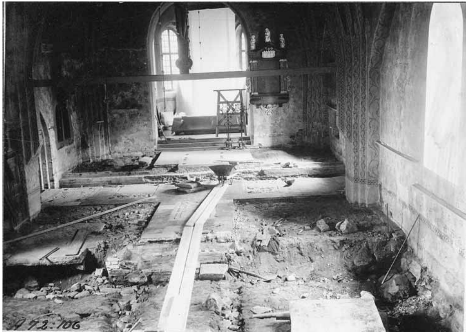
Vy över kyrkans östra del under invändig renovering 1934. Bilden visar bland annat att provschakt 1 och 5 troligtvis inte berördes av 1930-talets golvarbete. Kalkstensplattorna ligger kvar på dessa ytor. Från kulturmiljöbild, ATA
