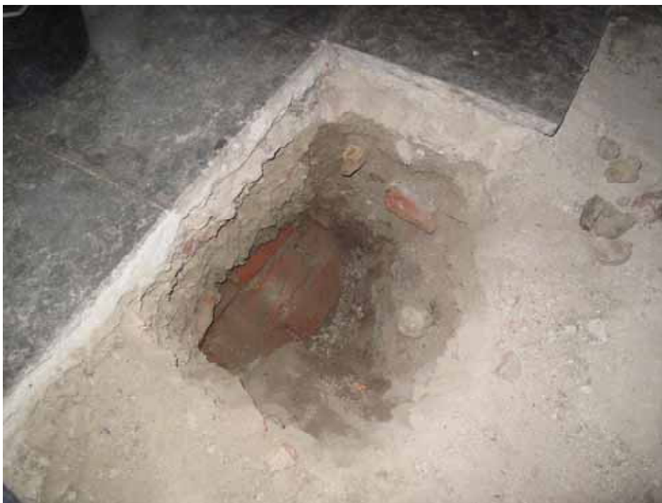
Tegelvalvet skymtar fram i södra delen av schaktet. Halvstensvalv fogat med kalkbruk. Lp20100455
