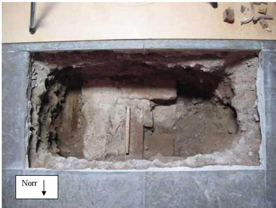
Vy över schakt 3. Tegelmuren löper i schaktets mitt. Till vänster syns bjälken som delvis är dold av schaktkanten. Lp20100462
