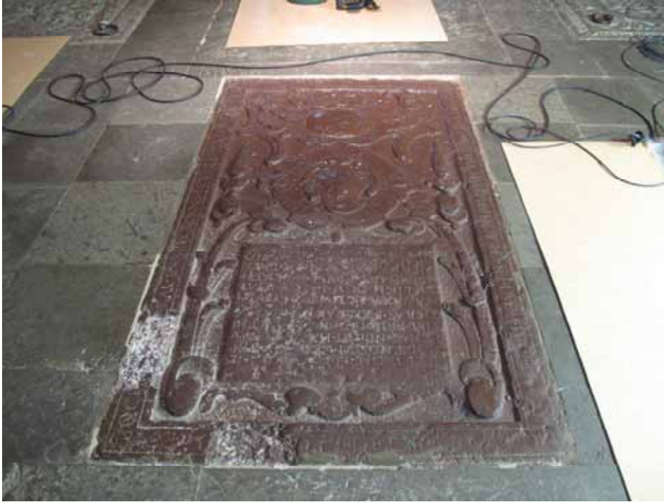
Gravhällen, över Boghart Kruse död 1635, är mycket fuktig i den övre delen. Nere till vänster syns spjälkningsskador till följd av saltutfällning. Lp20100460
