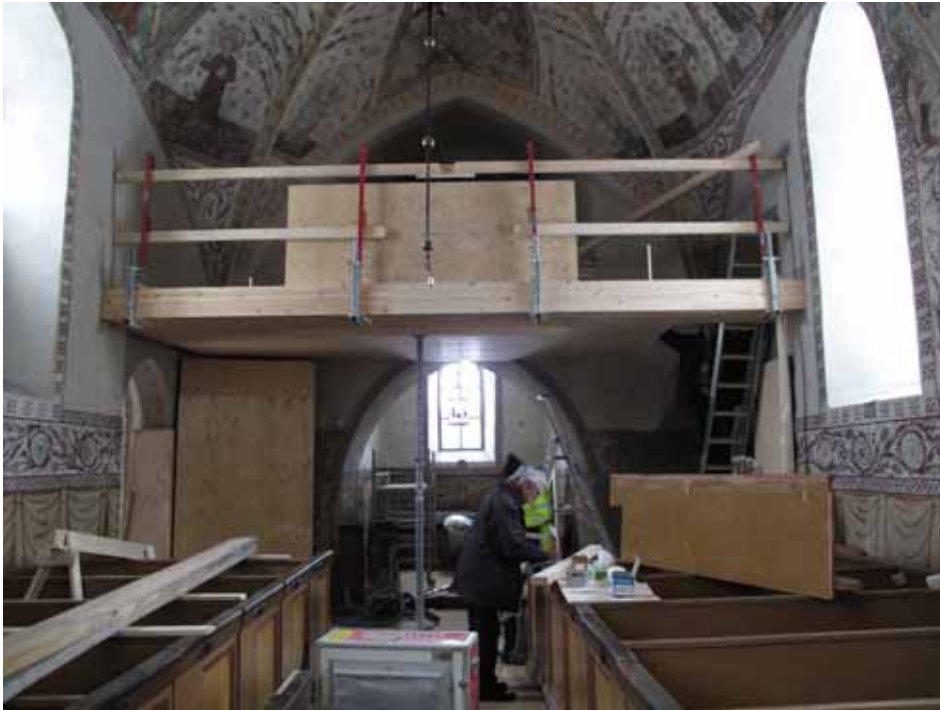
Läktaren under uppbyggnad. Lp20100536.
