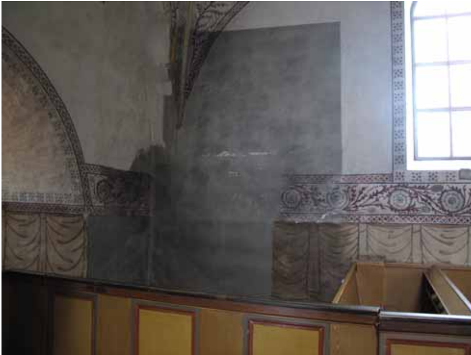
Väggytorna som frilades vid orgelbytet var målade med en gråaktig modern färg. Delar av bröstningen täcktes av färgen. I putsen iakttogs spår efter den tidigare läktartrappans utbredning. Den nya sammanfaller väl med den gamla. Lp20100543.
