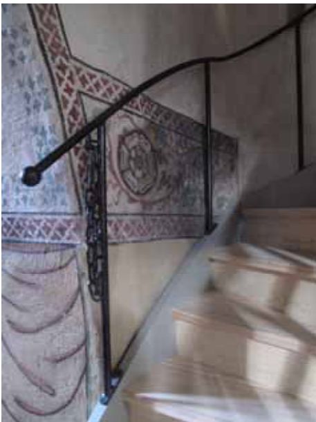
Tv. Västväggen med den nybyggda läktartrappan. Bården rengjordes och lämnades i övrigt som tidigare. Notera det smäckra trappräcket i svartmålade smide. Th. Svickeln i samma hörn behandlades på samma vis. De grå enfärgade ytorna målades in i den ljusa väggfärgen. Kalkmåleriet rengjordes och lämnades utan retuschering. Lp20100561 och Lp20100546.
