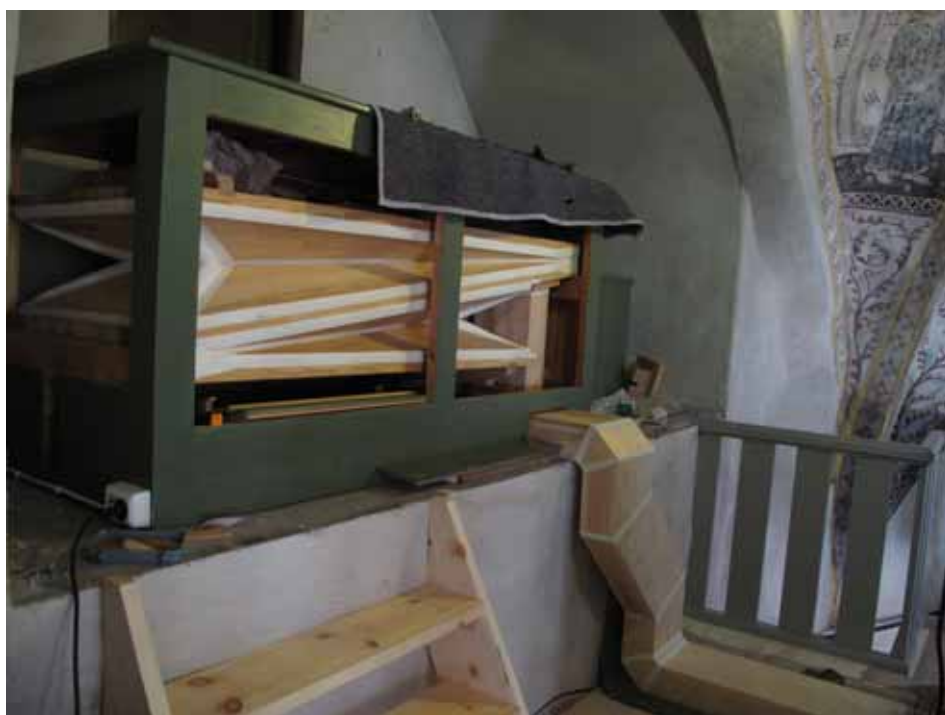
Bälglådan står på plats i nischen. Rördragningen mellan orgel och låda löper i den bortre trälådan. Trästegen närmast i bild placerades slutligen till höger om rörlådan. Lp20100564.
