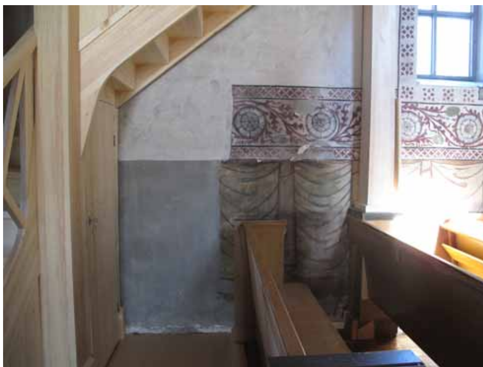
Läktaren täcker återigen delar av det nordvästra hörnet. Den västligaste bänkkraden återmonterades, vilket innebär att ombyggnaden inte inverkar på antalet sittplatser. Bänkens baksida kläddes med den bänkfront som tidigare stod utmed mittgången. Lp20100538.
