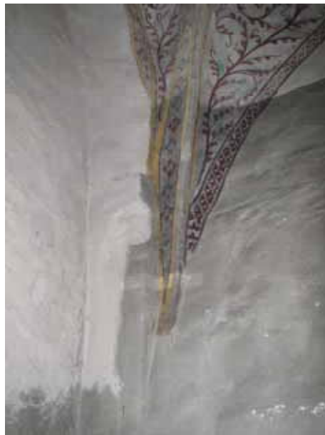
Tv. Västväggen med den nybyggda läktartrappan. Bården rengjordes och lämnades i övrigt som tidigare. Notera det smäckra trappräcket i svartmålade smide. Th. Svickeln i samma hörn behandlades på samma vis. De grå enfärgade ytorna målades in i den ljusa väggfärgen. Kalkmåleriet rengjordes och lämnades utan retuschering. Lp20100561 och Lp20100546.
