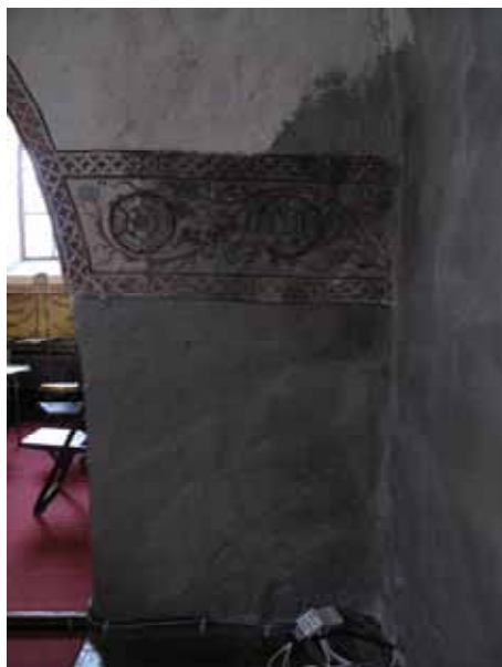
Tv. Västväggens bård som till stor del var rekonstruerat alternativt hårt restaurerat måleri. Th. Nordväggens bård var något mer välbevarad, men den anslutande draperimålningen från 1902 var bättrad med avvikande kulörer och bristande teknik. Lp20100544 och Lp20100545.
