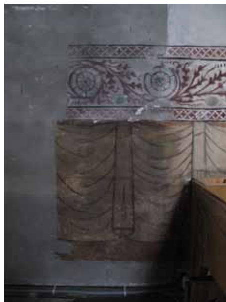
Tv. Västväggens bård som till stor del var rekonstruerat alternativt hårt restaurerat måleri. Th. Nordväggens bård var något mer välbevarad, men den anslutande draperimålningen från 1902 var bättrad med avvikande kulörer och bristande teknik. Lp20100544 och Lp20100545.
