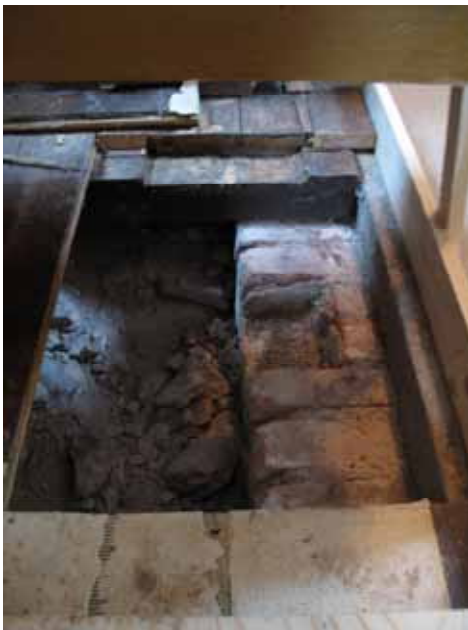
Tv. Till höger i bild syns den östvästliga tegelmuren i det förmodade gravrummet. Notera urtaget i murkrönet som troligtvis fungerat som upplag för en golvbjälke. Th. Epitafiet över traktören i Drottningholm från 1750 pryder Skå kyrka. Vid konserveringen återfick det brandskadade verket sitt forna ljusa ramverk. Lp20100547 och Lp20100556.
