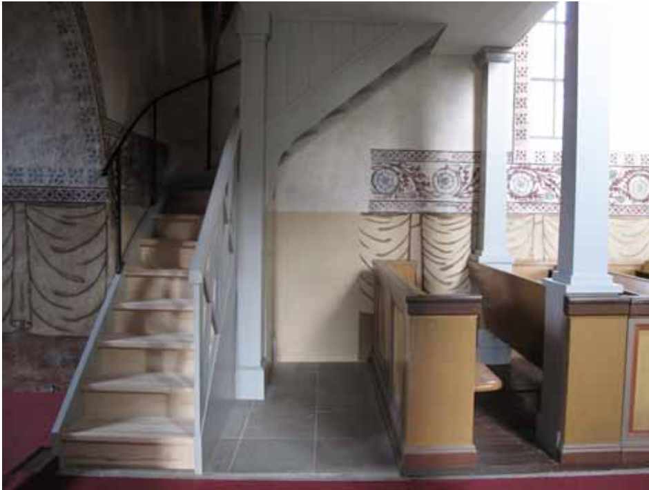
Nordväggen efter ombyggnad. Väggytorna närmast läktaren lämnades enfärgade, men ansluter nedtill med bröstning i samma bottenfärg som draperingen. Lp20100559.
