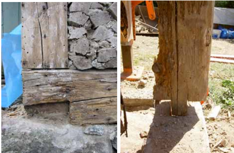
Th. Detalj av syllhorn i nordöst. Syllen är halvad och hörnstolpen ansluter med en sidoställd tapp. Th. Motsvarande hörnstolpe i sydöst med samma typ av tapp, sedd från insidan. Bildnr lp20100044 och lp20100045.
