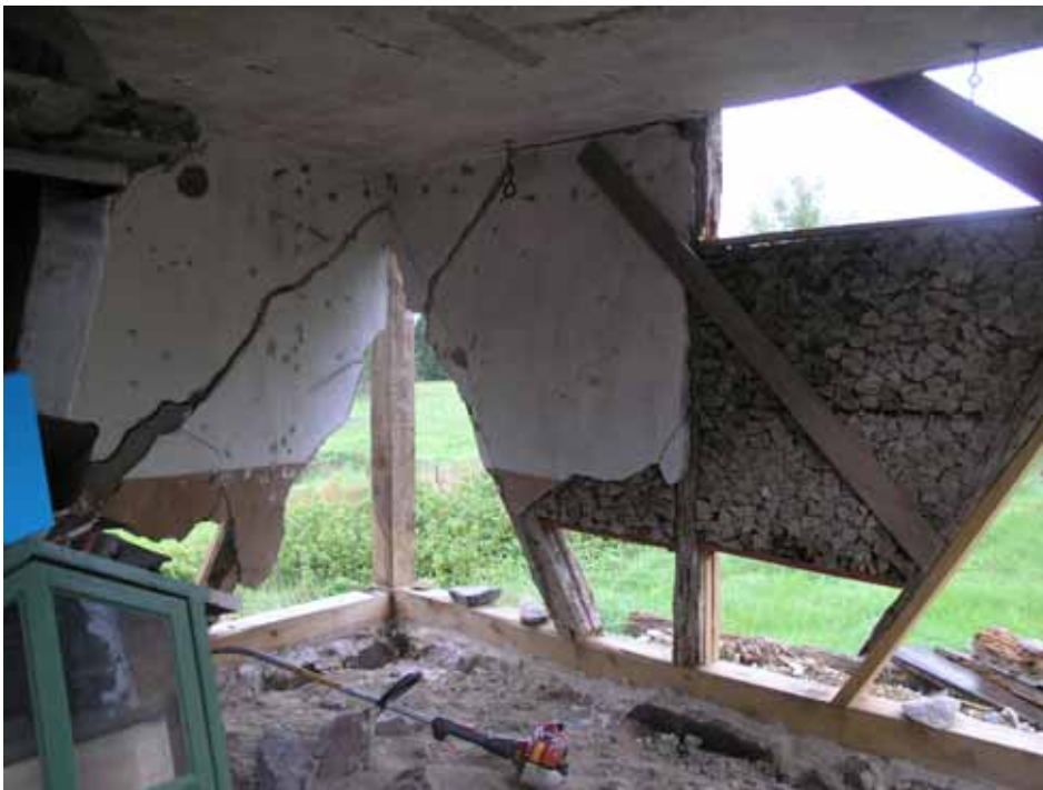
Stugan från sydöst under renovering. En stor del av kubbverket murades om. Bildnr lp20100040.
