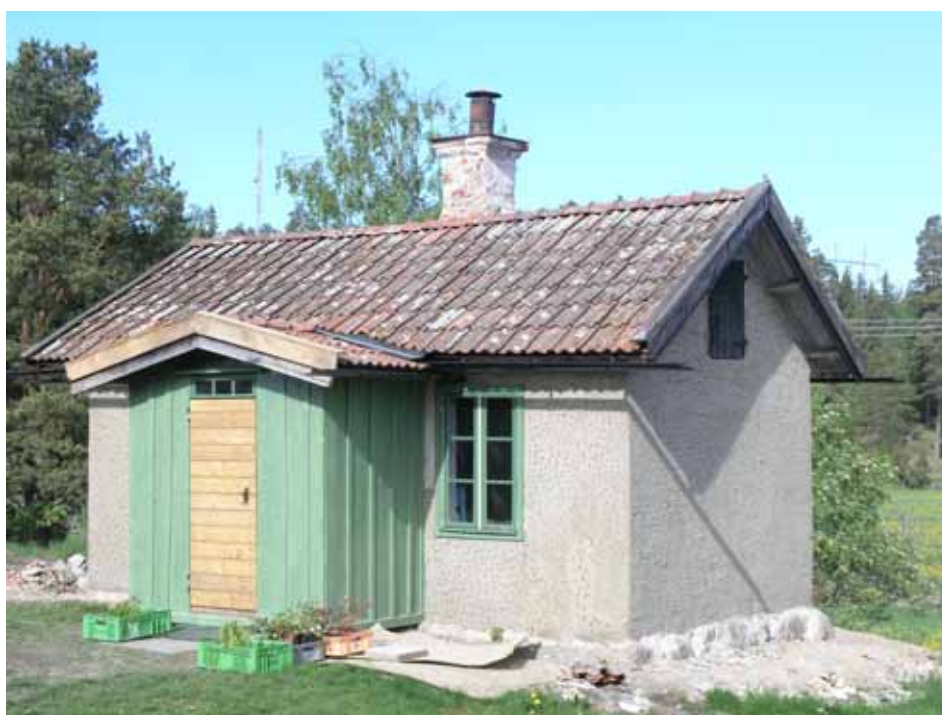
Vy över ett för putsning förberett kubbhus. Utstockning av lerbruk är påförd med slev. Ytan är prickad med kvist för att skapa bättre förutsättningar för kalkputsen att fästa. Bildnr lp20100036.
