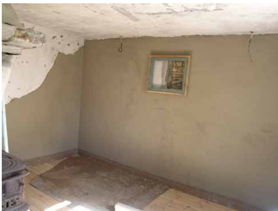
Stugan från sydöst efter renovering med nyputsade väggar. Bakom inramningen skymtar den underliggande stommens kubbverk. På golvet skymtar det nya brädgolvet. Bildnr lp20100042.
