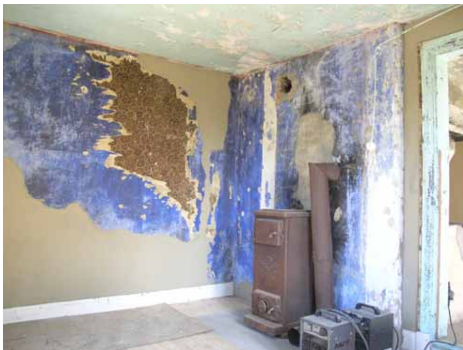
Kammaren från sydöst efter renovering. Väggarna är putslagade med lerbruk. De blå fälten är den ursprungliga putsen med två lager avfärgning och kvarvarande rester av rummets första tapet. En svartblommig variant på ofärgad botten. Bildnr lp20100038.
