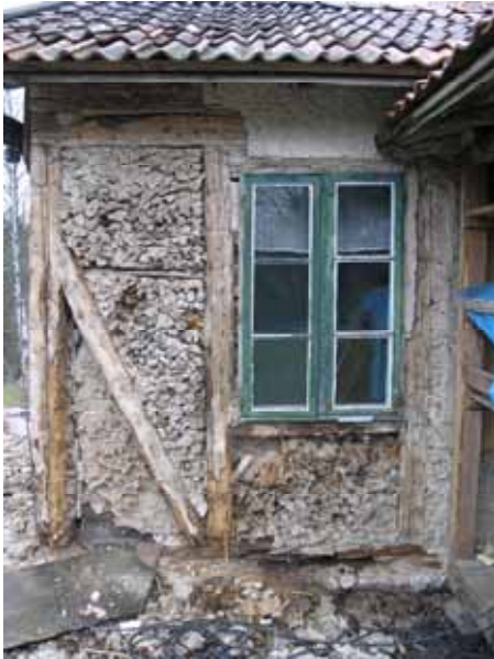
Tv. Östra långsidan hade omfattande rötskador i timmerstommen nedtill. Anslutande fackverk var också i dåligt skick. Kubben var rötskadad och murbruket vittrat. Th. Nytt kubbverk är under uppmurning. Bildnr lp20100023 och lp20100052.
