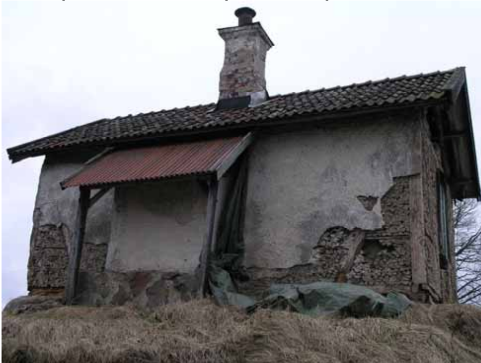
Västra långsidan före reparation. Plåttaket skyddar den utskjutande bakugnen. Bildnr lp20100020.
