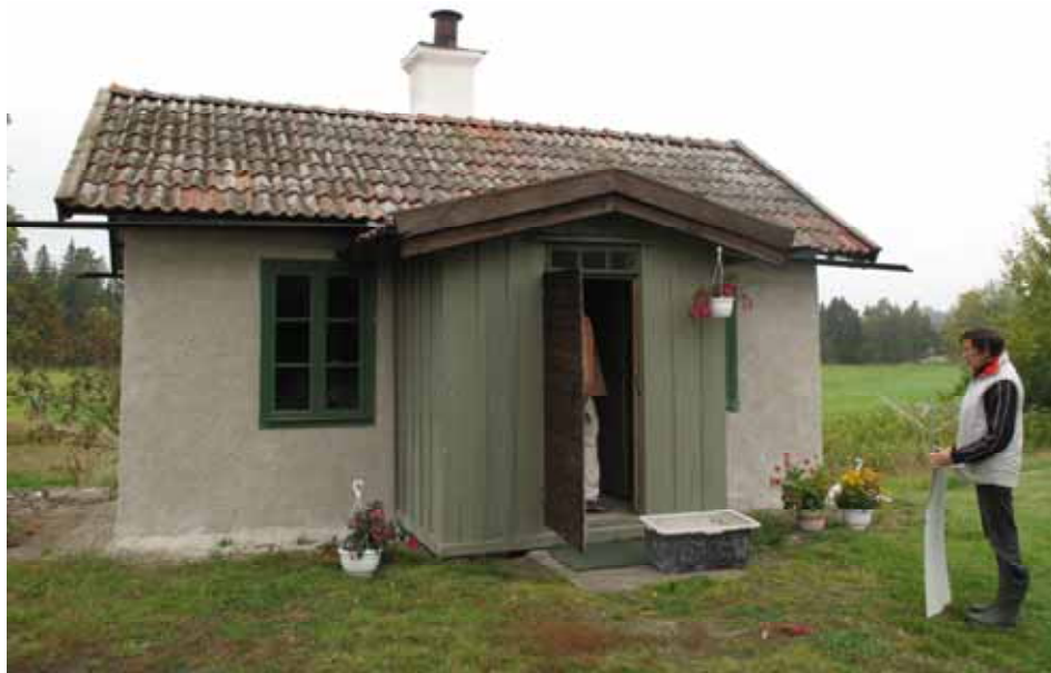
Kubhuset i ny kostym med spritputsade fasader, lagade fönster och nymålade snickerier. Fasaderna avfärgas först våren 2010. Bildnr lp20100053.
