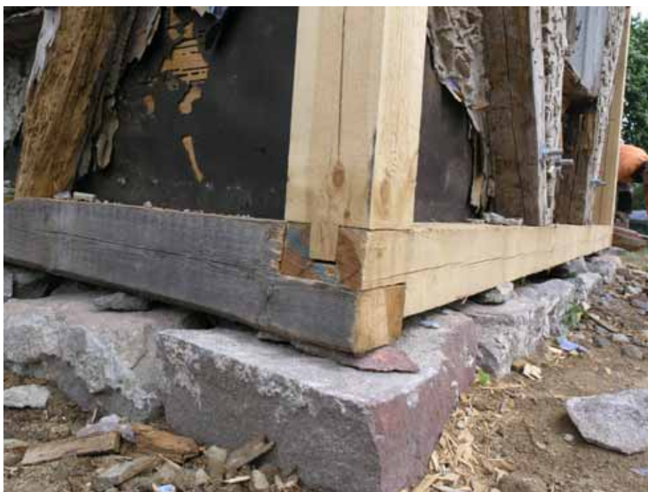
Nytt syllhorn i sydväst. Stolpens tappning utfördes med en i hörnet synlig tapp, istället för som tidigare med en inåtvänd, sidoställd tapp. Längsgående tappning förekom dock på de snedställda strävorna. Bildnr lp20100046
