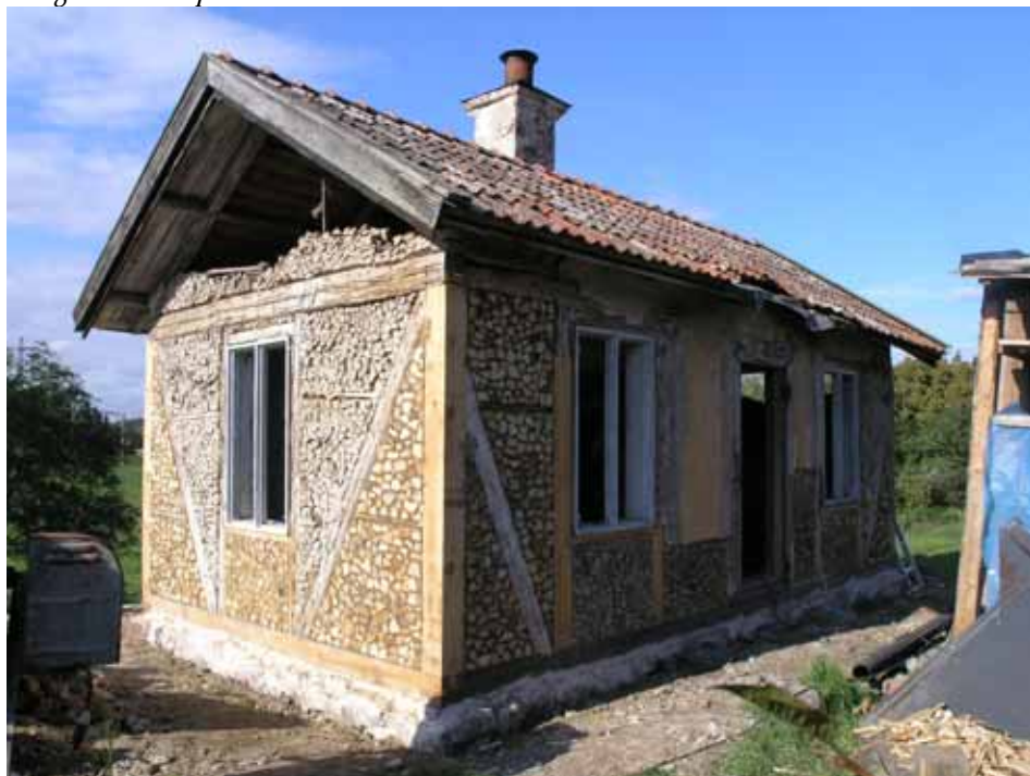
Vy från sydöst. Kubbverket är till stor del återställt. Bildnr lp20100030.
