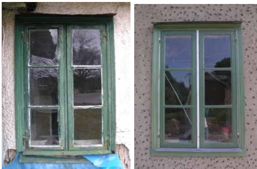
Tv. Fönster norr om entrén före renovering. Th Fönster efter renovering. Notera den omgivande väggen, vars prickade yta utgör utstockningen, underlag för den kommande ytputsen. Bildnr lp20100034 och lp20100035.
