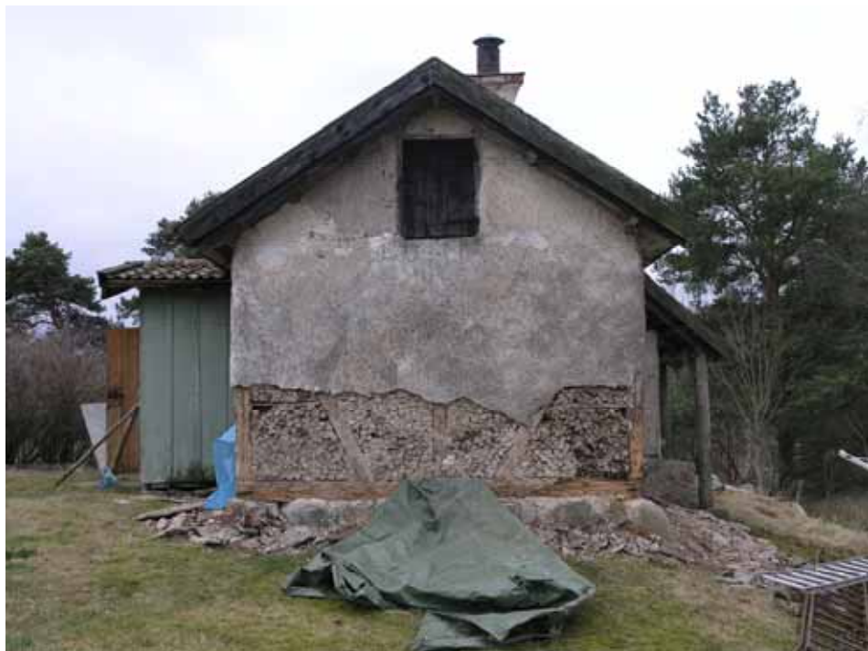
Norra gavelfasaden före reparation. Bildnr lp20100022.
