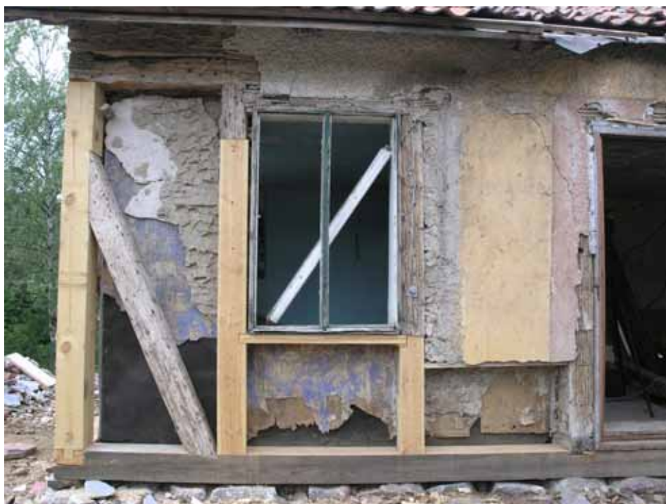
Östfasaden söder om entrén under reparation. Skadat timmer i stommen är utbytt. Hela syllen och tre anslutande stolpar. Tömnda fack murades om Bildnr lp20100025.
