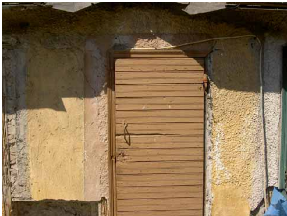
Dörr med omgivande väggparti som ingår i farstukvistens interiör. Det beige fältet till vänster om dörren utgör farstuns väggfärg. De gula fälten på bägge sidor om dörren är färg tillhörande farstuns skåpinredning. Bildnr lp20100048
