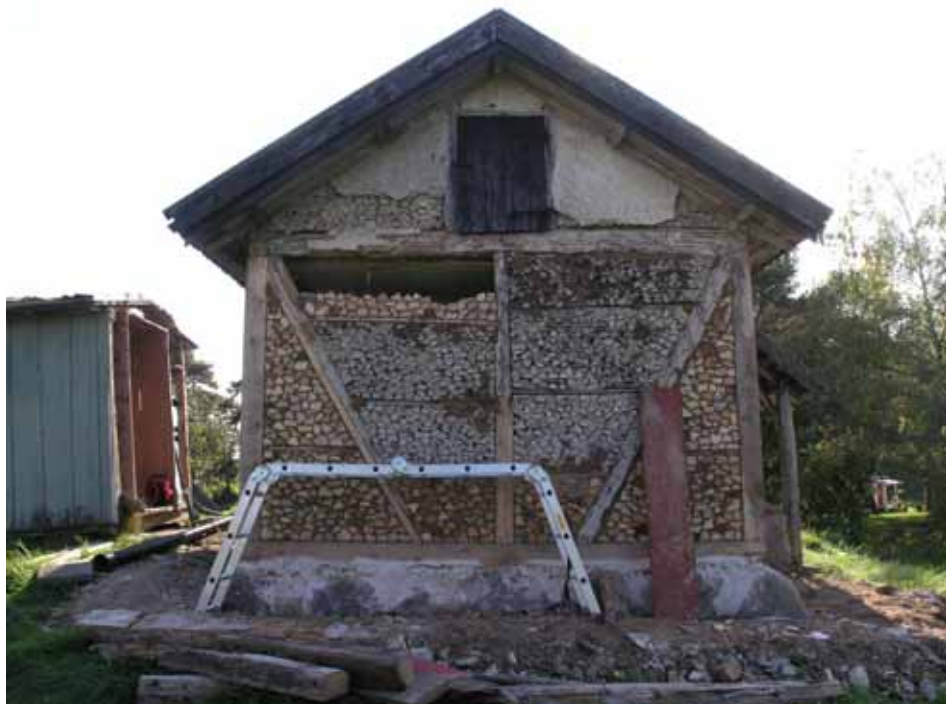
Norra gavelfasaden under pågående murning. Bevarat timmer och kubbverk är mer gråaktigt i färgen. Bildnr lp20100029.
