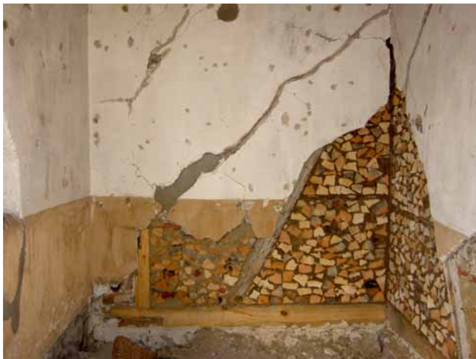
Stugans inre vägg med nymurat kubbverk. Bildnr lp20100041.
