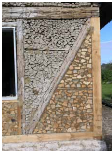
Tv. Det södra gavelpartiet är återställt med ursprunglig fönstersättning. Th. Detaljbild av samma fackverket på samma fasad. Bevarat kubbverk är gråaktigt. Bildnr lp20100032 och Bildnr lp20100033.
