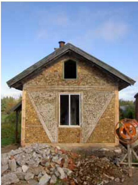
Tv. Det södra gavelpartiet är återställt med ursprunglig fönstersättning. Th. Detaljbild av samma fackverket på samma fasad. Bevarat kubbverk är gråaktigt. Bildnr lp20100032 och Bildnr lp20100033.
