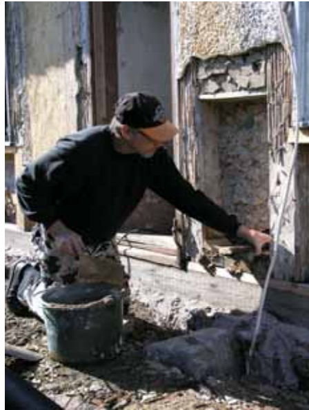
Tv. Östra långsidan hade omfattande rötskador i timmerstommen nedtill. Anslutande fackverk var också i dåligt skick. Kubben var rötskadad och murbruket vittrat. Th. Nytt kubbverk är under uppmurning. Bildnr lp20100023 och lp20100052.
