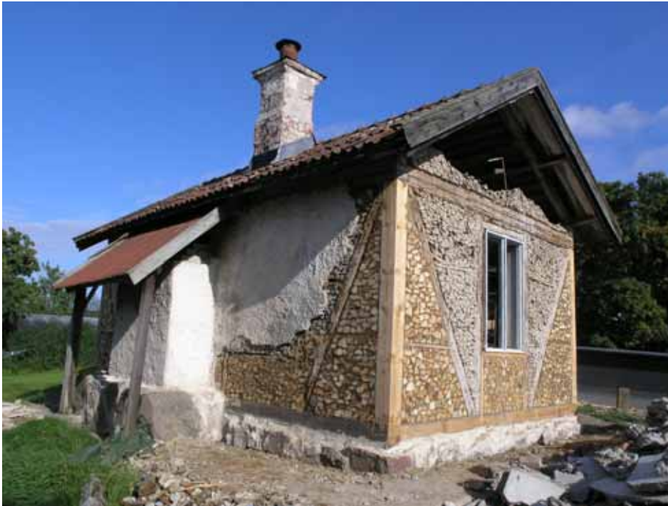
Vy från sydväst med nymurat kubbverk. Bevarat kubbverk finns bakom puts och i gavelfasadens mitt. Bildnr lp20100031.
