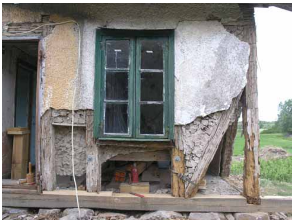
Östfasaden norrut under reparation. Syllen är inpassad men inte slutförd. Anslutande stolpar reparerades nedtill. Tömnda fack murades om. Bildnr lp20100026.
