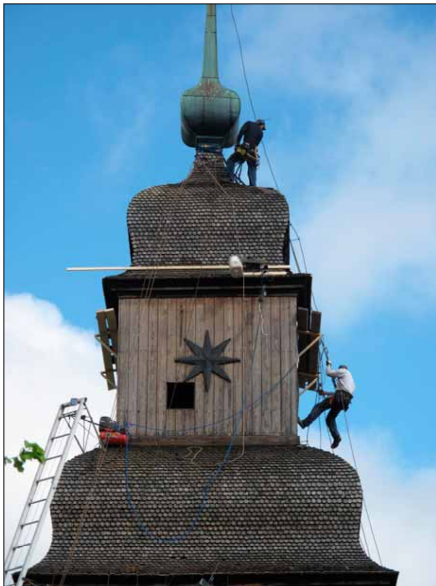
Då renoveringsarbetena utfördes med bergsbestigarutrustning behövdes inte ställningar.
