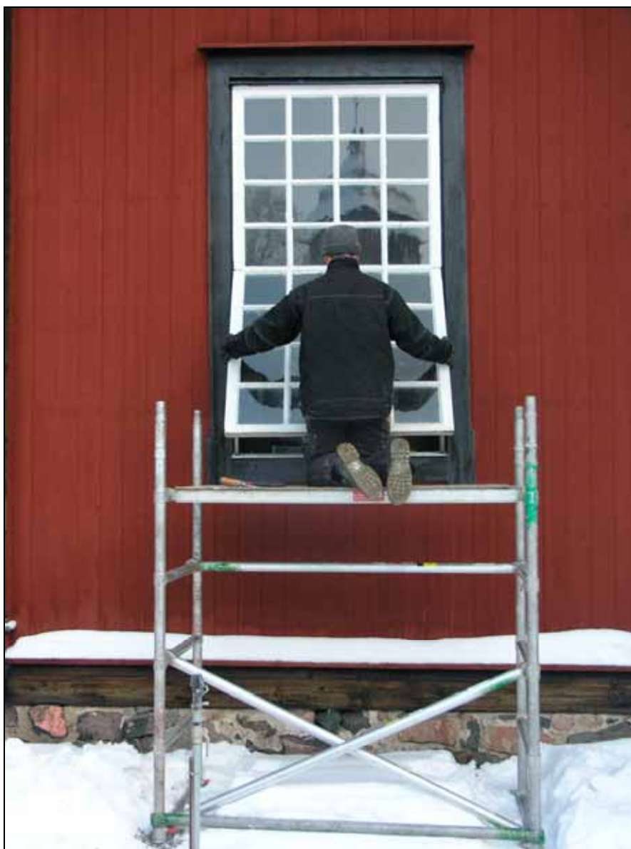
Fönsterna demonterades för renovering på verkstad.
