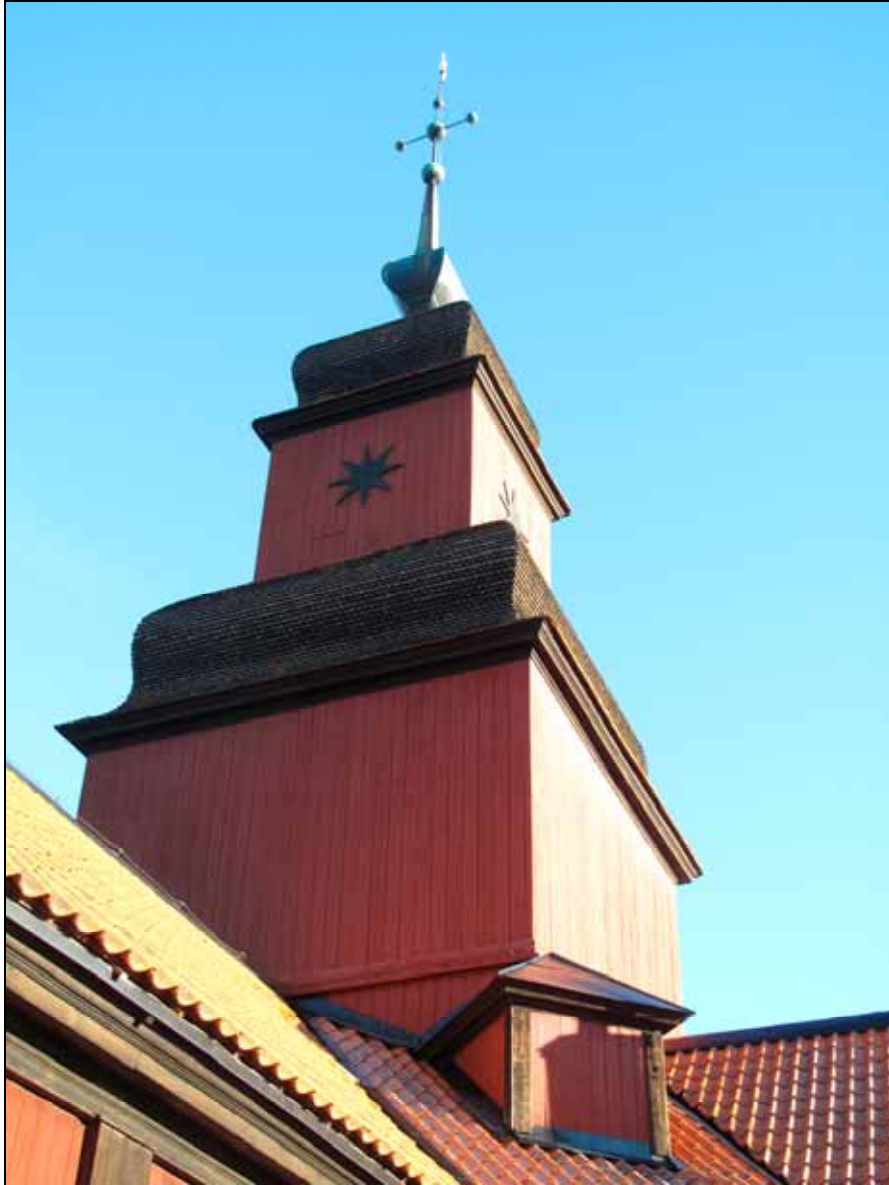
Kyrkans torn efter renovering av takspån och ommålning av tornfasaderna.
