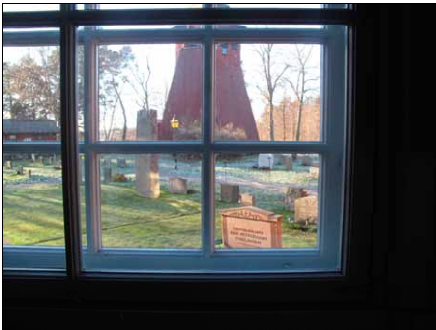
Fönster efter renovering.
