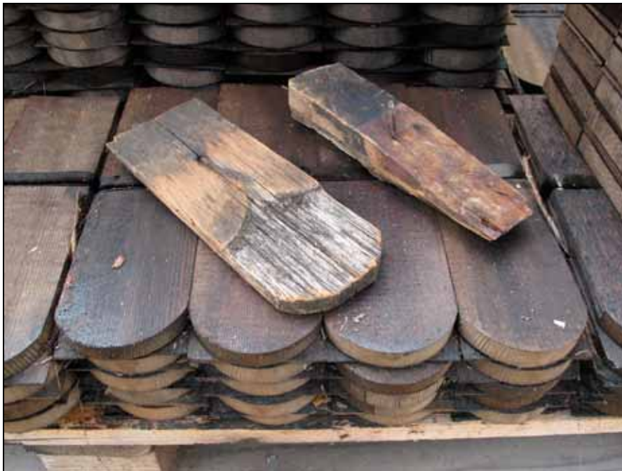
Spån i dåligt skick ersattes av nya lika befintliga.
