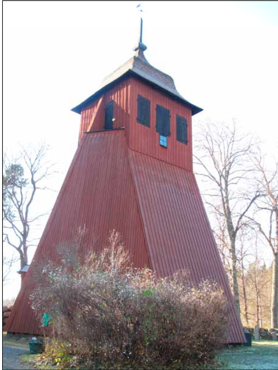
Klockstapeln efter byte av takspån.
